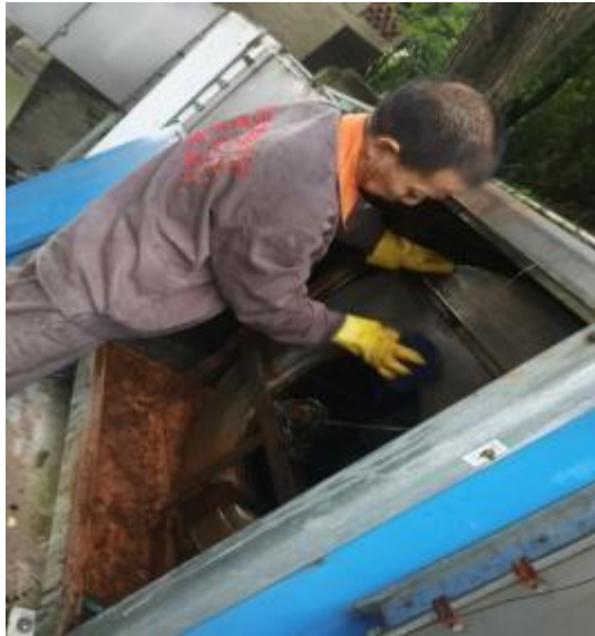
出风口施工中
