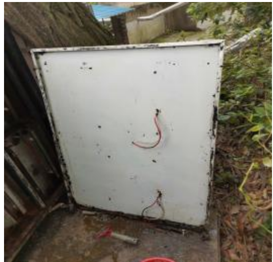
净化器施工中 1
