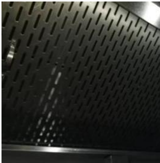
防火板清洗前
