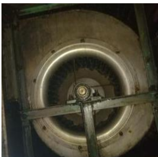
员工厨房风机清洗后 2
