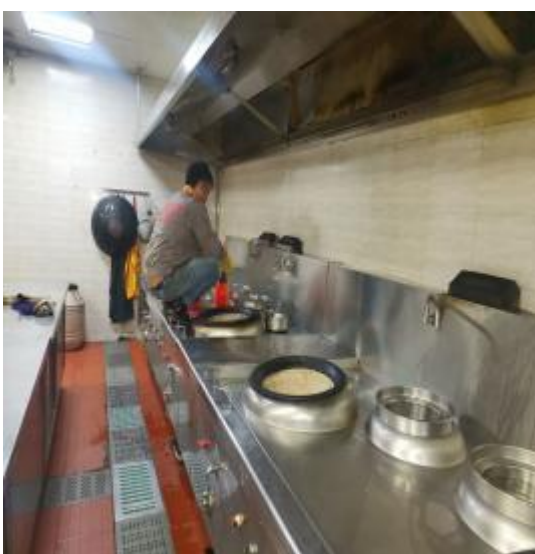
中厨房管道施工
