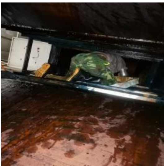
西厨房净化器机箱施工中
