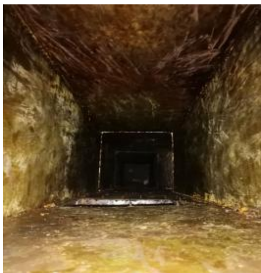
西厨房管道清洗后
