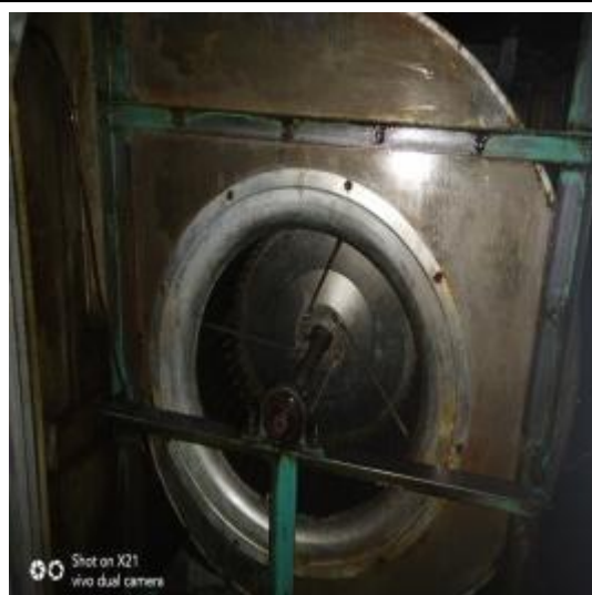
宴会厨房风机清洗后 1
