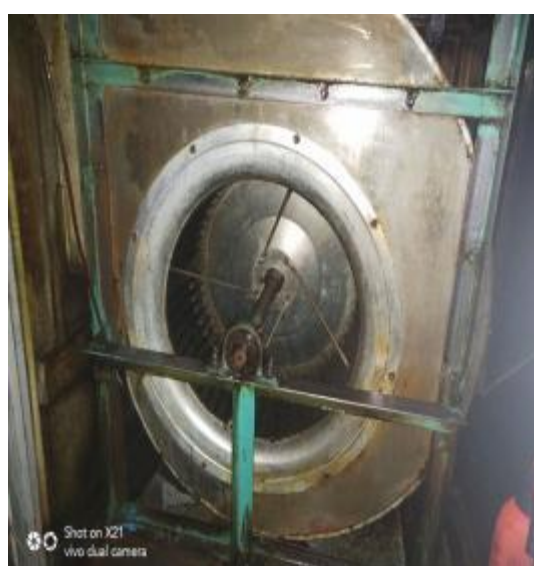
宴会厨房风机清洗后 2
