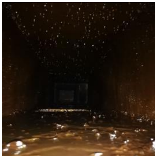
员工厨房管道清洗前 1
