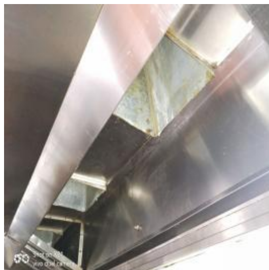
宴会厨房烟罩清洗后 2
