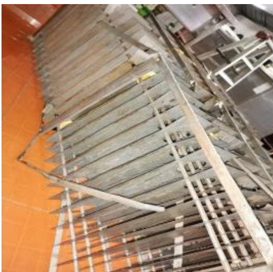
中厨房净化器清洗后
