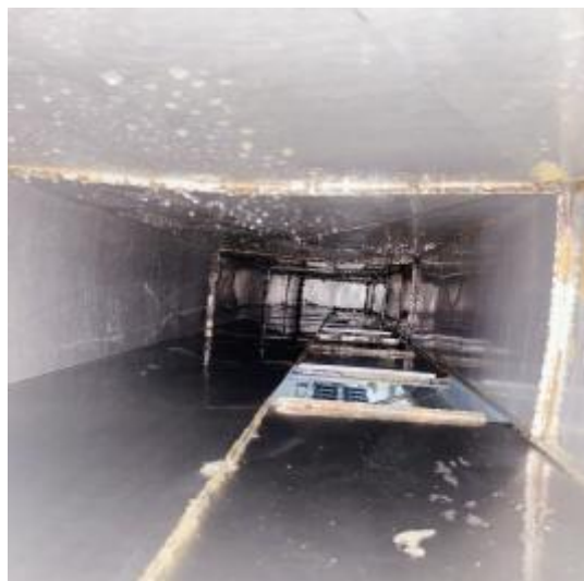
中厨房管道清洗后
