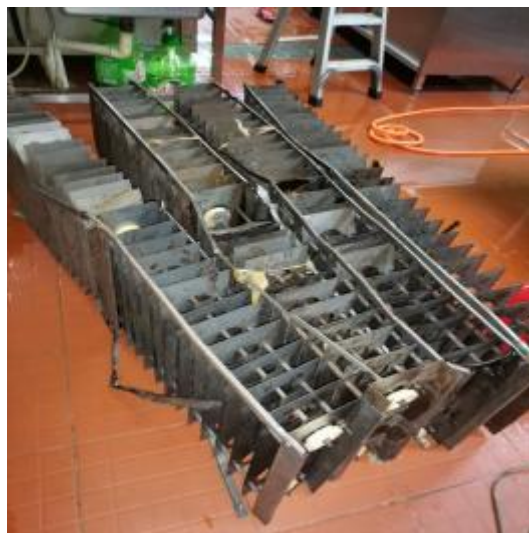
西厨房净化器清洗后
