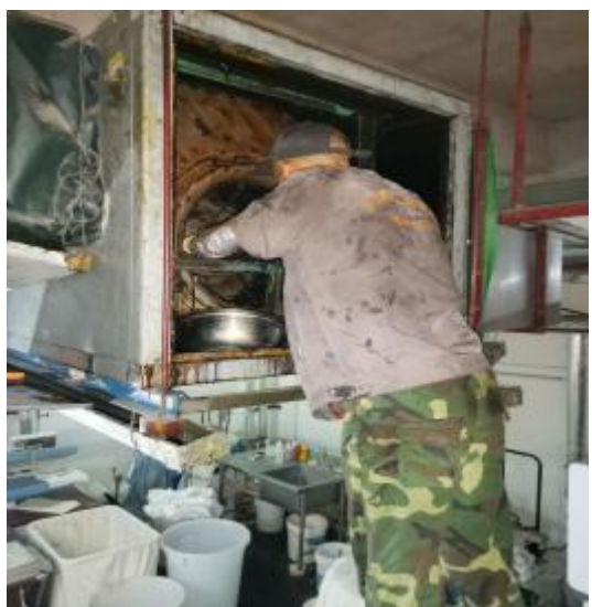
员工厨房风机施工中
