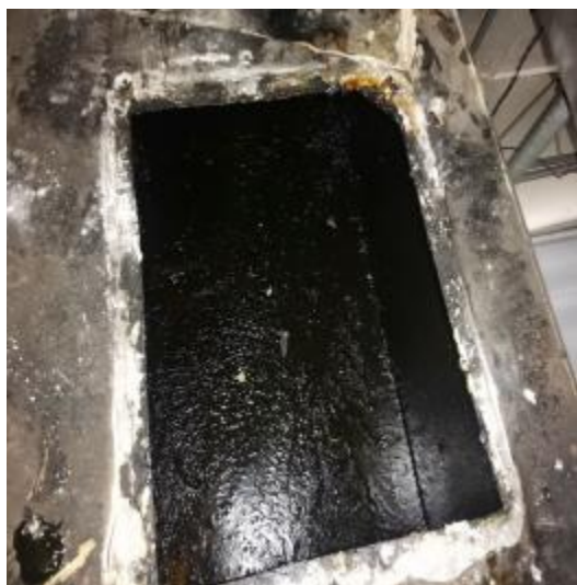
西厨房管道清洗前
