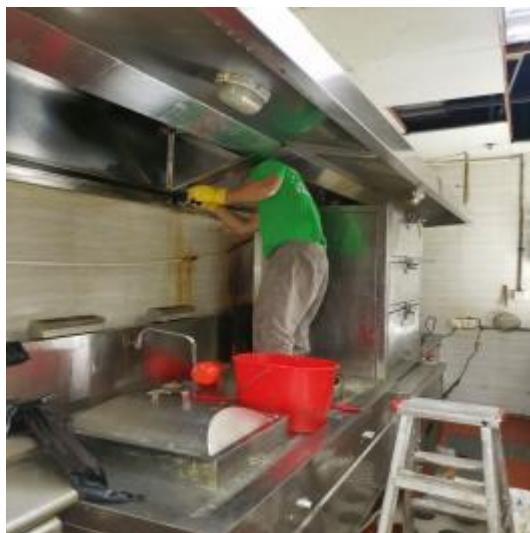
西厨房烟罩施工中
