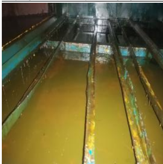
中厨房净化器机箱清洗前
