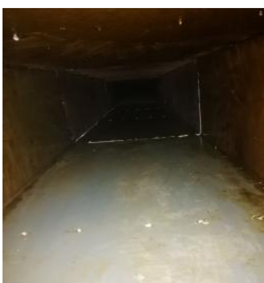
员工厨房管道施工 2
