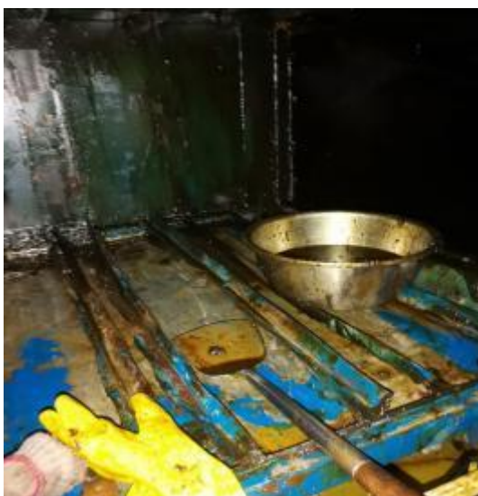
员工厨房净化器机箱施工中
