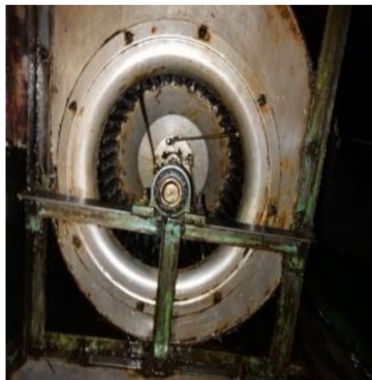
员工厨房风机清洗后 1
