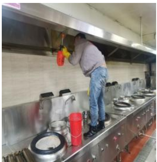
中厨房烟罩施工
