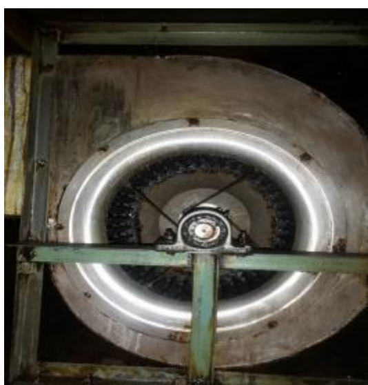
西厨房风机清洗后 1
