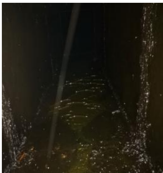
西厨房管道清洗前
