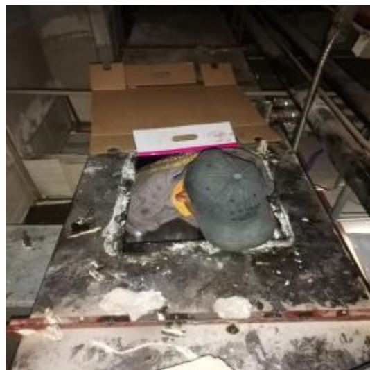
西厨房管道施工中
