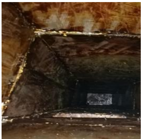
宴会厨房管道清洗前
