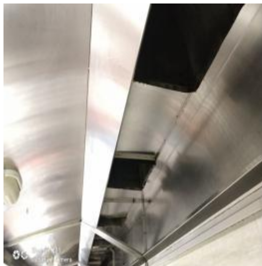
宴会厨房烟罩清洗后 1
