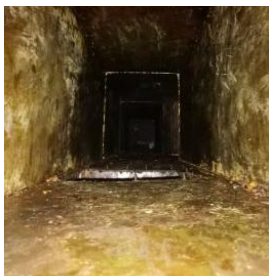
员工厨房管道清洗后 1
