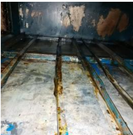
西厨房净化器机箱清洗后
