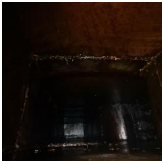
中厨房管道清洗前
