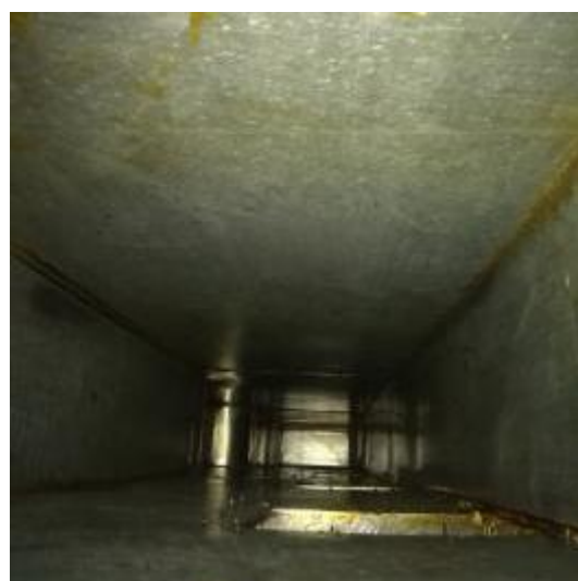
宴会厨房管道清洗后
