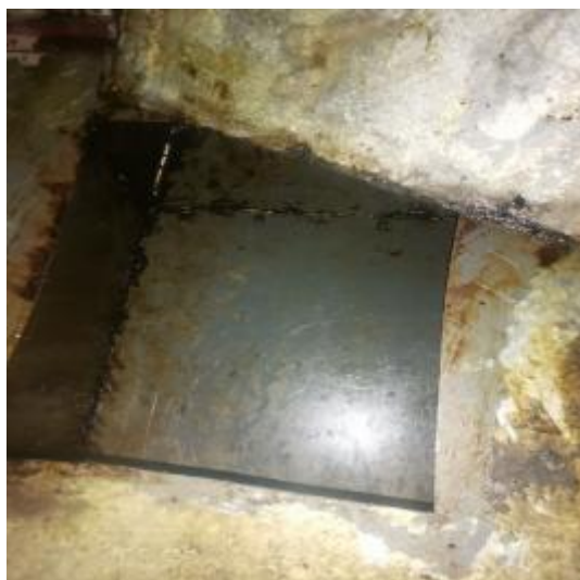
西厨房管道清洗后
