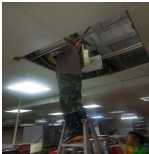
西厨房风机施工中
