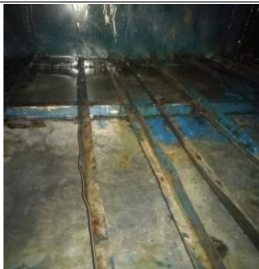
中厨房净化器机箱清洗后
