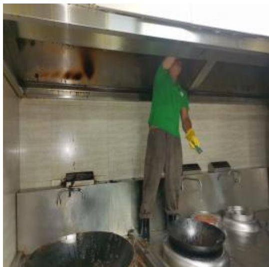
员工厨房烟罩清洗中
