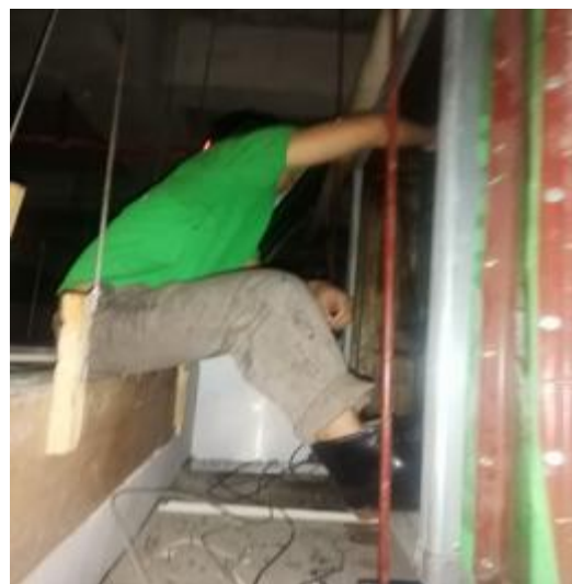
中厨房风机施工中
