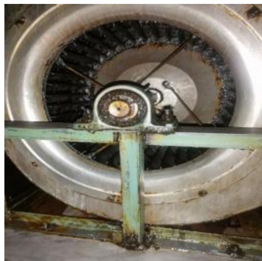
中厨房风机清洗后
