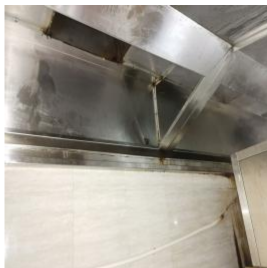
西厨房烟罩清洗后 1
