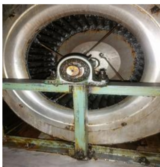
西厨房风机清洗后 2
