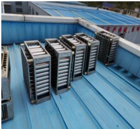
净化器施工中
