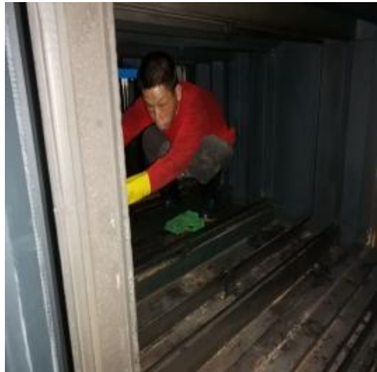
净化器机箱施工中
