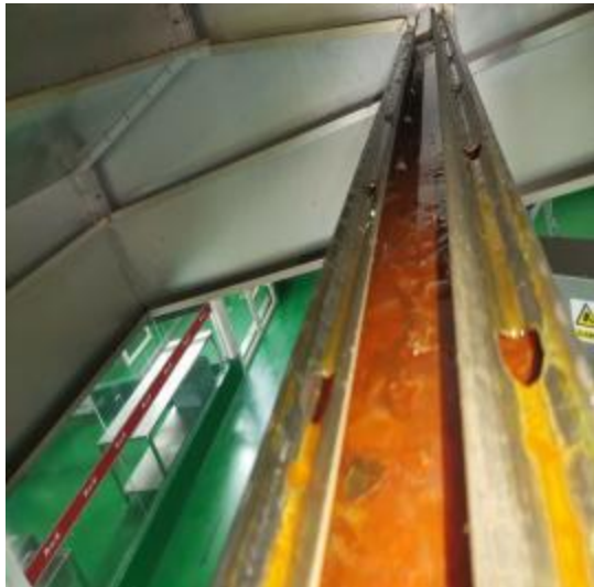
烟罩油槽清洗前
