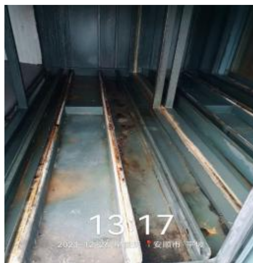
净化器施工中
