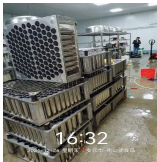
净化器施工中
