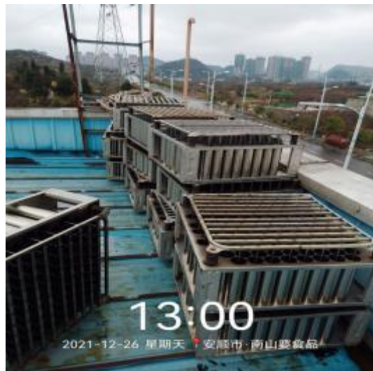
净化器施工中
