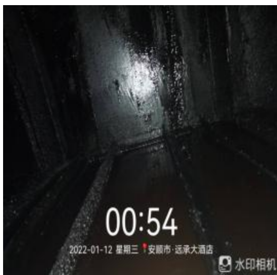
净化器机箱清洗前
