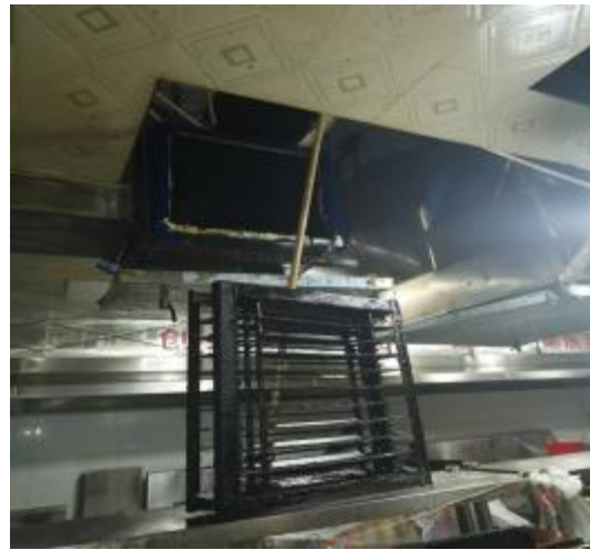
净化器机箱施工中
