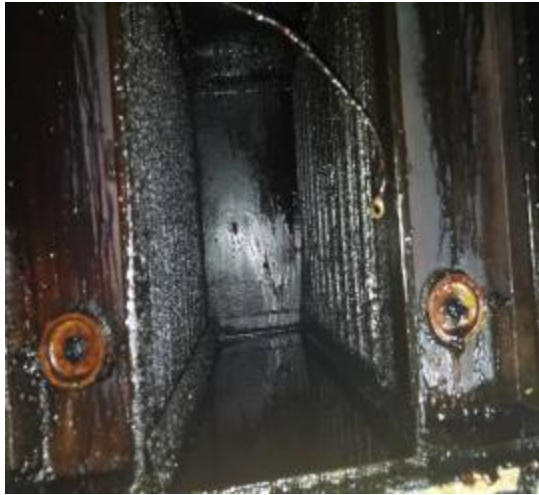
净化器机箱清施工中
