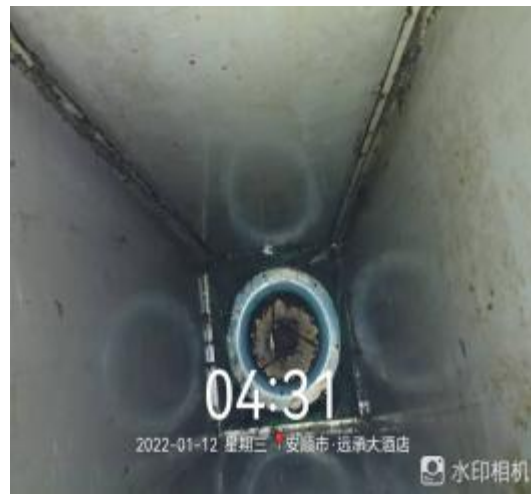
风机管道清洗后
