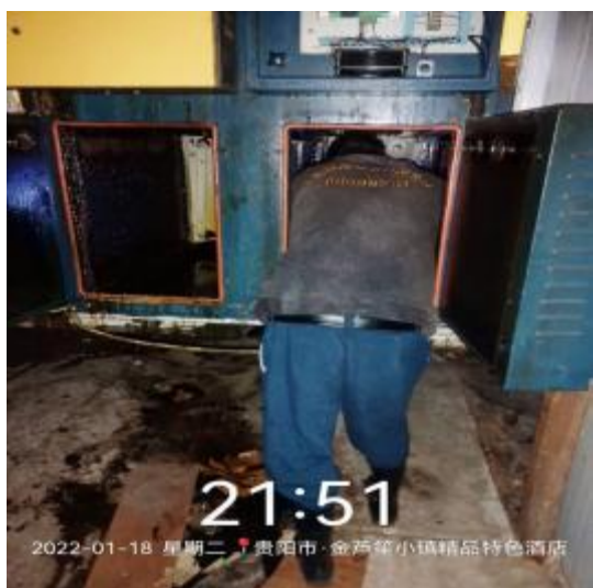
净化器机箱清洗中
