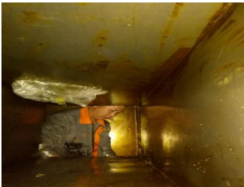
油烟管道内部施工
