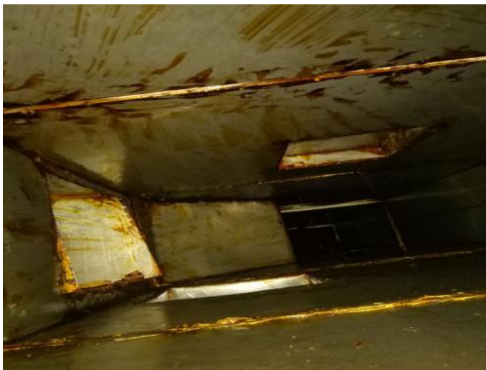
油烟管道清洗后
