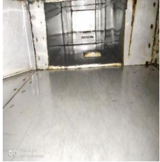
中厨房管道清洗后 3
