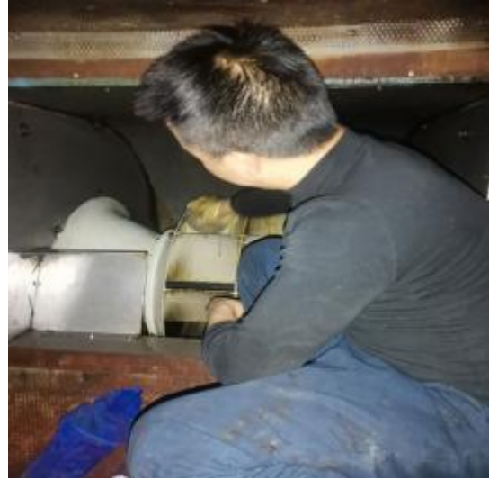
楼顶风机施工中
