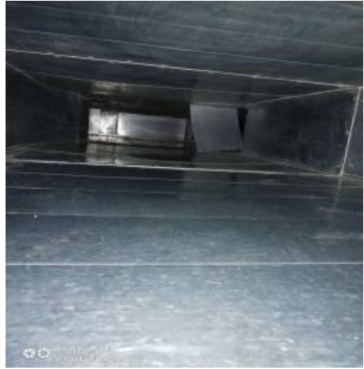
洗衣房管道清洗后 1
