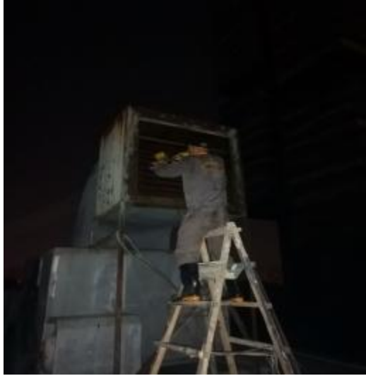
楼顶风机施工中
