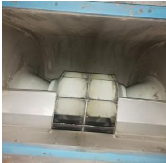
楼顶风机清洗中 1
