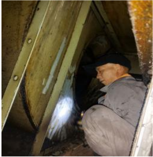
楼顶风机施工中
