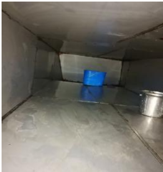
西厨房管道清洗中
