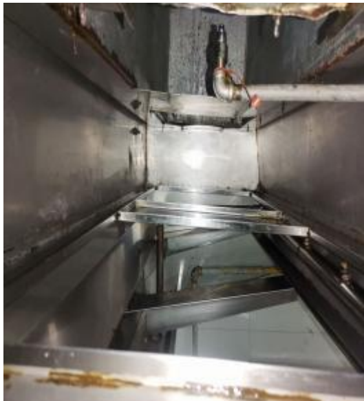
会所厨房管道洗后 2
