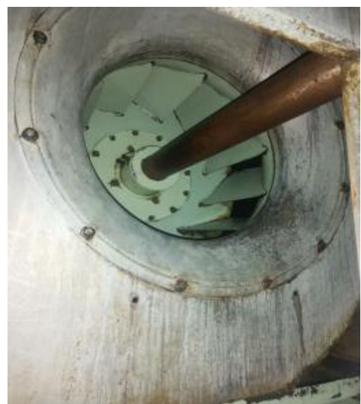
楼顶风机清洗后 2
