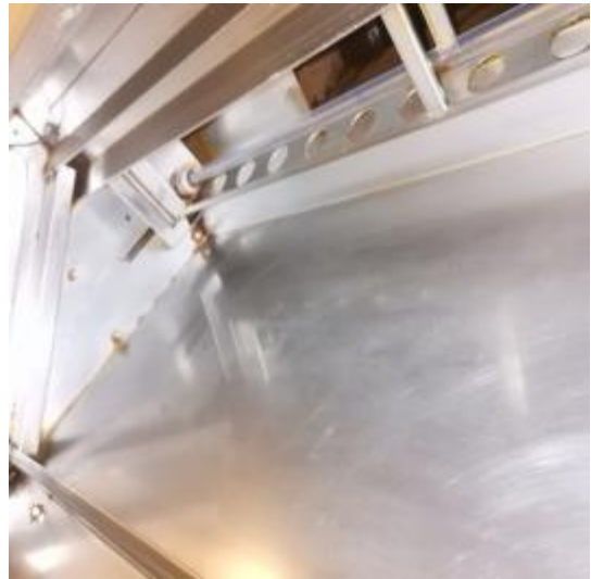
西厨房烟罩清洗后 2
