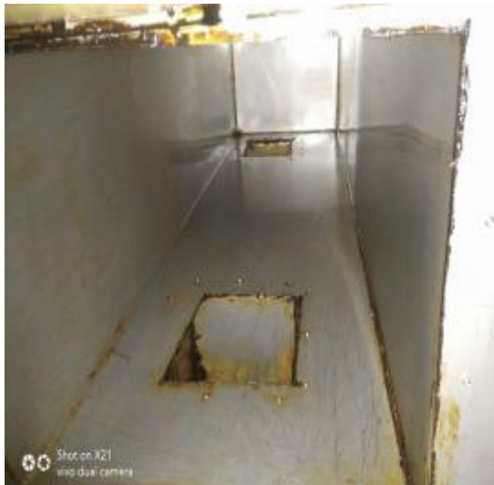
中厨房管道清洗后 1
