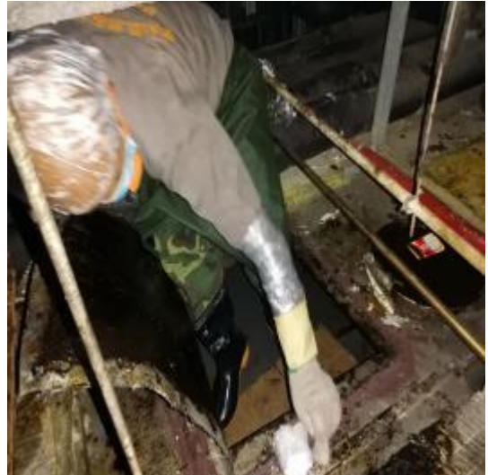
西厨管道施工中
