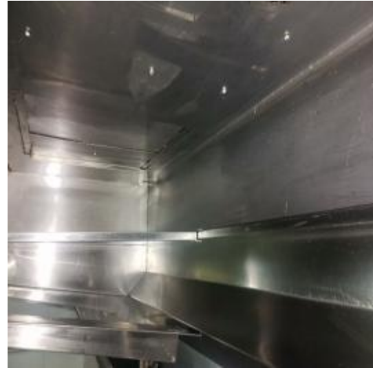
中厨房管道清洗后
