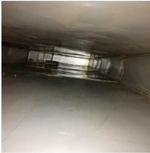
会所厨房管道洗后 1
