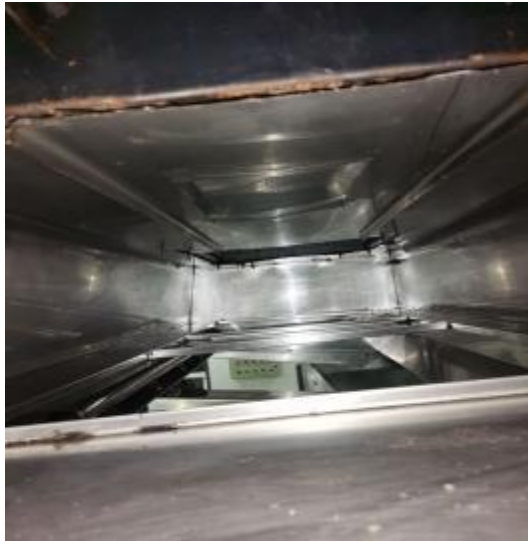
宴会厨房管道清洗后
