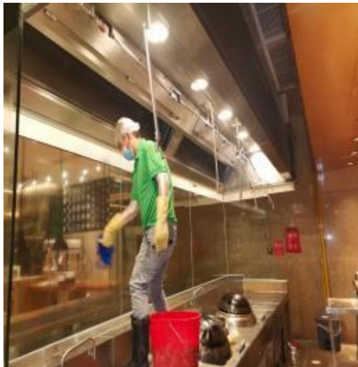
西厨房烟罩清洗中
