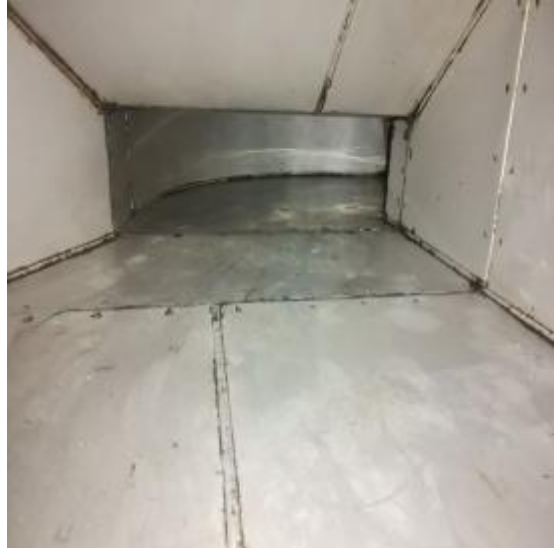
西厨房管道清洗后
