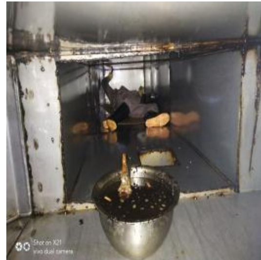
中厨房管道施工中
