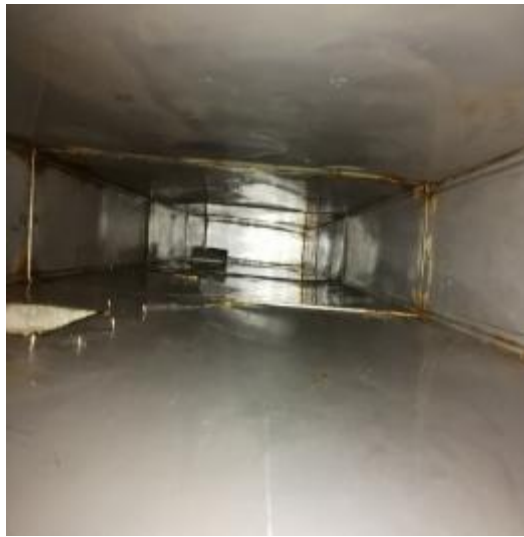
会所厨房管道清洗后 1
