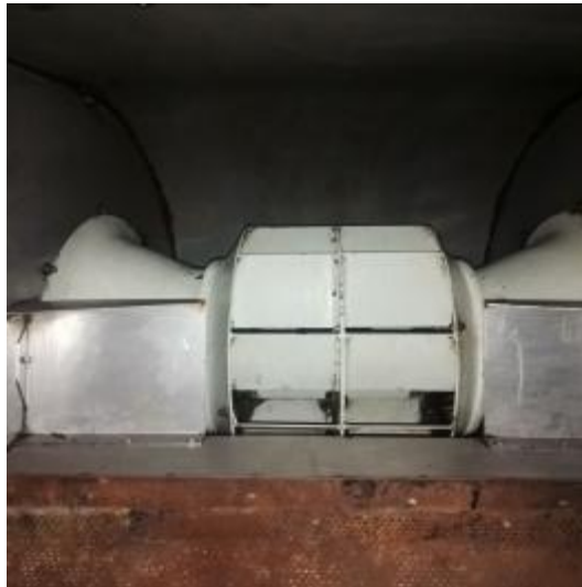
楼顶风机清洗后 1
