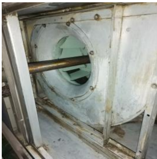
楼顶风机清洗 3
