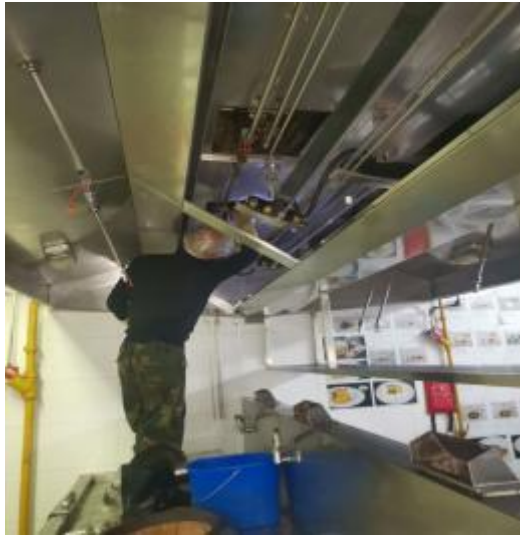
咖啡厅厨房烟罩清洗中
