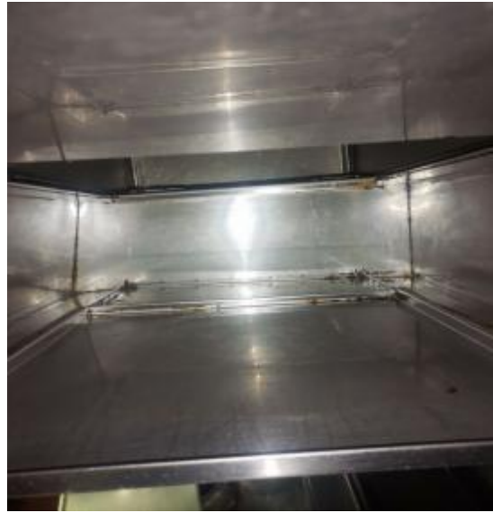
中厨房管道清洗后
