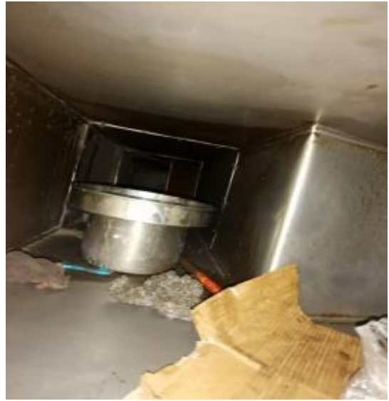
宴会厨房管道清洗中
