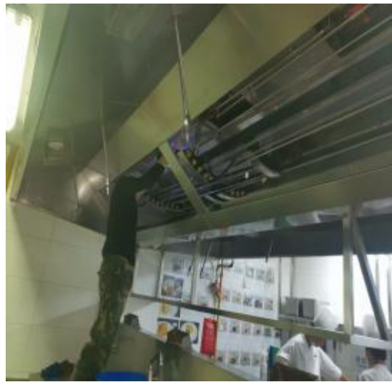
咖啡厅厨房烟罩清洗中
