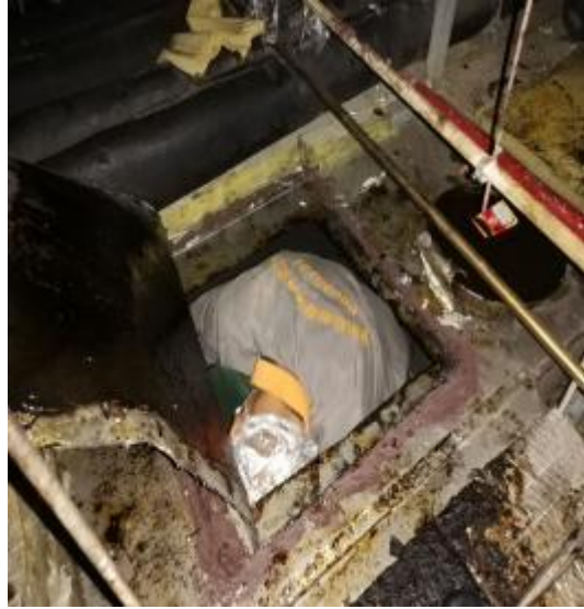
西厨房管道清洗中
