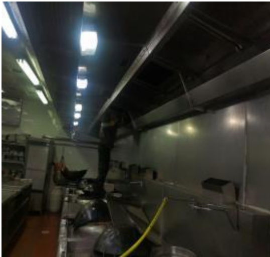
中厨房烟罩清洗中
