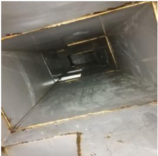
宴会厨房管道清洗后
