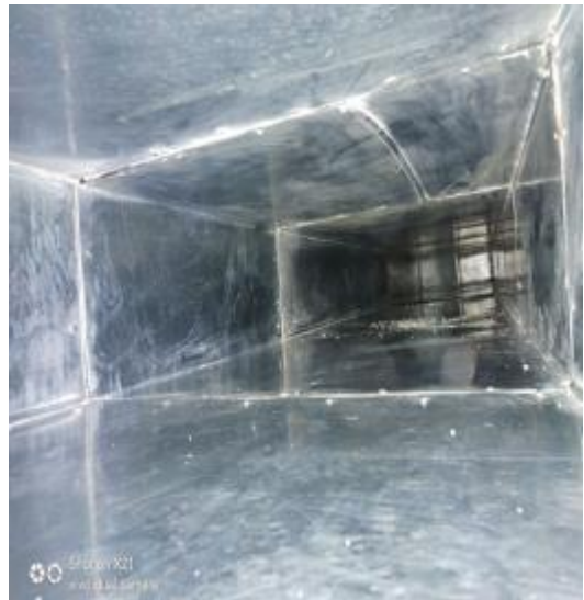
洗衣房管道清洗后 2
