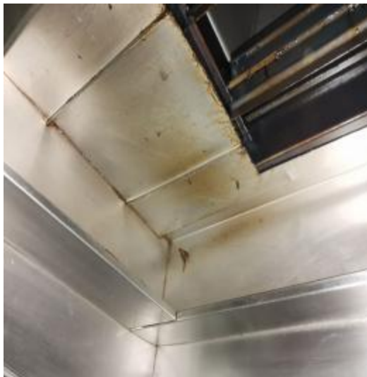
宴会厨房烟罩清洗前
