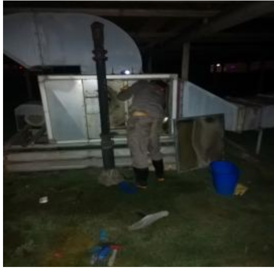
楼顶风机施工中
