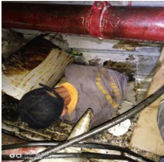
中厨房管道施工中 1
