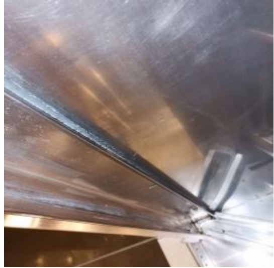
西厨房烟罩清洗后 1
