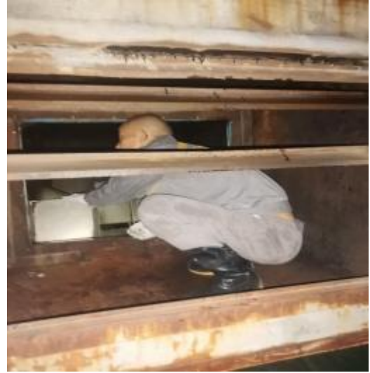
楼顶风机清洗中 1
