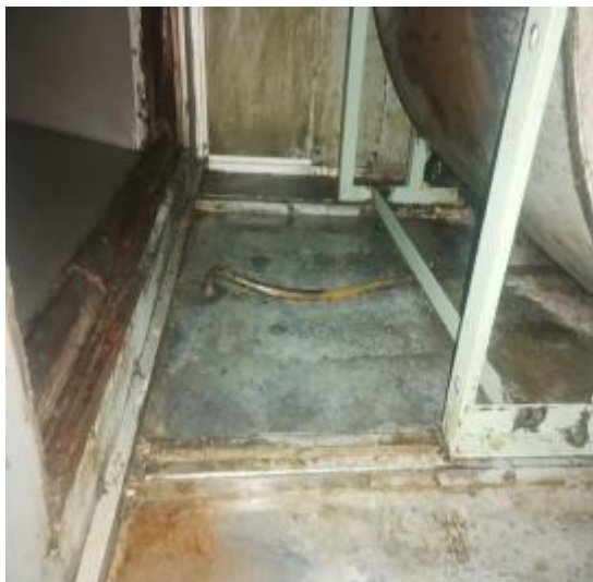
楼顶风机清洗后 4
