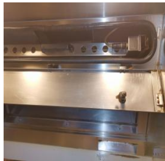
西厨房烟罩清洗后
