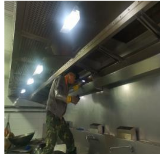
中厨房管道清洗中
