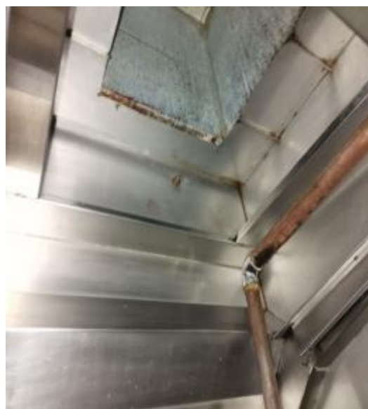
会所厨房管道洗后 2
