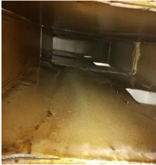
会所厨房管道清洗前 1
