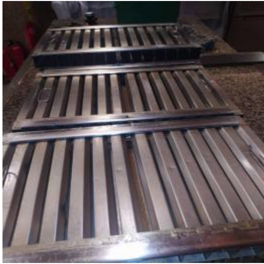
咖啡厅厨房挡板清洗前
