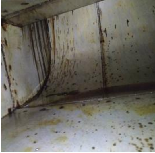
中厨房主管道清洗前
