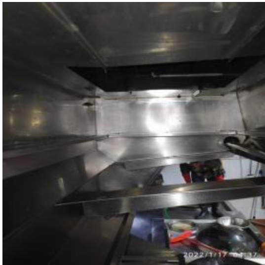
员工厨房烟罩清洗中
