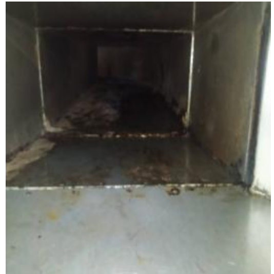
员工厨房主管道清洗后
