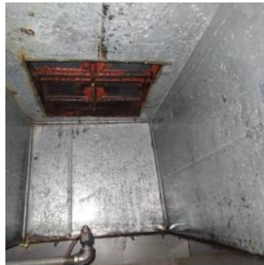
会所厨房管道清洗后
