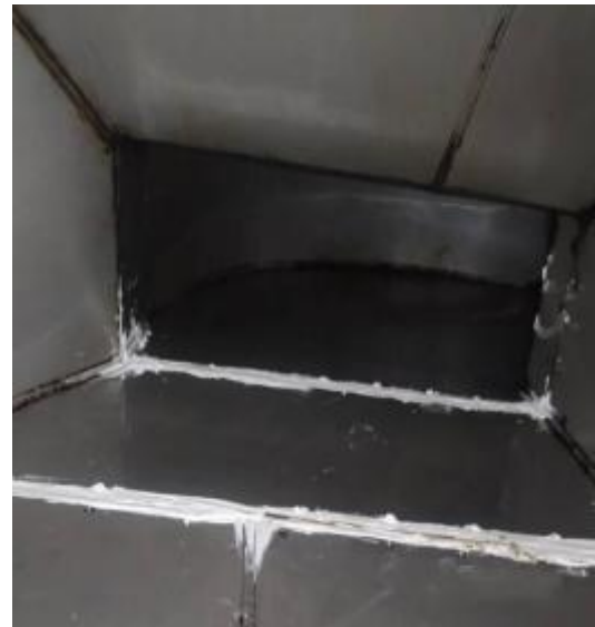
宴会房主管道清洗后
