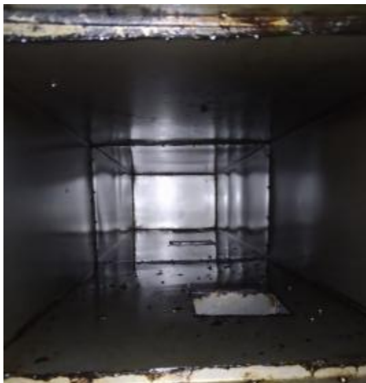
中厨房主管道清洗前
