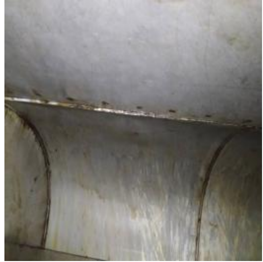
中厨房主管道清洗后
