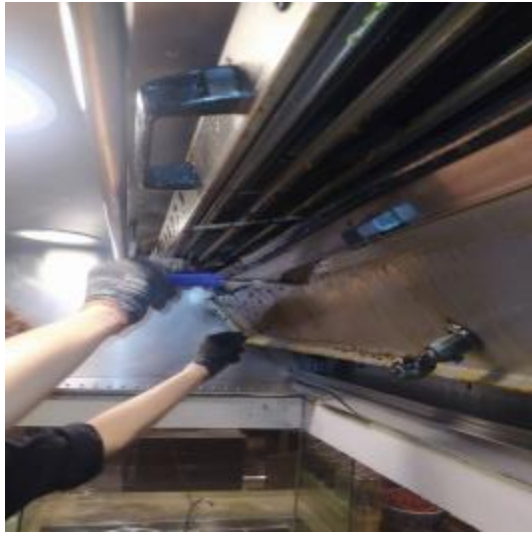
咖啡厨房明档烟罩清洗前
