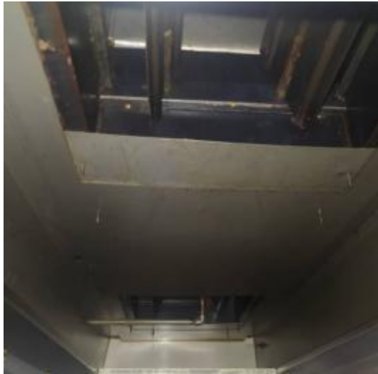
宴会厨房烟罩清洗前
