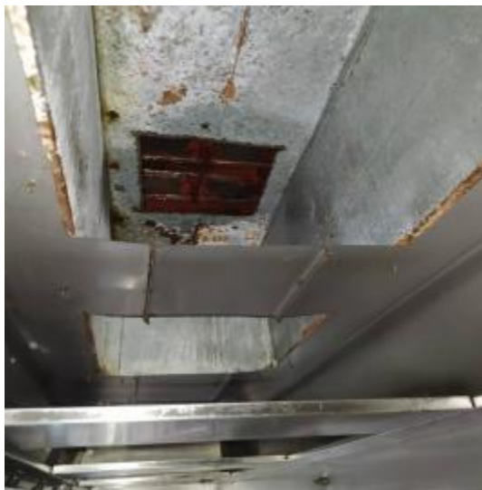
会所厨房管道清洗前
