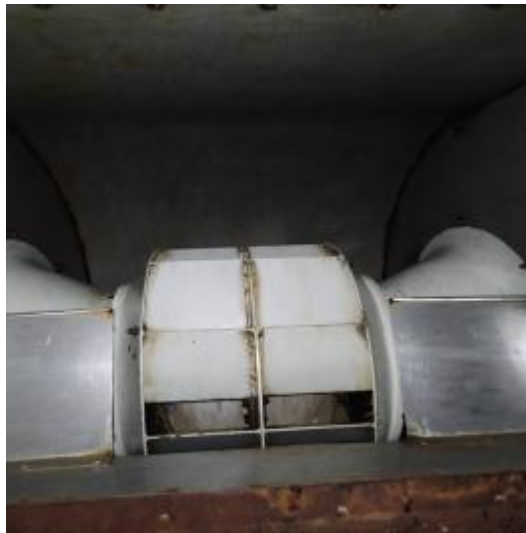
楼顶风机清洗后 1
