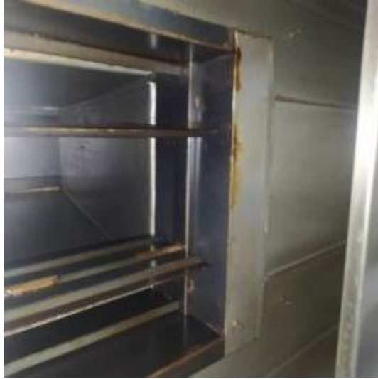
宴会厨房道清洗前
