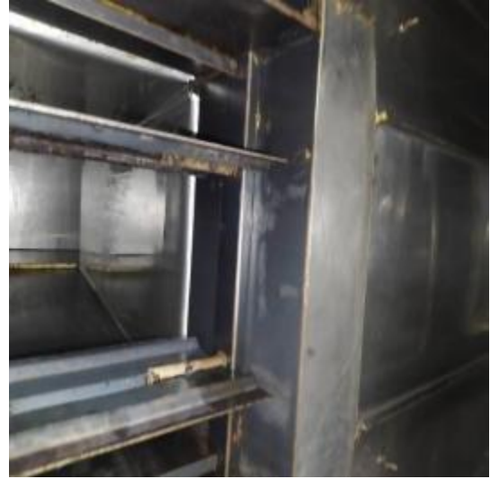
宴会厨房管道清洗后
