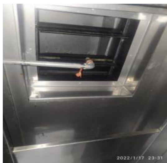
热辣厨房管道清洗后
