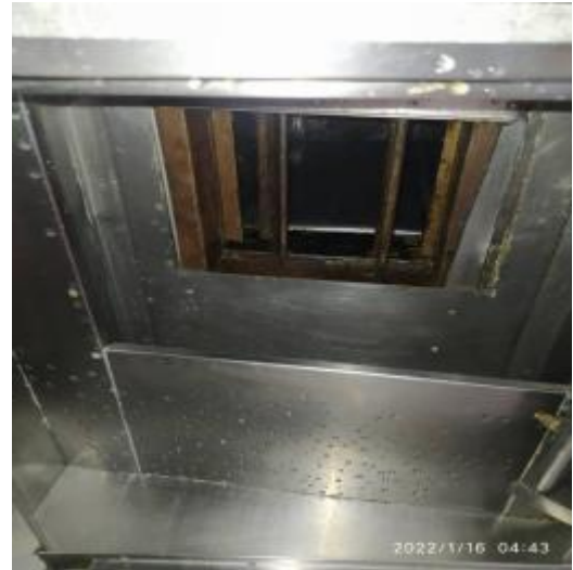
中厨房管道清洗后
