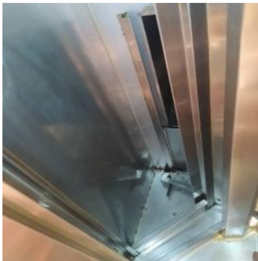
咖啡厨房明档烟罩清洗前
