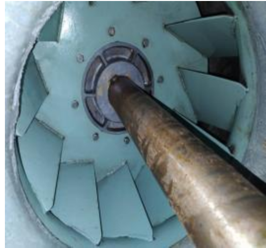
楼顶风机清洗后 4
