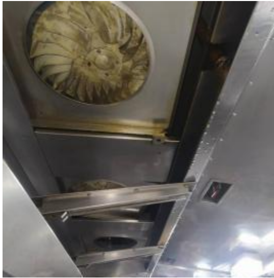
宴会厨房烟罩清洗前
