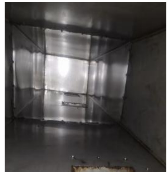
中厨房主管道清洗后
