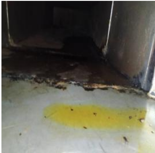
员工厨房主管道清洗前
