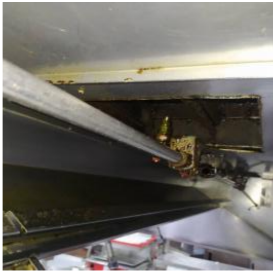
咖啡厅厨房管道清洗前
