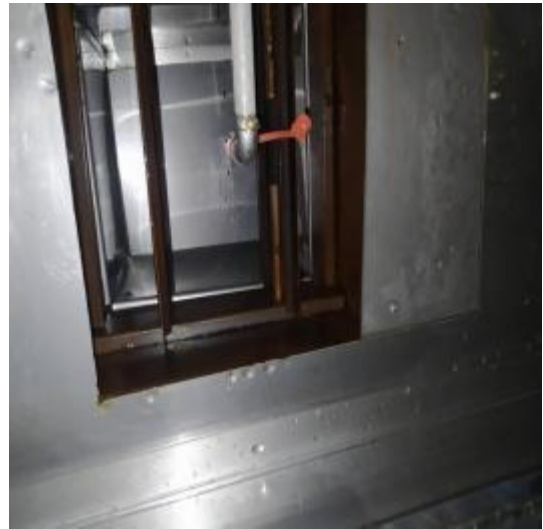
烧腊厨房管道清洗后
