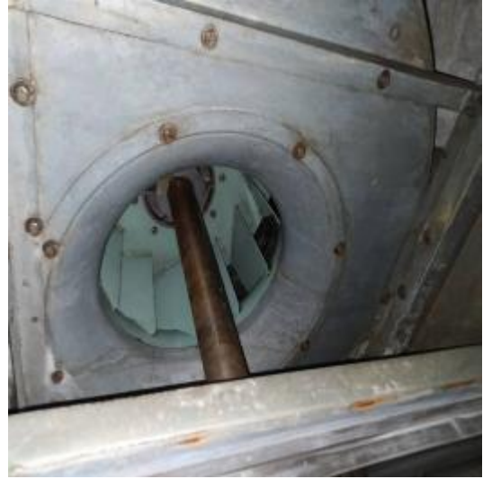
楼顶风机清洗后 3
