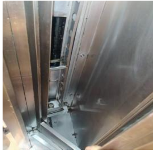
咖啡厅厨房管道清洗后
