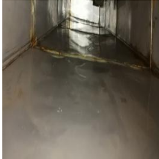
会所厨房横向管道清洗后
