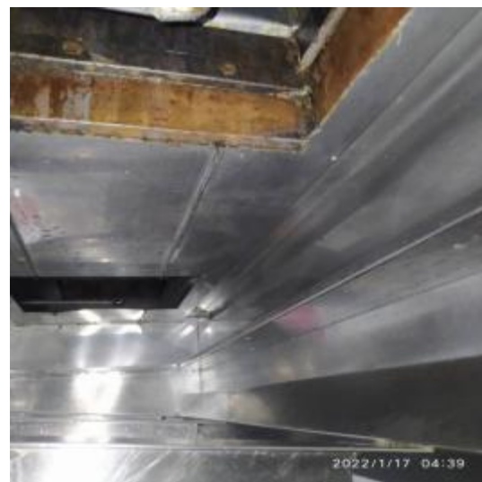
员工厨房管道清洗后
