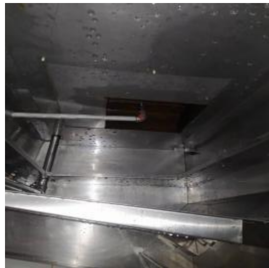
烧腊厨房管道清洗后
