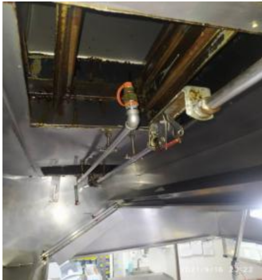
咖啡厨房管道清洗前
