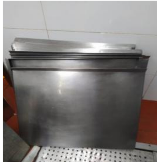
员工厨房防火板清洗后
