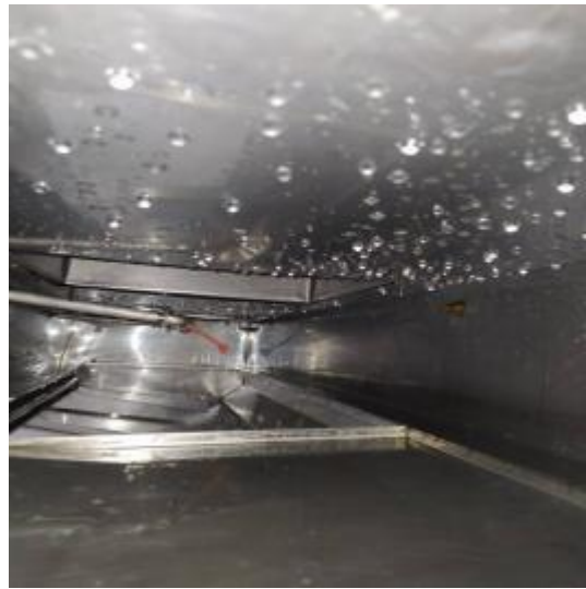
热辣厨房管道清洗后
