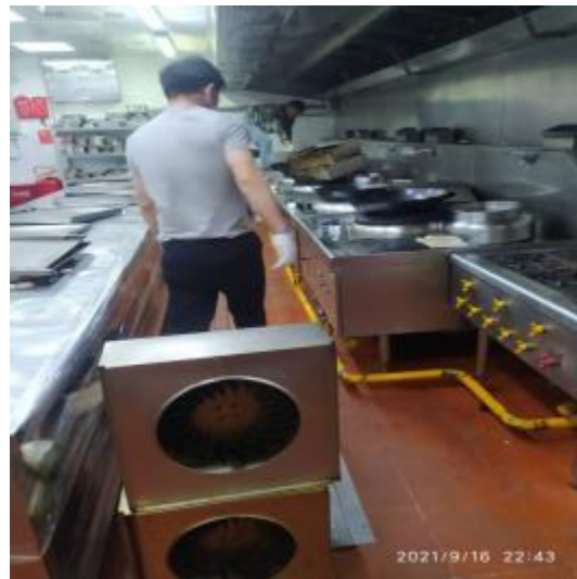
中厨房烟罩施工中
