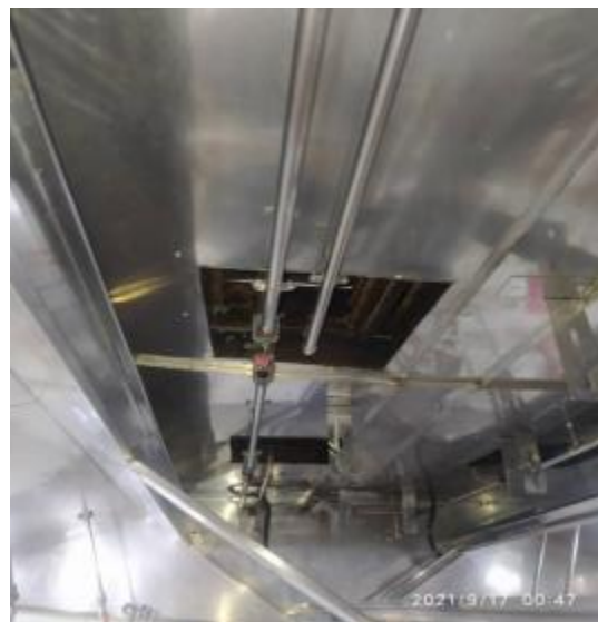
咖啡厅厨房烟罩清洗后
