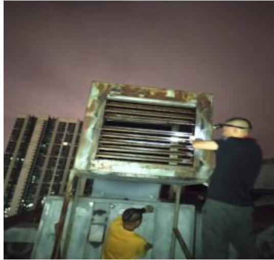
楼顶出风口施工中
