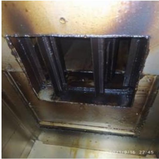
中厨房管道清洗前
