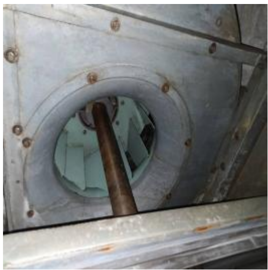
楼顶风机清洗后 3
