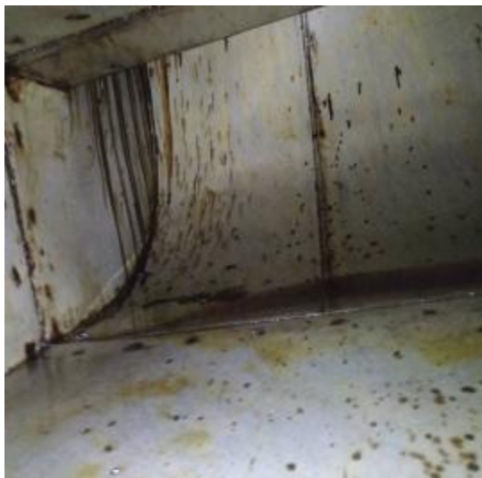
中厨房主管道清洗前
