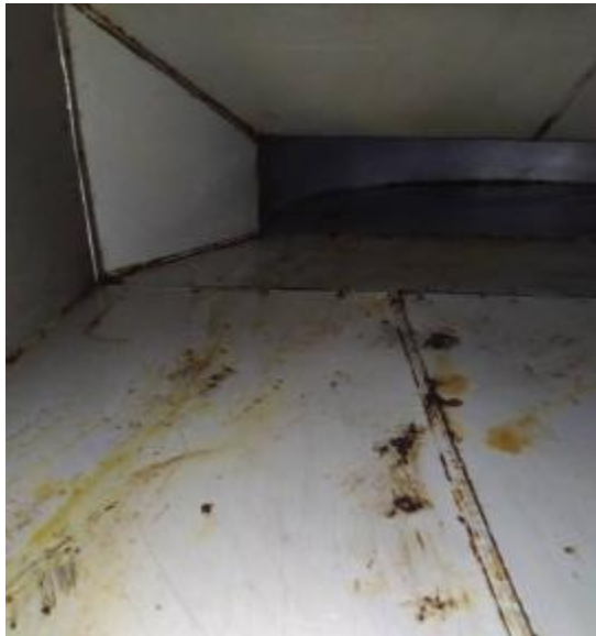
宴会厨房主管道清洗前
