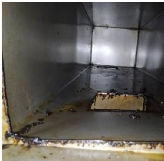
中厨房管道清洗前
