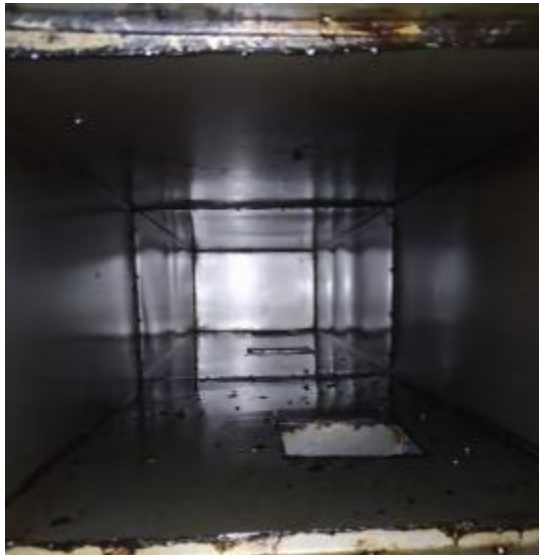
中厨房主管道清洗前
