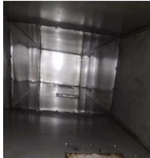
中厨房主管道清洗后
