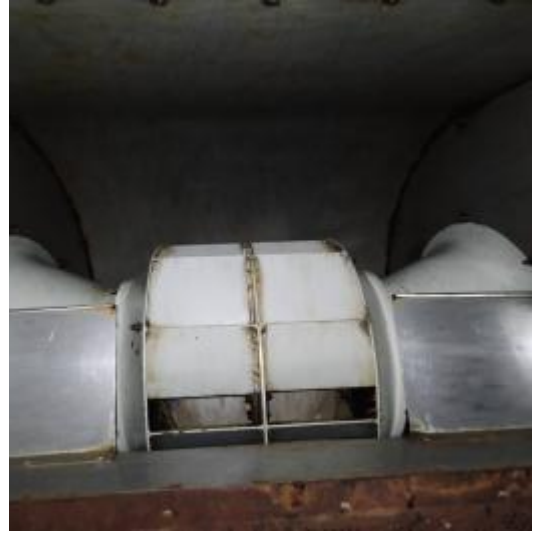
楼顶风机清洗后 1
