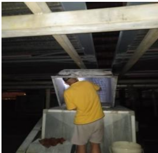
楼顶出风口施工中
