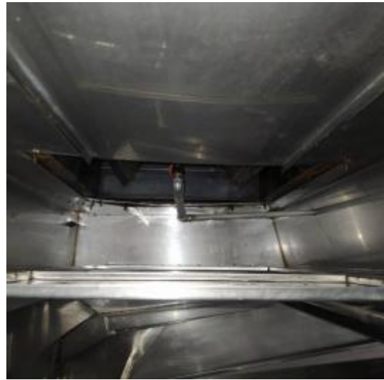
宴会厨房烟罩清洗后
