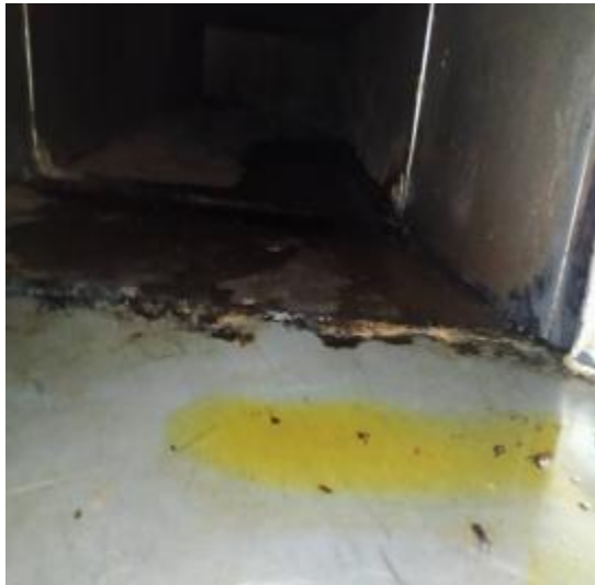
员工厨房主管道清洗前
