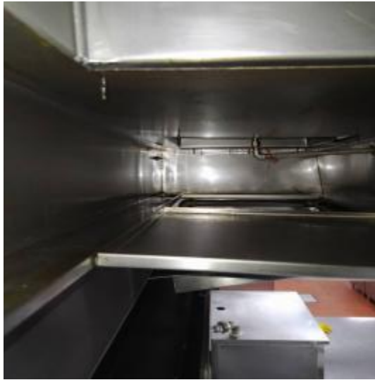
热辣厨房管道清洗前
