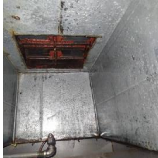
会所厨房管道清洗后
