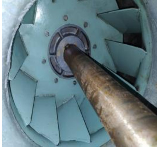
楼顶风机清洗后 4
