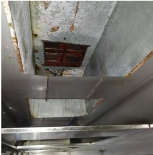
会所厨房管道清洗前
