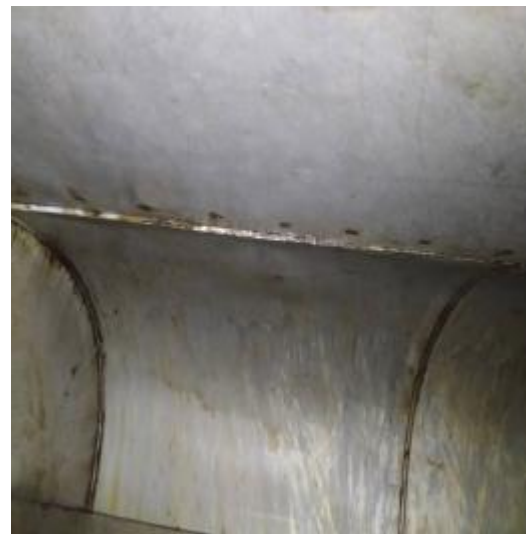
中厨房主管道清洗后
