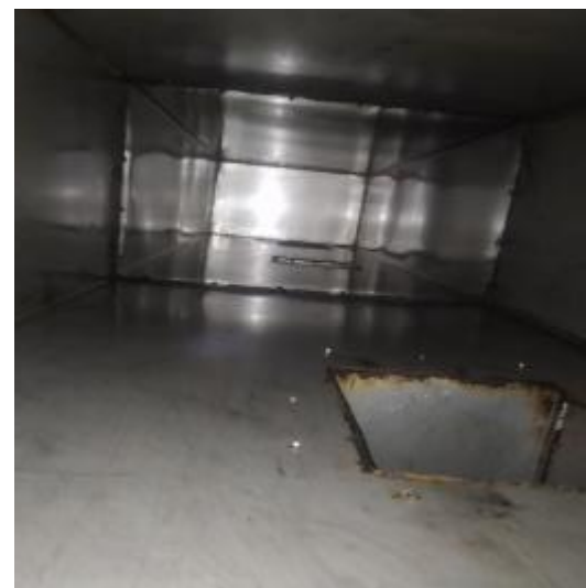
中厨房管道清洗后
