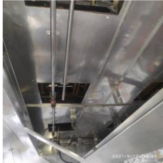
咖啡厅烟罩灯管清洗后
