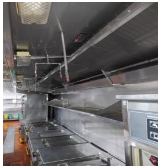
宴会厨房烟罩清洗后
