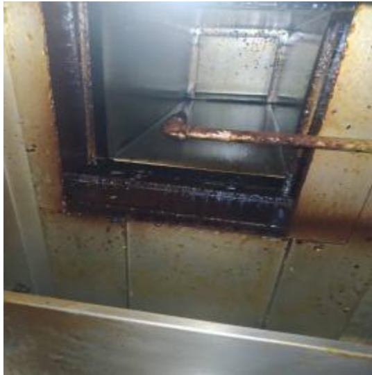
员工厨房管道清洗前
