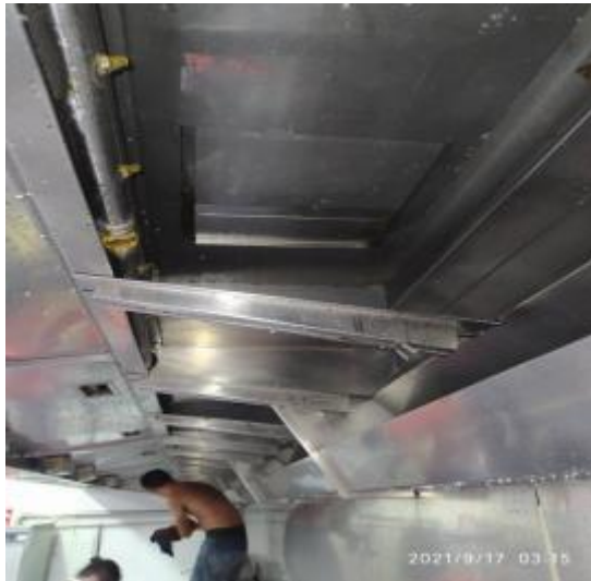
中厨房烟罩施工中
