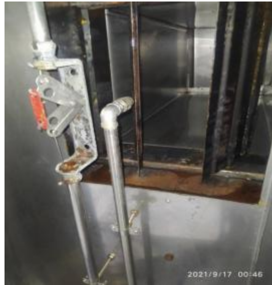
咖啡厨房管道清洗后
