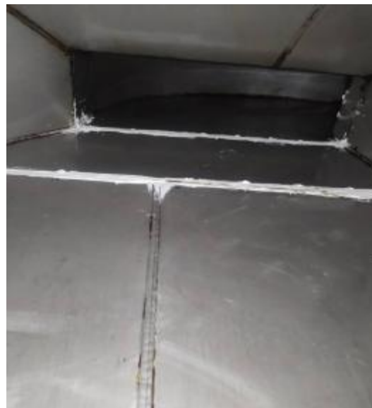
宴会房主管道清洗后
