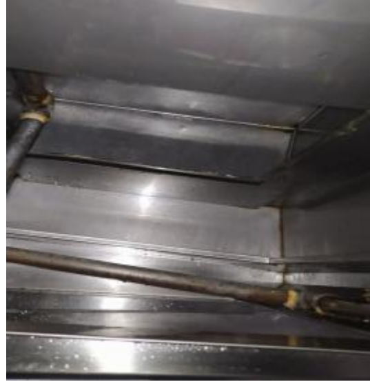
宴会厨房管道清洗前
