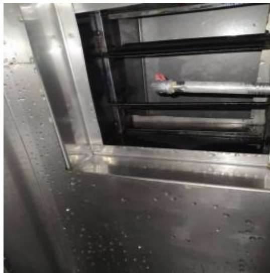
热辣厨房管道清洗后
