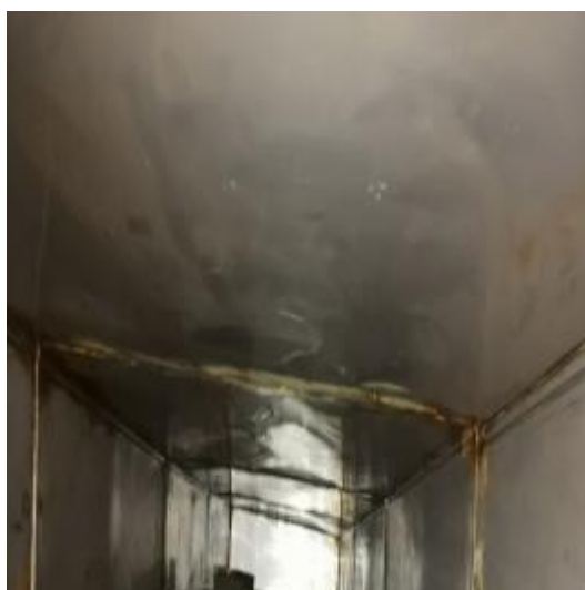
会所厨房横向管道清洗后
