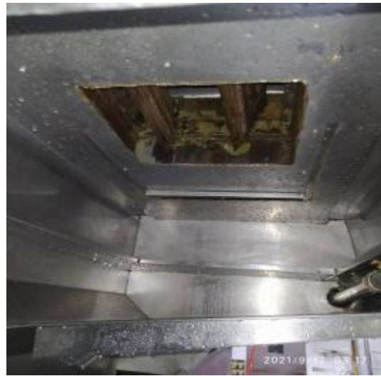
中厨房管道清洗后
