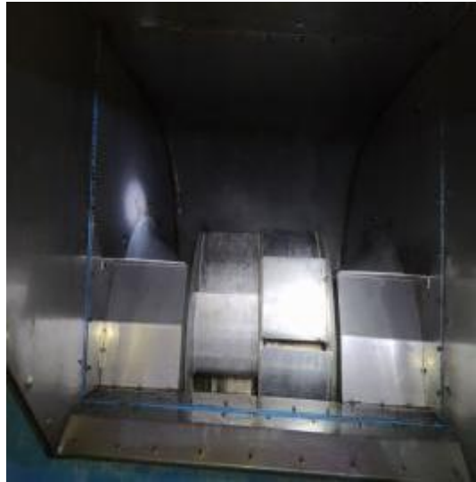
楼顶风机清洗后 2
