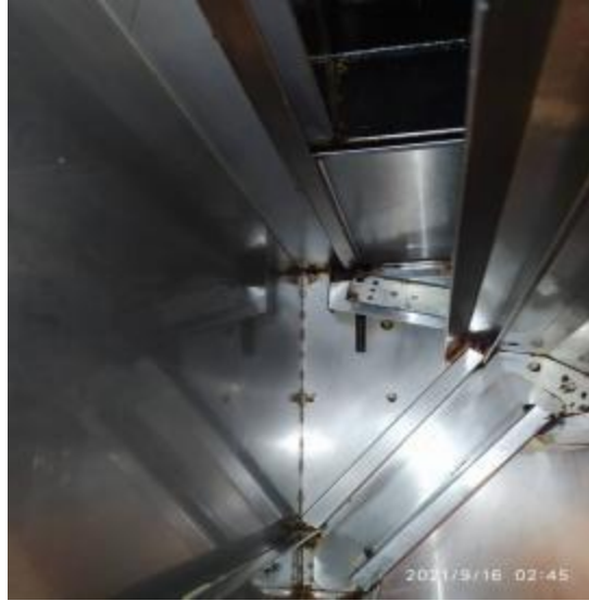
咖啡厅厨房管道清洗后
