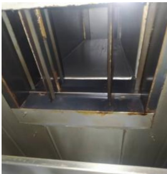
宴会厨房道清洗前
