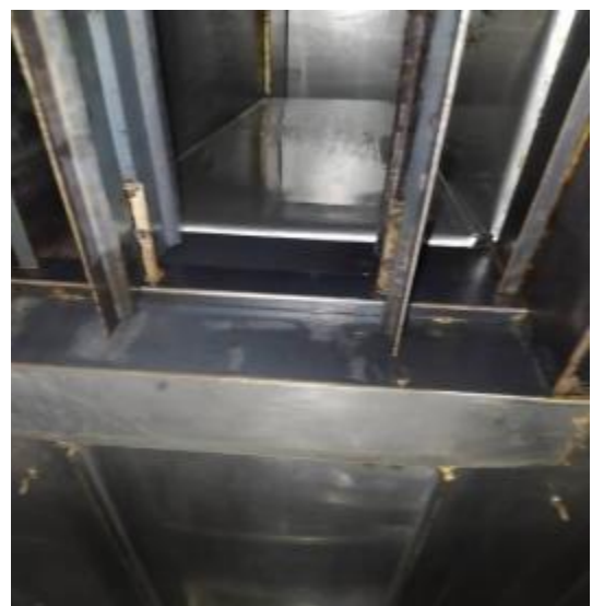
宴会厨房管道清洗后
