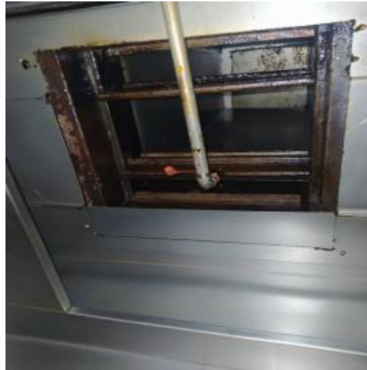
员工厨房管道清洗后
