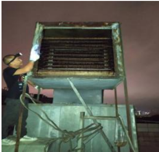
楼顶出风口施工中
