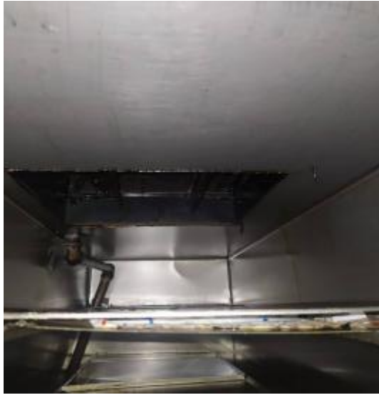
宴会厨房管道清洗前
