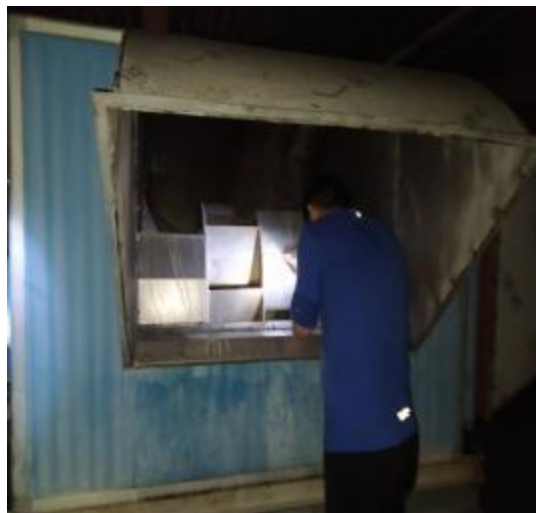
楼顶出风口施工中
