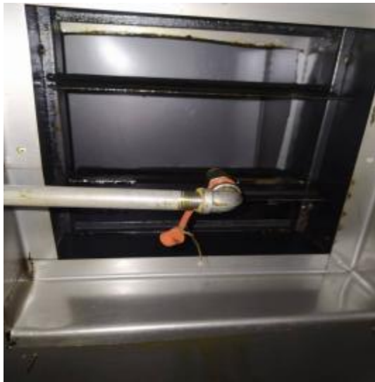
热辣厨房管道清洗前
