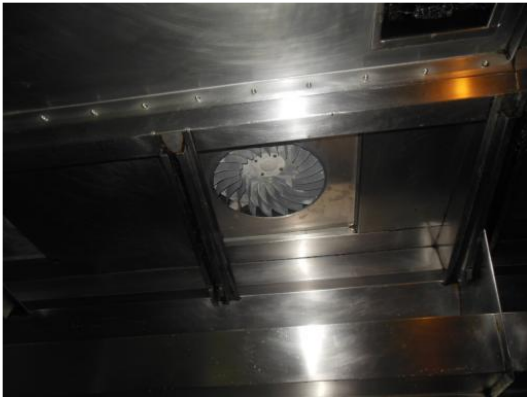
员工厨房 清洗后
