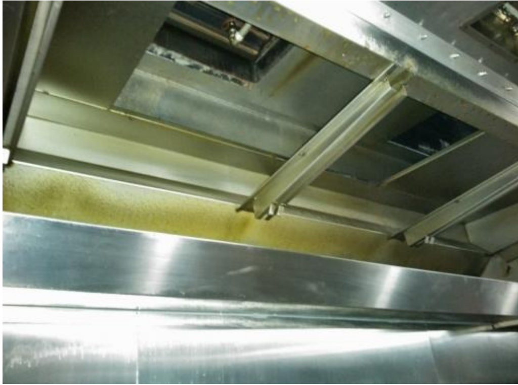
宴会厨房清洗前
