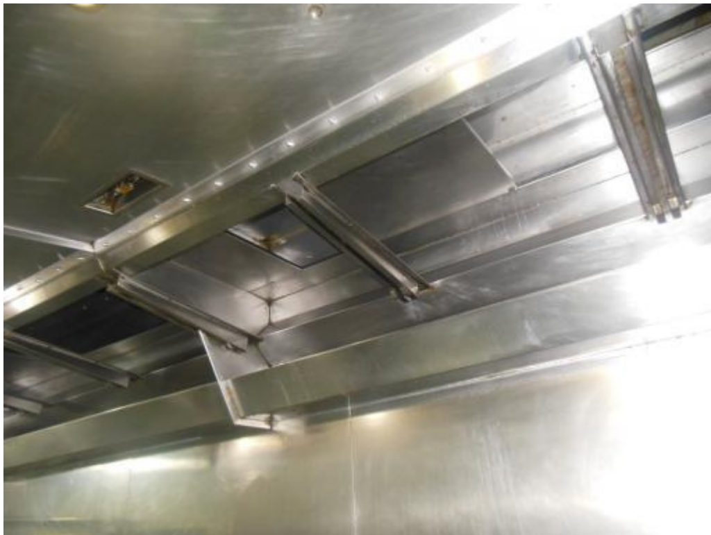
宴会厨房清洗后
