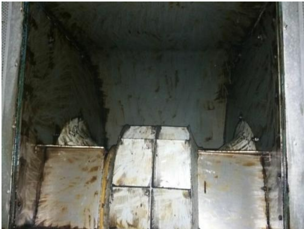
风机内部清洗后
