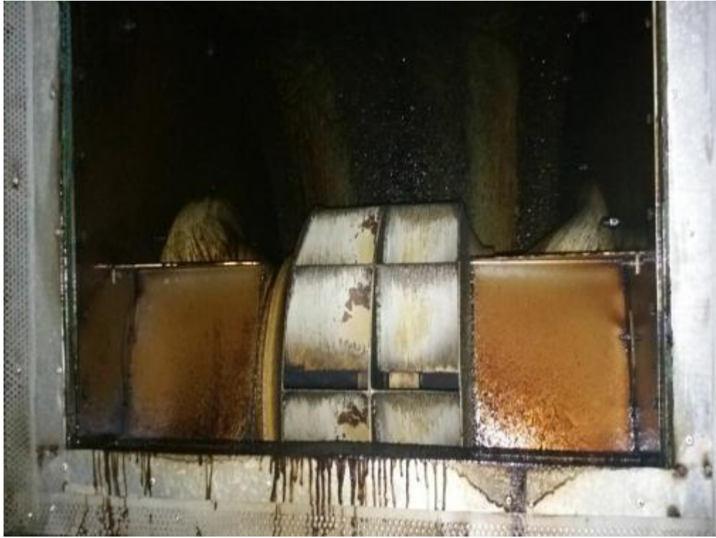
风机内部清洗前
