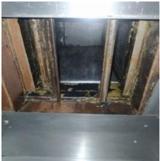
中厨房管道清洗前
