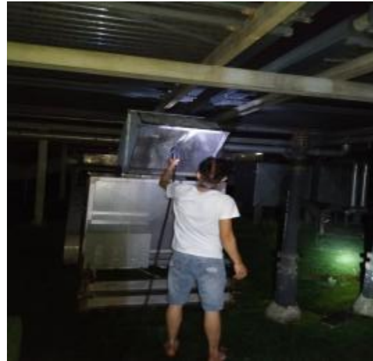
楼顶出风口施工中
