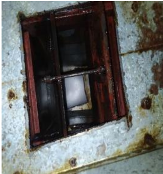
会所厨房管道清洗前 1
