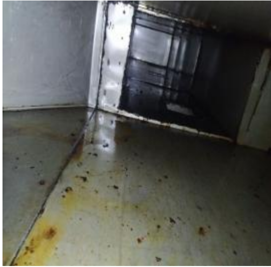
宴会厨房主管道清洗前
