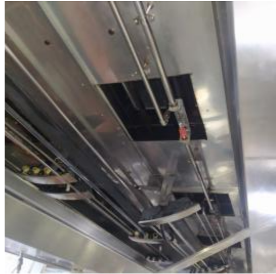
咖啡厅厨房烟罩清洗后
