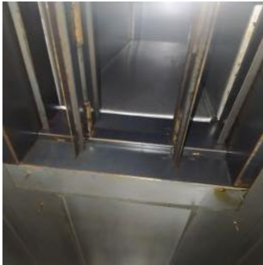
宴会厨房管道清洗前
