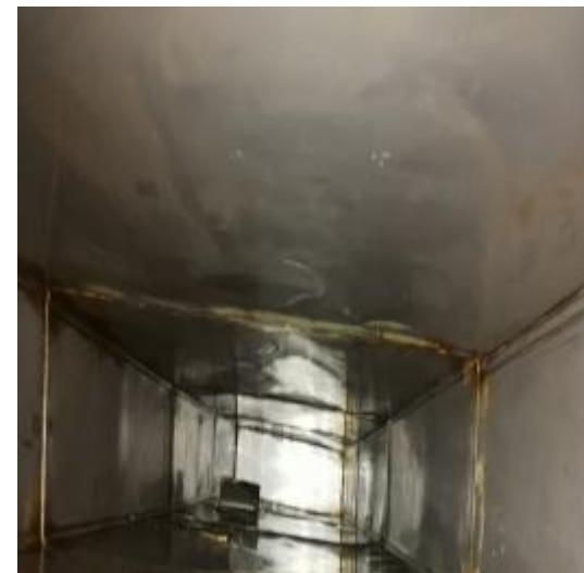
会所厨房管道清洗后 2
