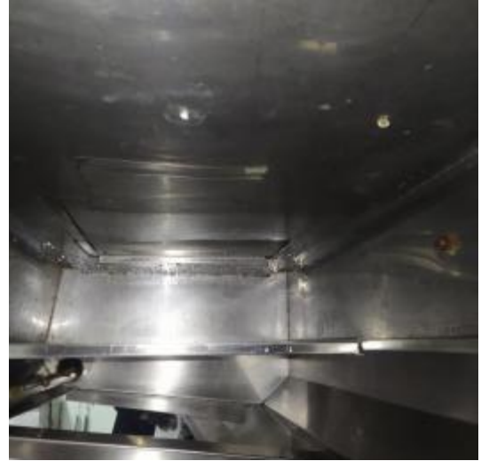
西厨房烟罩清洗后
