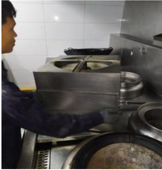
烧腊厨房风轮清洗中
