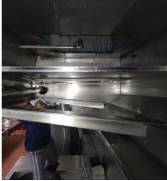
会所厨房烟罩清洗中
