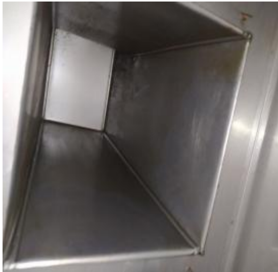
烧腊厨房管道清洗前
