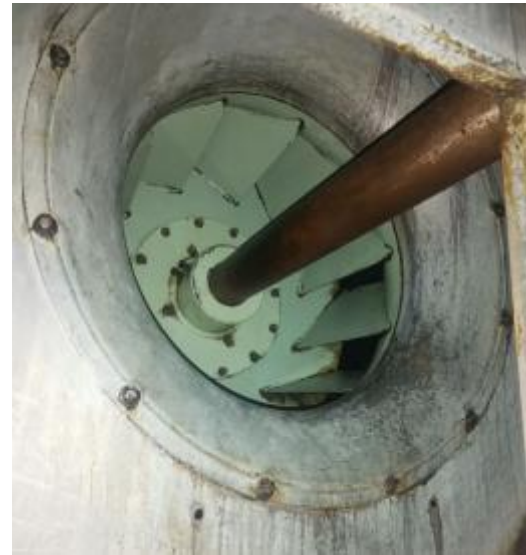
楼顶风机清洗后 2
