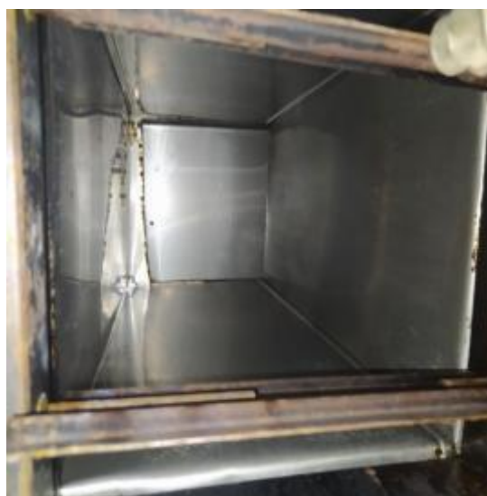
咖啡厅厨房管道清洗后
