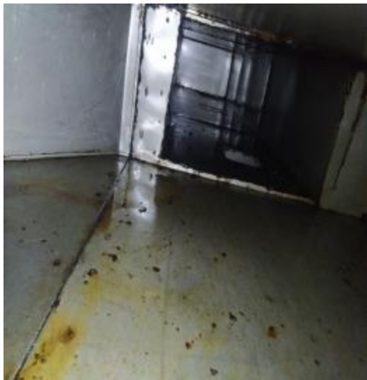
西厨房管道清洗前
