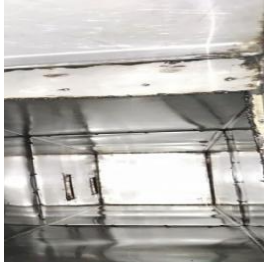
宴会房主管道清洗后
