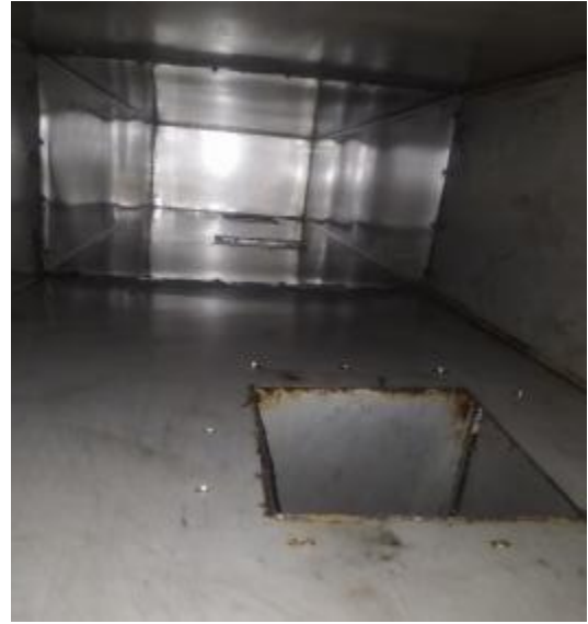
中厨房管道清洗前
