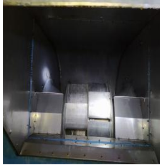
楼顶风机清洗后 1
