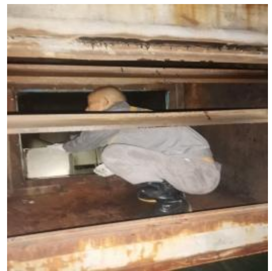
楼顶风机清洗中 1
