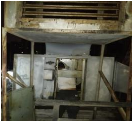
楼顶风机施工中
