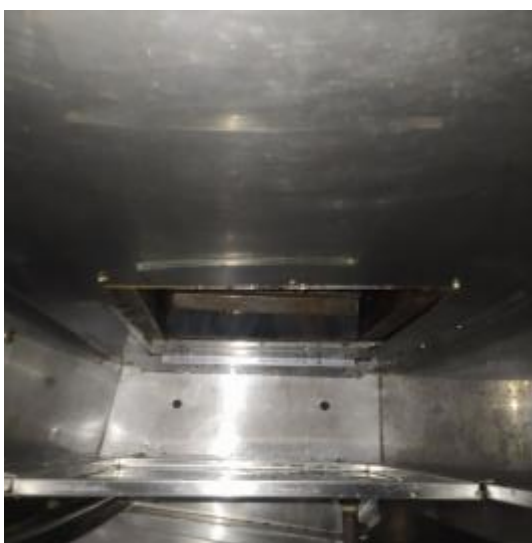
中厨房管道清洗后
