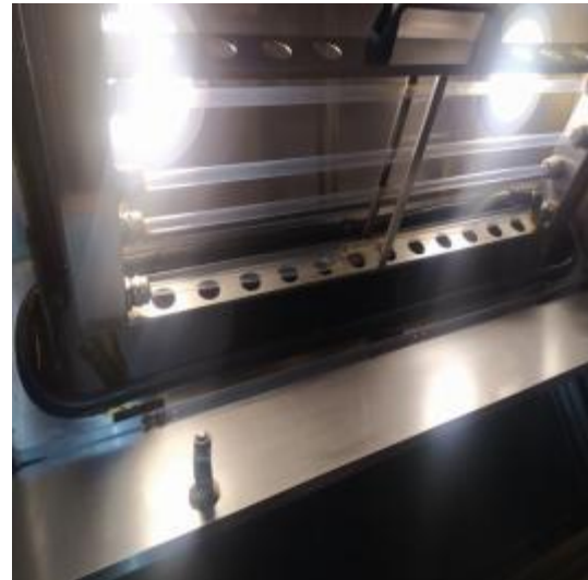
咖啡厅烟罩灯管清洗后
