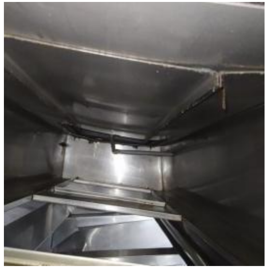
宴会厨房管道清洗后
