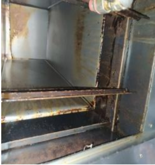
西厨房管道清洗前
