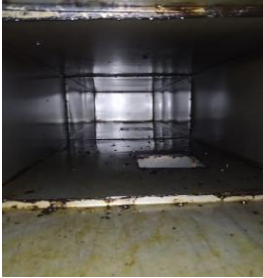
中厨房管道清洗前
