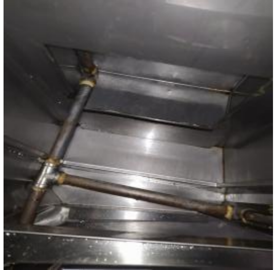
宴会厨房管道清洗前
