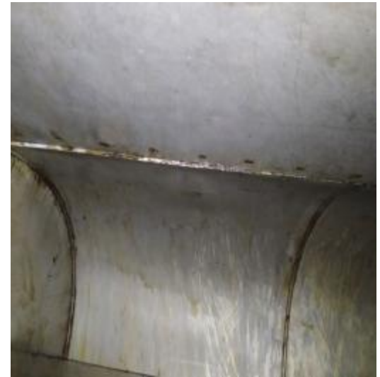
中厨房管道清洗后
