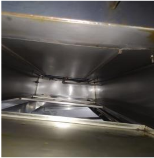
宴会厨房道清洗前
