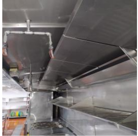
宴会厨房烟罩清洗后
