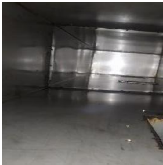
西厨管道清洗后
