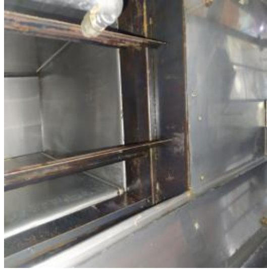
西厨房管道清洗后
