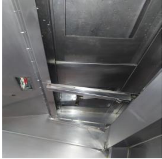
宴会厨房烟罩清洗后
