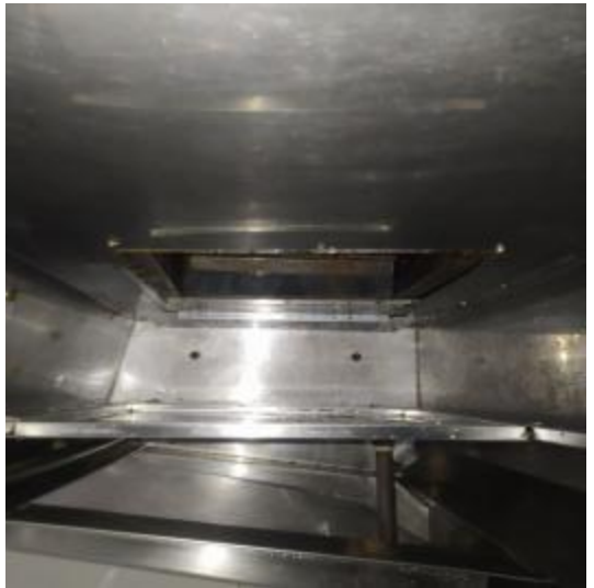
西厨房烟罩清洗后
