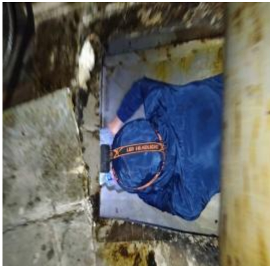
中厨房主管道施工中
