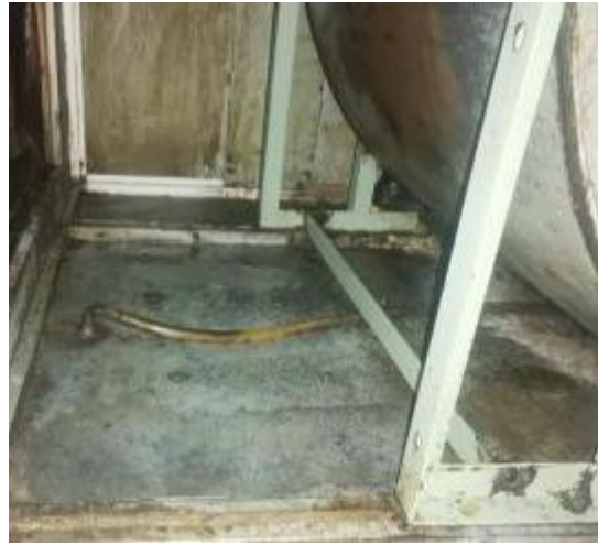
楼顶风机机箱清洗后 4
