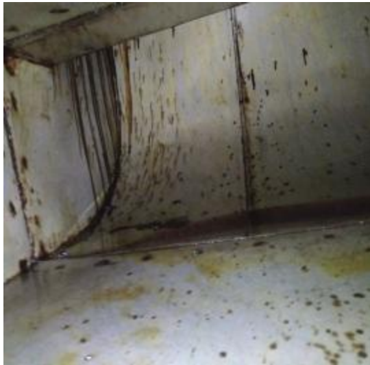
中厨房管道清洗前
