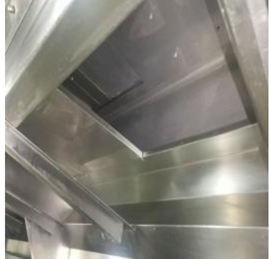
中厨房管道清洗后
