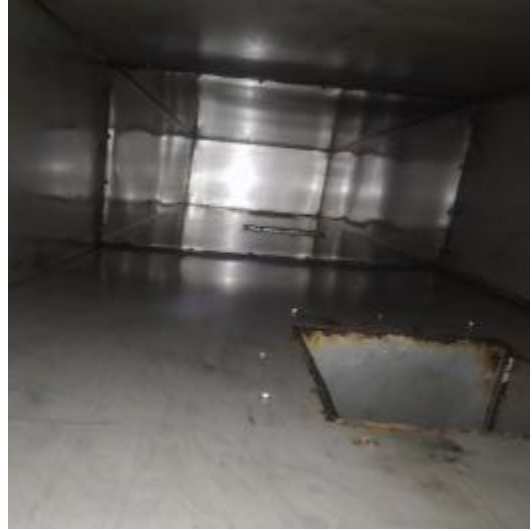
中厨房管道清洗后
