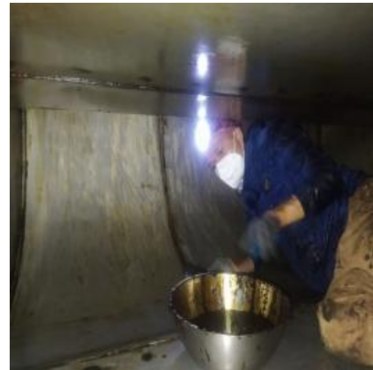
中厨房主管道施工中
