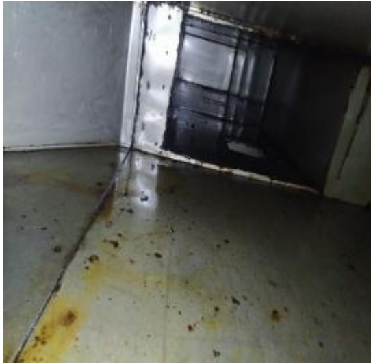
中厨房管道清洗前
