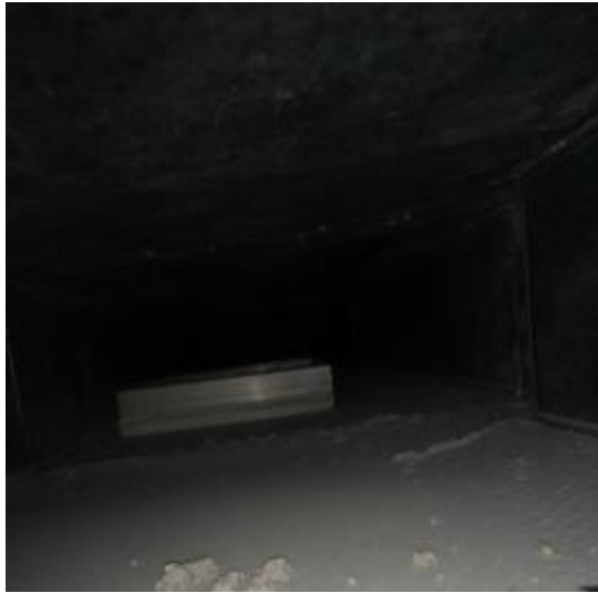
洗衣房管道清洗前
