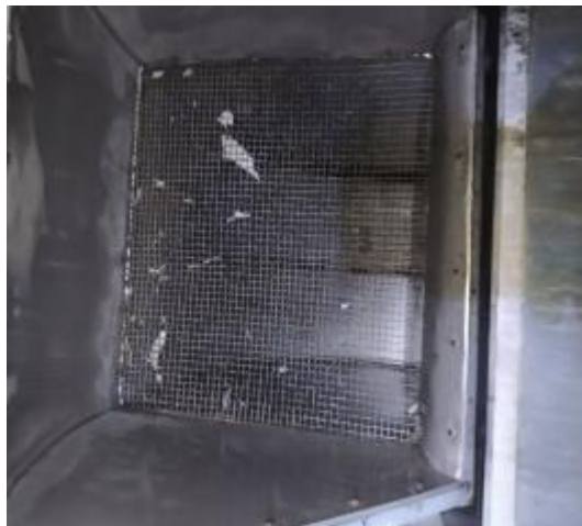
楼顶出风口施工中
