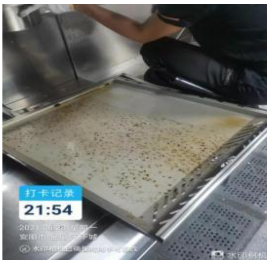
防火板清洗前
