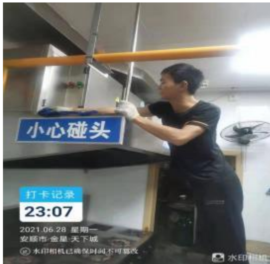
净化器施工中
