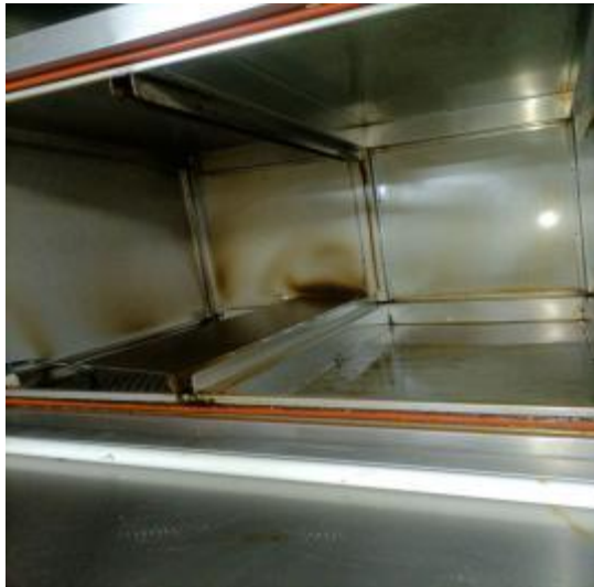
净化器机箱道清洗前 1
