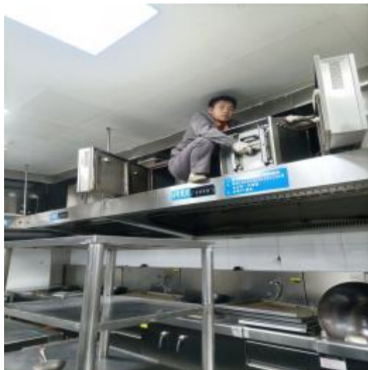
净化器施工中
