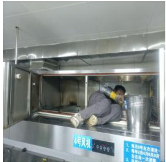
净化器机箱施工中
