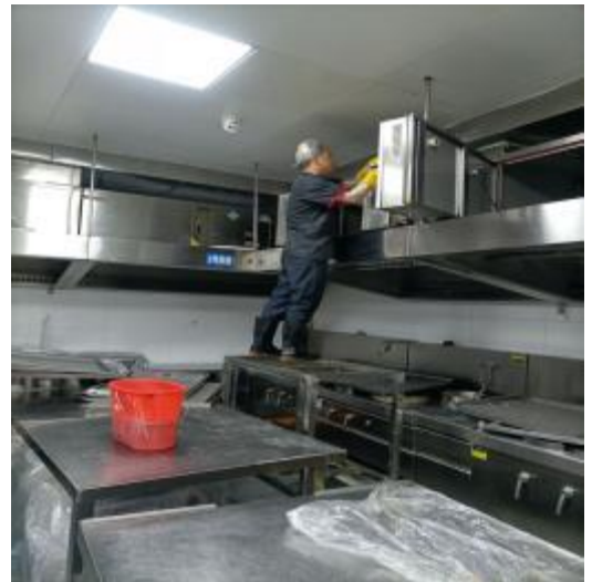
净化器施工中
