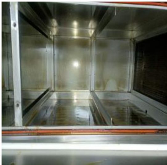
净化器机箱道清洗前 1
