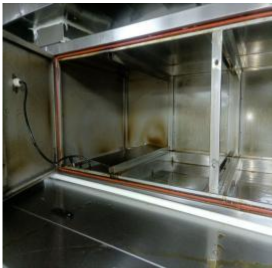
净化器机箱清洗前 2
