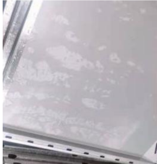
防火板清洗后
