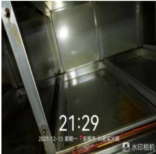
净化器机箱道清洗前 1
