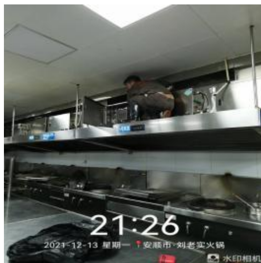
净化器机箱清洗中
