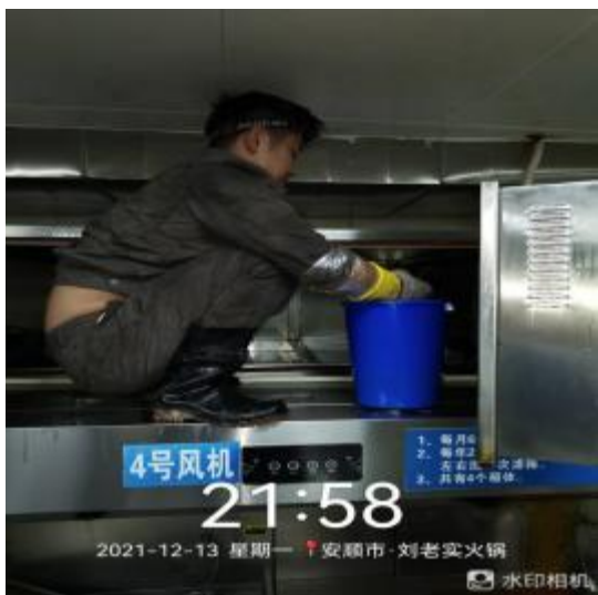
净化器机箱清洗前 2
