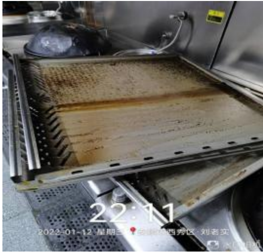
防火板清洗前
