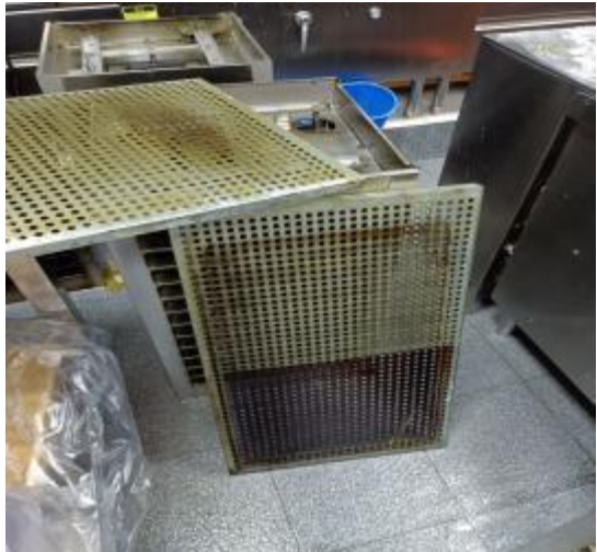
过滤网清洗前
