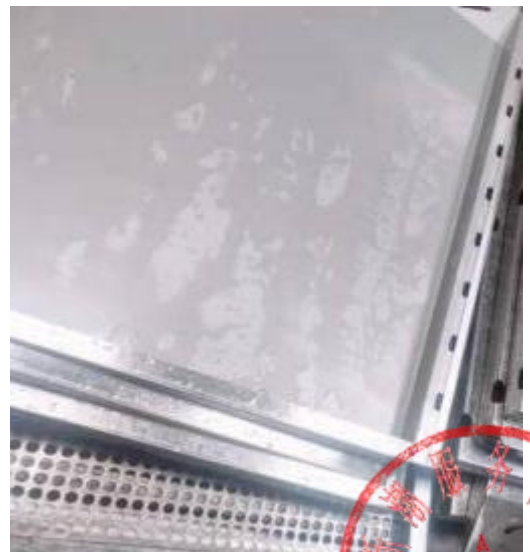
防火板清洗后
