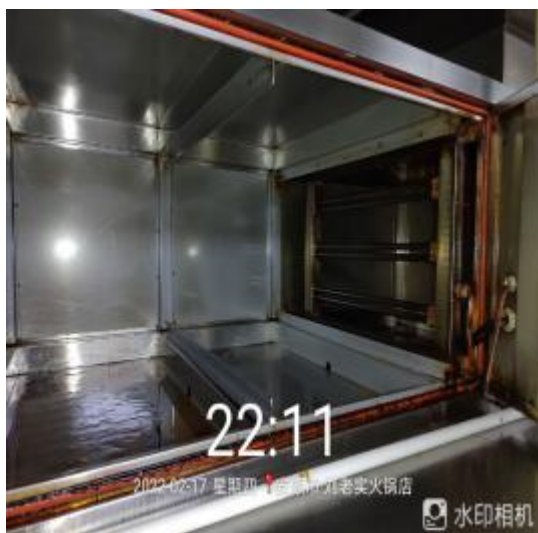
净化器机箱清洗施工中
