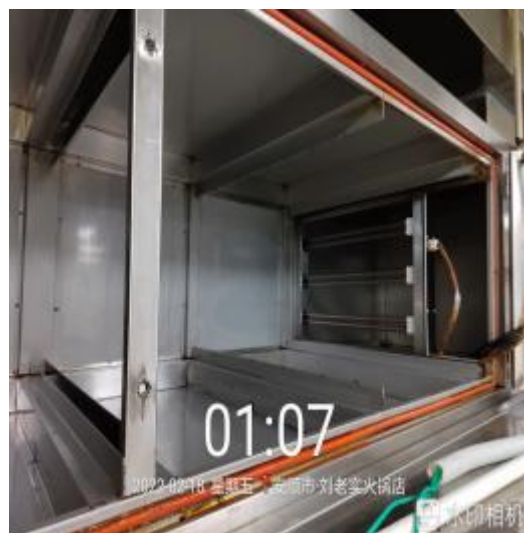
净化器机箱施工中
