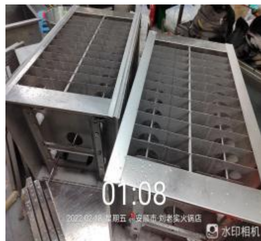
净化器机箱清洗后
