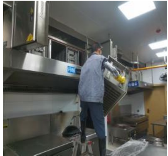
净化器施工中
