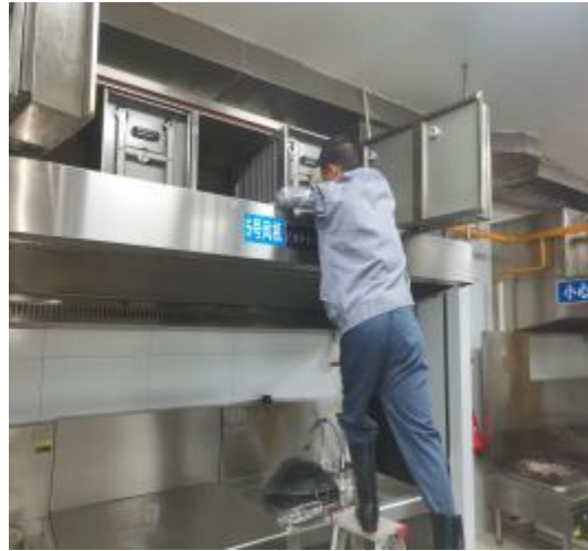
净化器施工中
