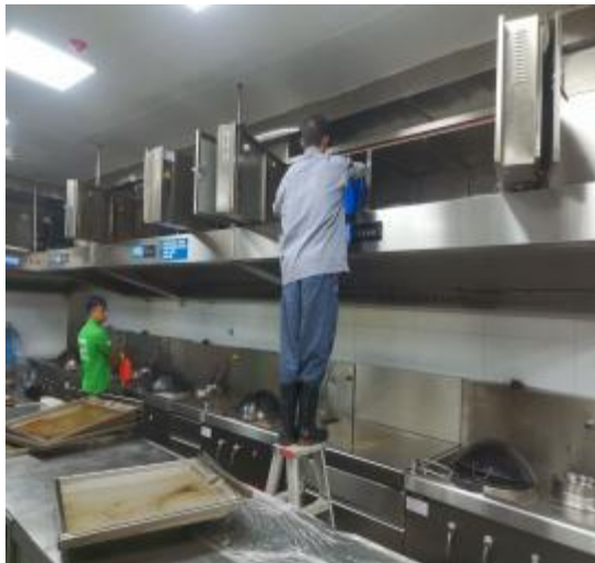
净化器机箱施工中
