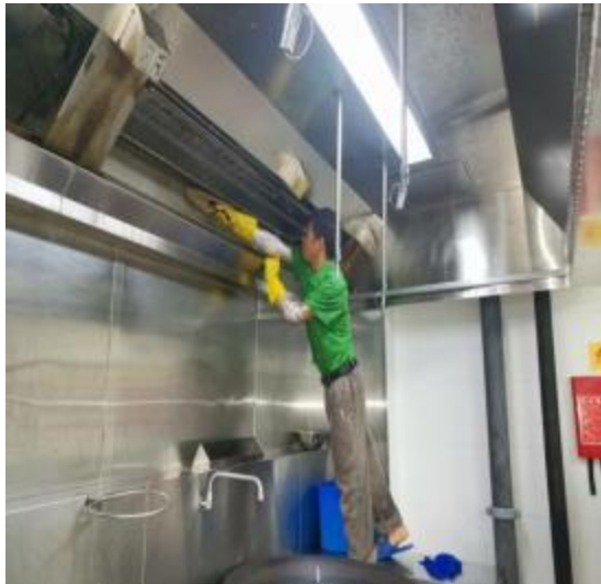
员工厨房烟罩施工中
