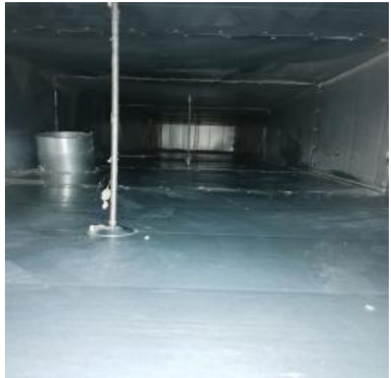
洗衣房管道清洗后 3
