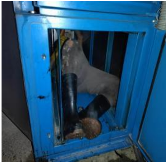
净化器施工中
