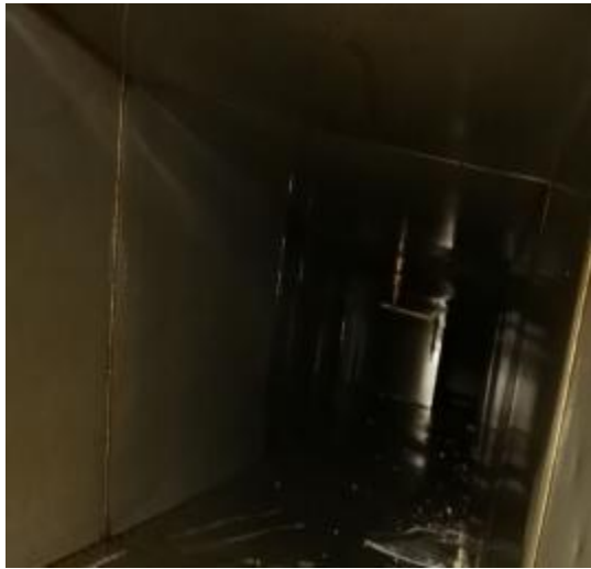
主管道清洗前 2
