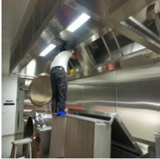
宴会厨房烟罩施工中
