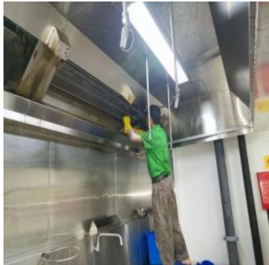
员工厨房烟罩施工中
