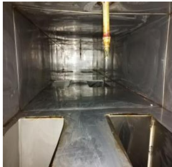
西厨管道清洗后
