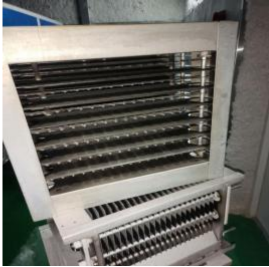
宴会厨房净化器清洗前
