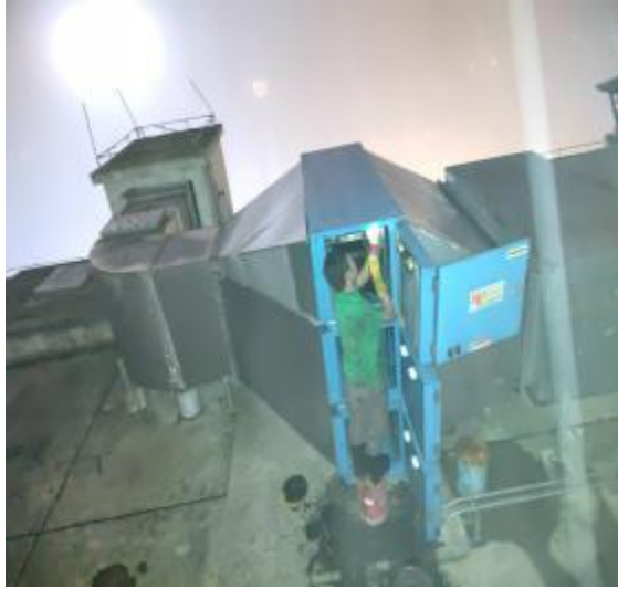
净化器施工中
