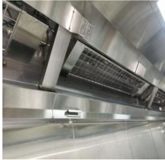
西厨房烟罩清洗后
