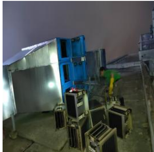
净化器施工中
