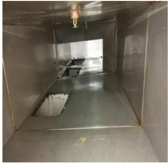
主管道清洗后 1
