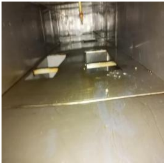
西厨管道清洗中
