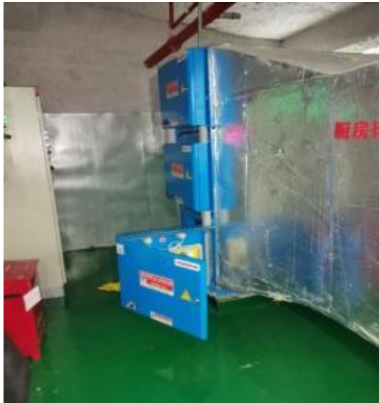
宴会厨房净化器机箱施工中
