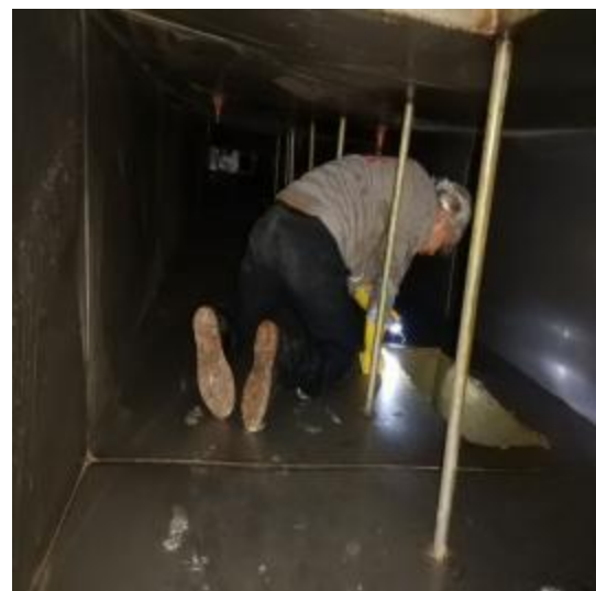
主管道施工中
