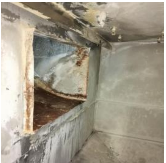
洗衣房管道清洗后
