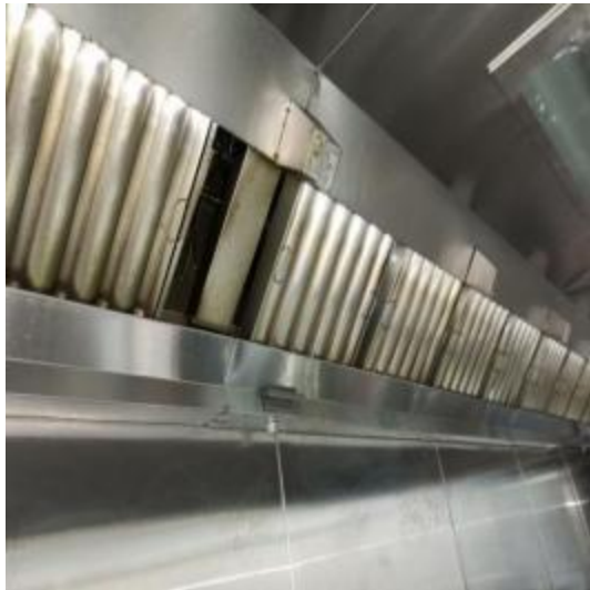
宴会厨房烟罩清洗前 1
