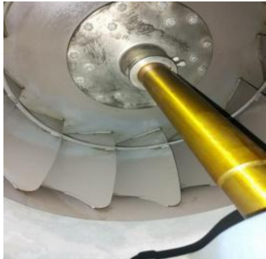
宴会厨房风机清洗后
