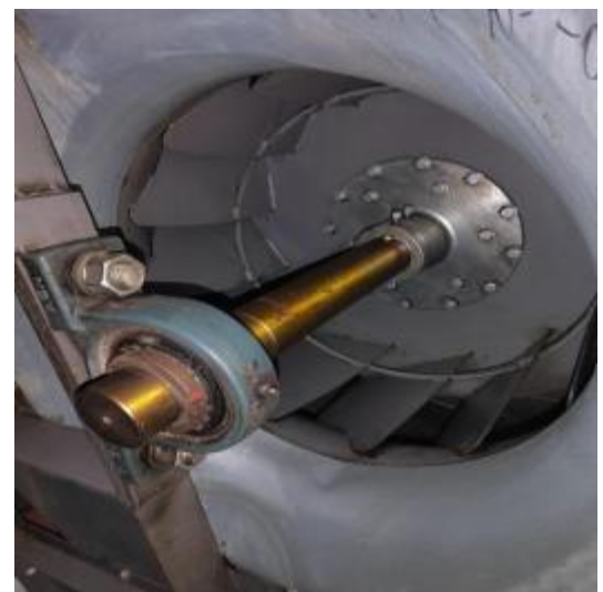
楼顶风机清洗后 3
