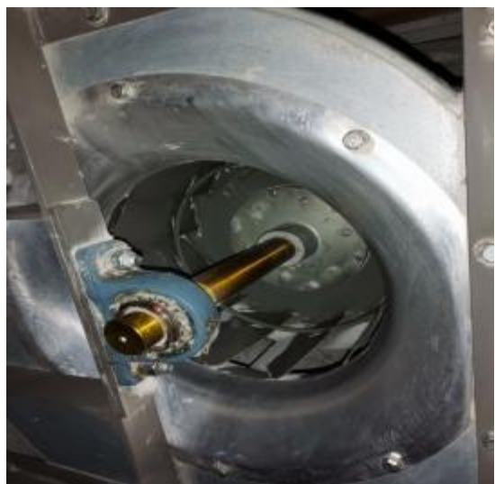
洗衣房风机清洗后
