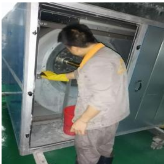
宴会厨房风机清洗中
