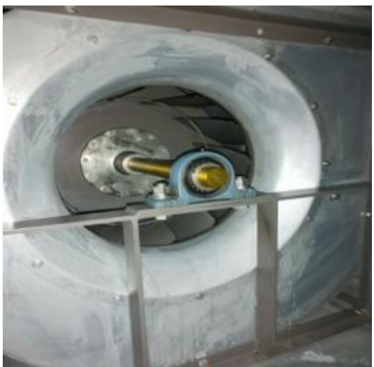
宴会厨房风机清洗后
