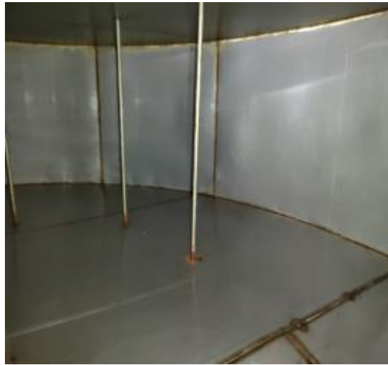
主管道清洗后 2
