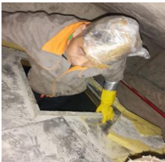
主管道施工中
