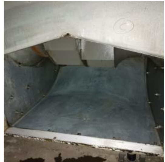
楼顶风机清洗后 2
