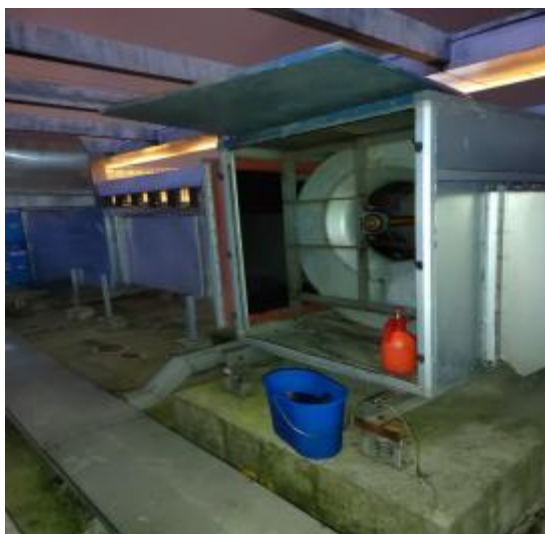
楼顶风机清洗中 3
