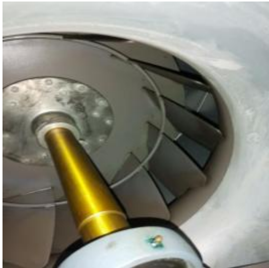
宴会厨房风机清洗前
