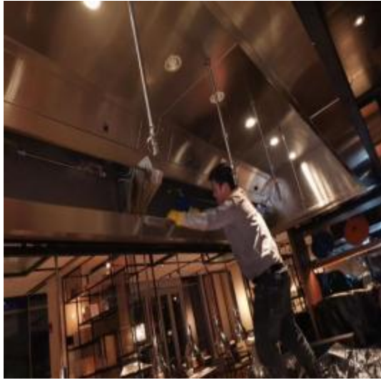
西厨明档烟罩清洗中 2
