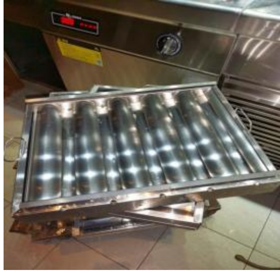
西厨明档烟罩施工中
