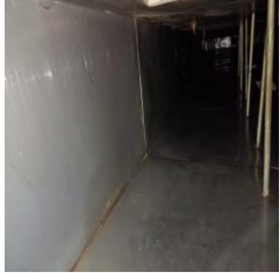
中厨房管道清洗后
