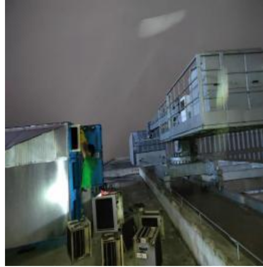
净化器施工中
