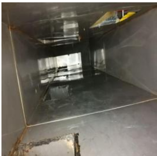
员工厨房管道清洗后
