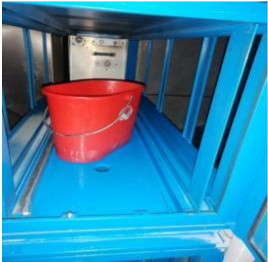
宴会厨房净化器机箱施工中
