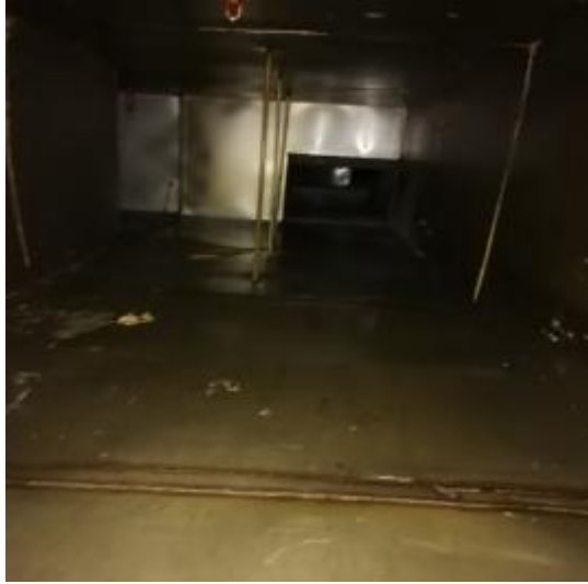
主管道清洗前 1
