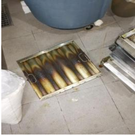
西厨明档烟罩施工中
