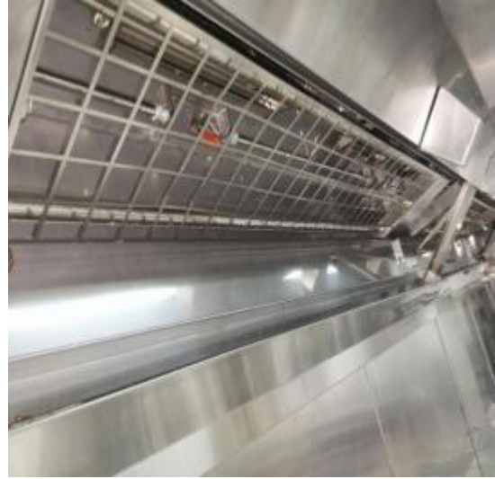
西厨房烟罩清洗后
