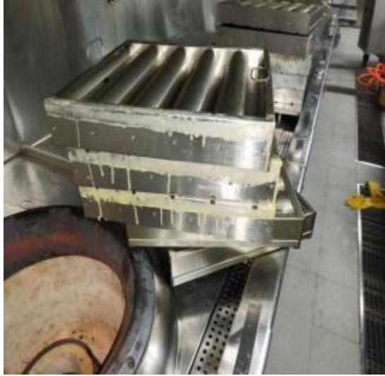
宴会厨房防火板施工中
