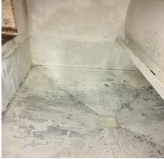
洗衣房管道清洗后 2
