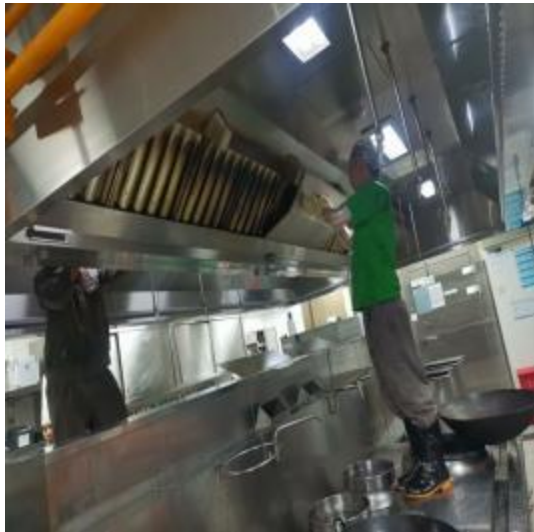
西厨明档烟罩施工中
