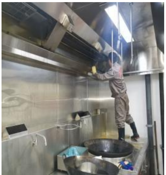
员工厨房烟罩施工中
