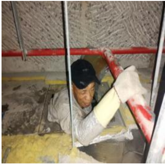
主管道清洗前 2
