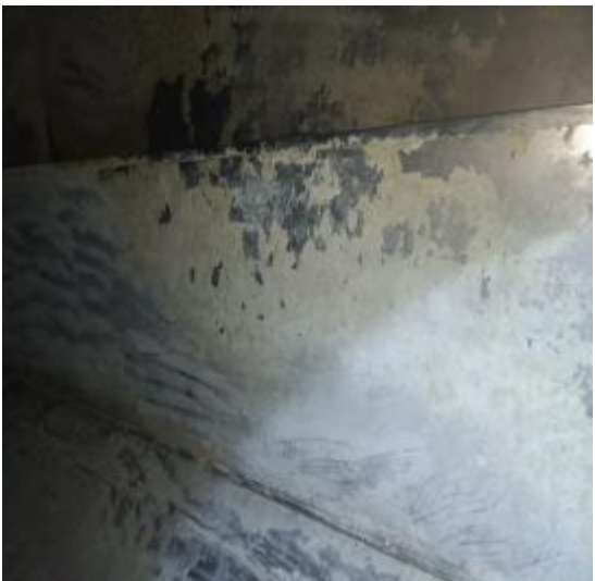
洗衣房管道清洗前 3
