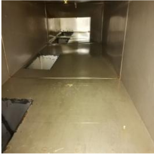
主管道清洗前 2
