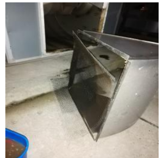
楼顶风机清洗中
