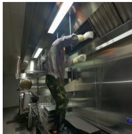
宴会厨房烟罩施工
