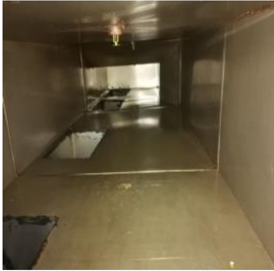
员工厨房管道清洗前
