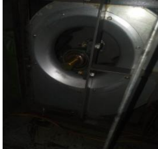
楼顶 风机清洗后 2
