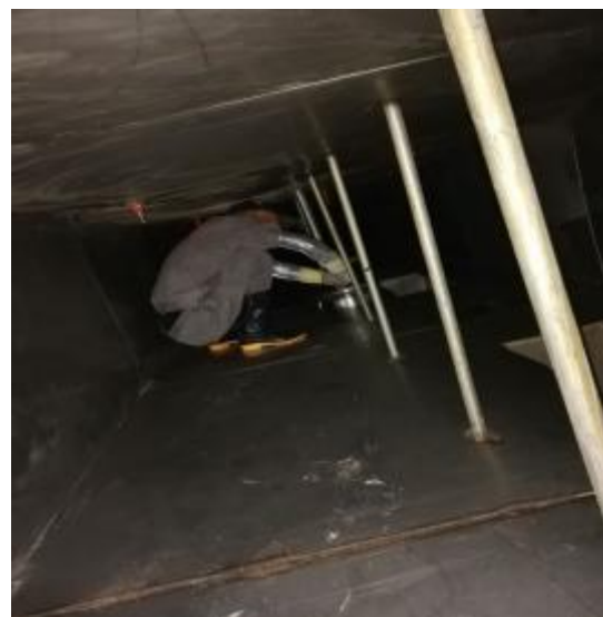
主管道施工中 1
