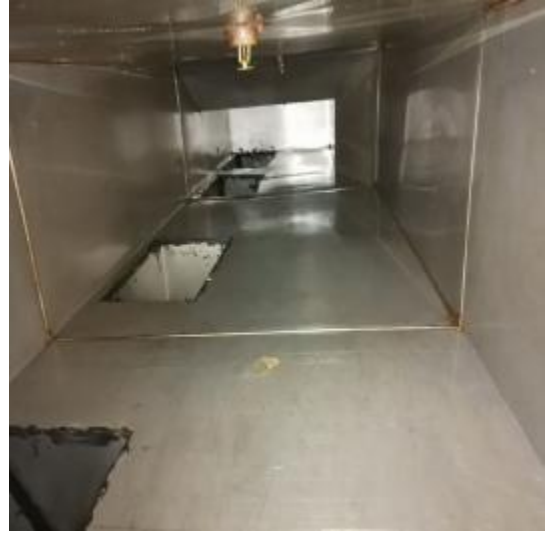
员工厨房管道清洗后
