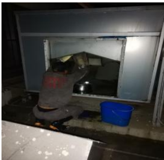
楼顶风机清洗中
