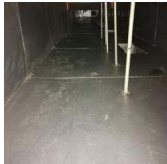
主管道清洗后 1
