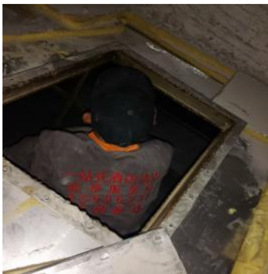
主管道施工中 1
