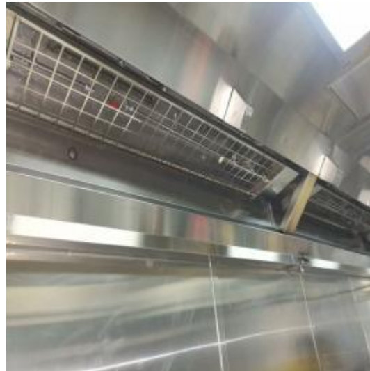
宴会厨房烟罩清洗后 1
