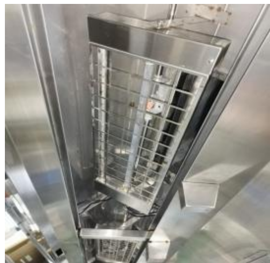
西厨房烟罩清洗后
