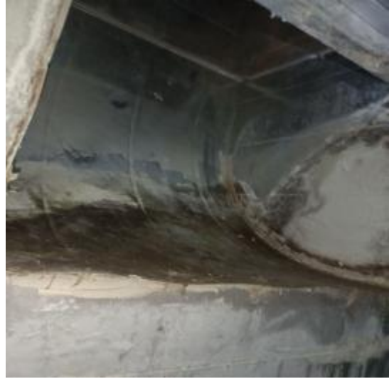
洗衣房管道清洗后
