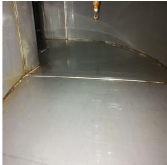
主管道清洗后 4
