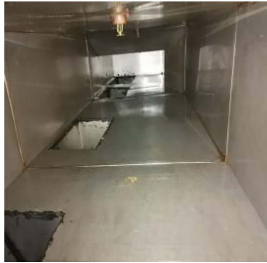
主管道清洗后 2
