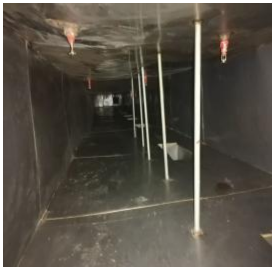
主管道清洗前 1
