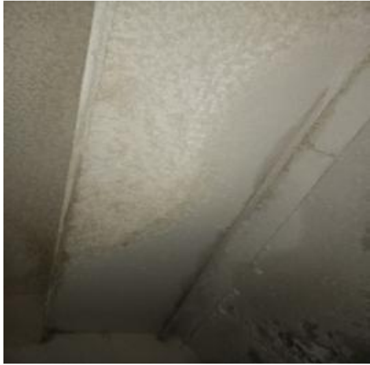
洗衣房管道清洗前 2
