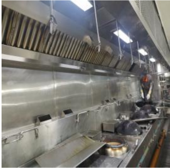
中厨房烟罩施工
