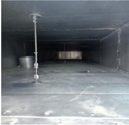
洗衣房管道清洗后 2
