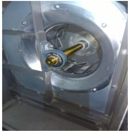
洗衣房风机清洗后
