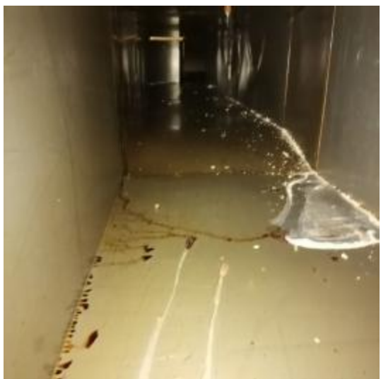
主管道清洗前 3
