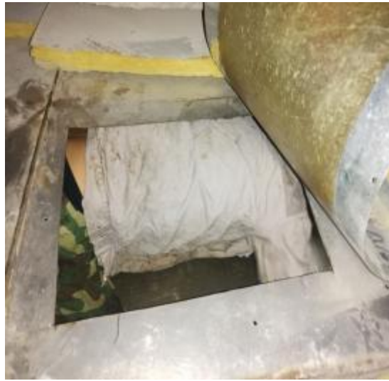
主管道清洗后 2
