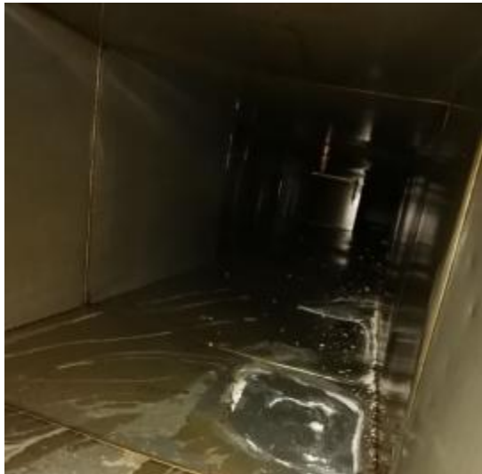
主管道清洗前 4
