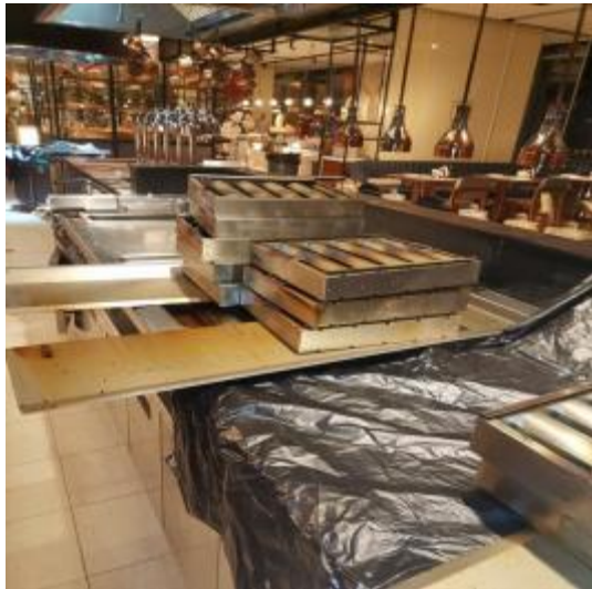
西厨明档烟罩施工中
