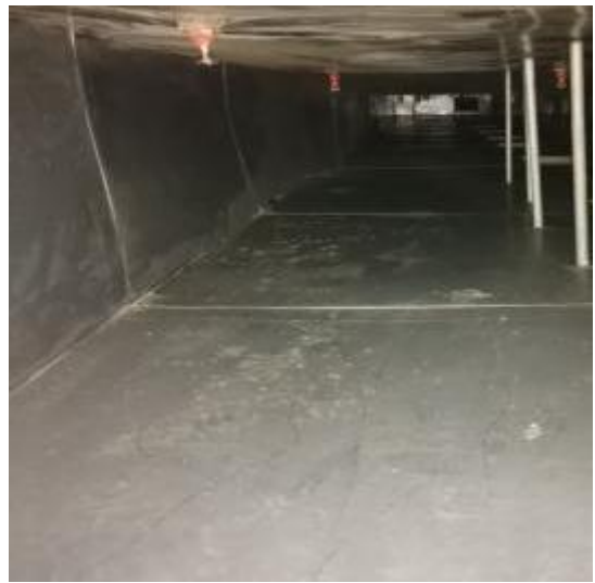
中厨房管道清洗后
