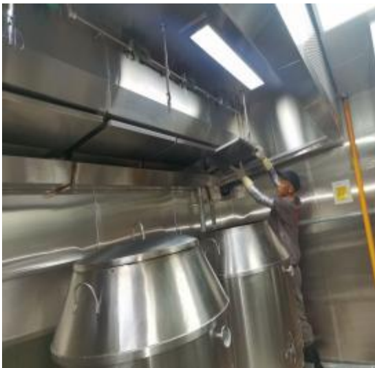
烧腊房烟罩施工中
