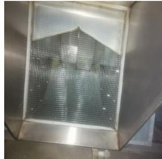
楼顶风机清洗后 1
