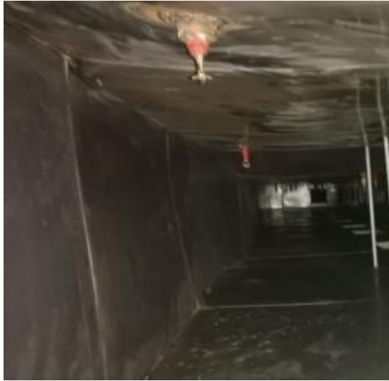
中厨房管道清洗前
