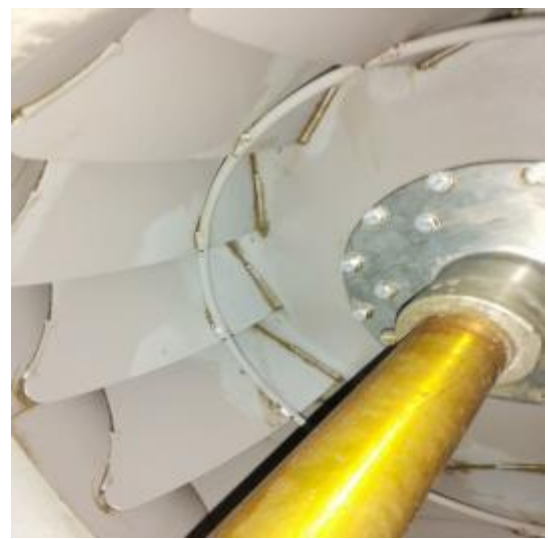
中厨房风机清洗后
