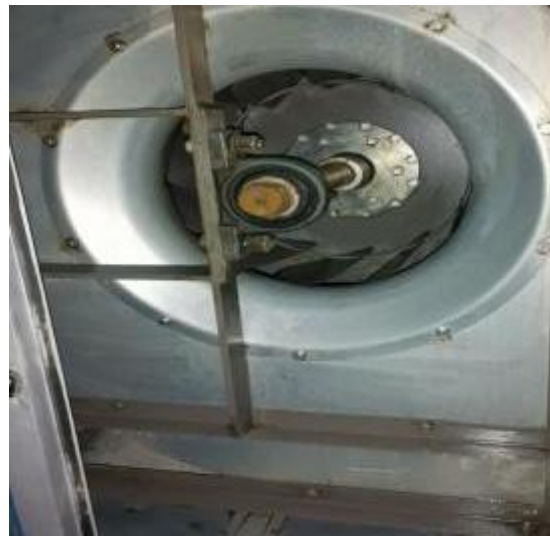
宴会厨房风机清洗后
