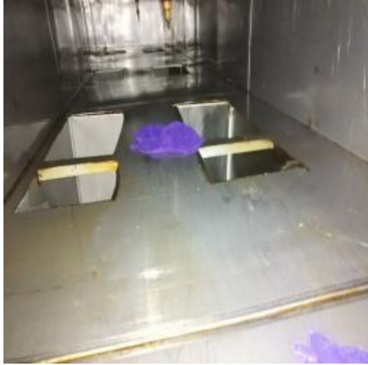
西厨管道清洗中
