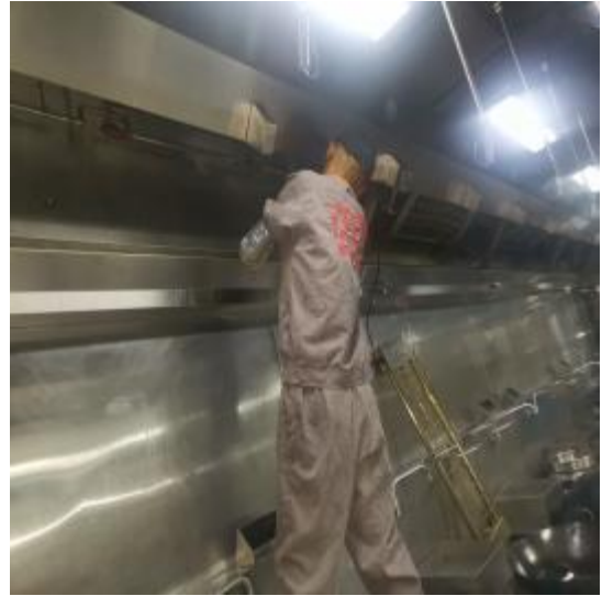
中厨房烟罩施工
