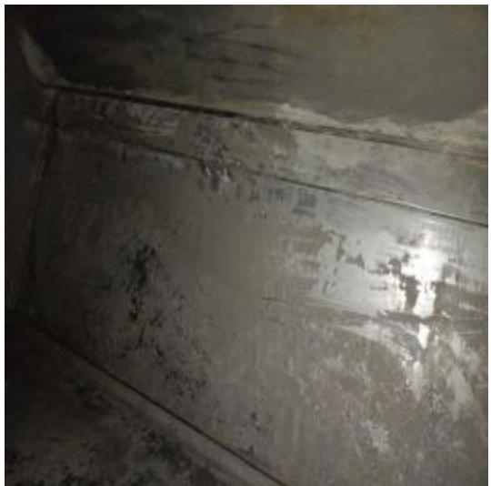
洗衣房管道清洗前 3
