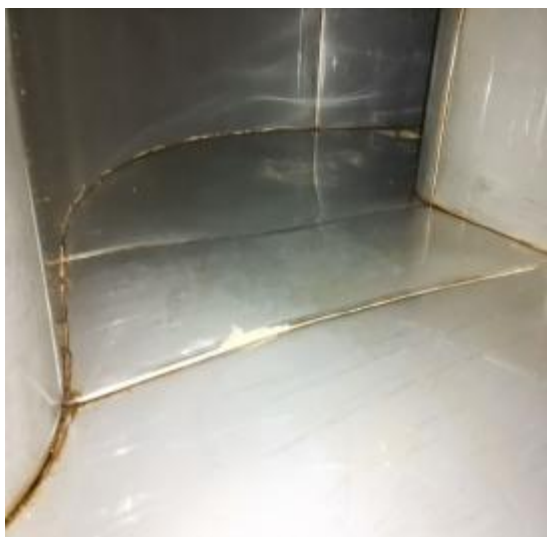
主管道清洗后 3
