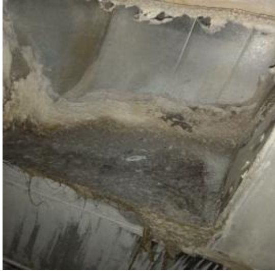
洗衣房管道清洗前
