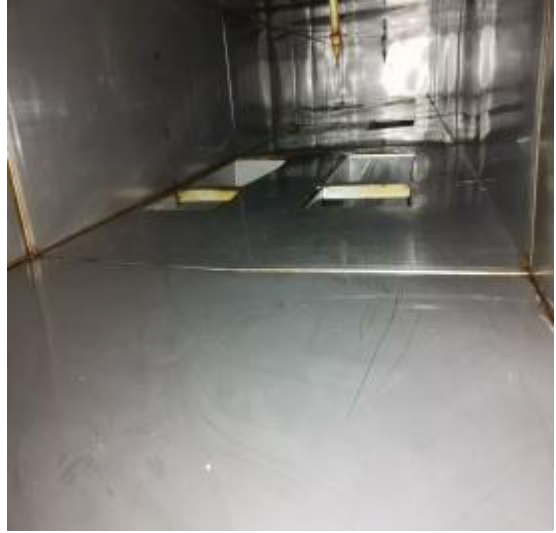
西厨管道清洗后
