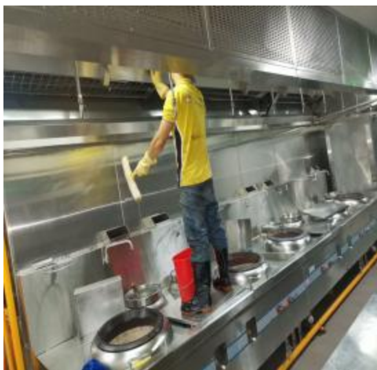
宴会厨房烟罩施工
