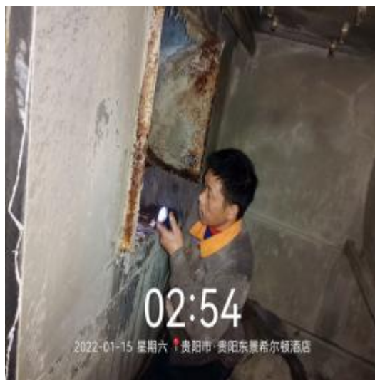
洗衣房管道清洗中 2
