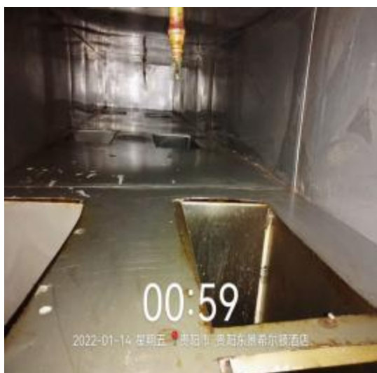
西厨管道清洗中
