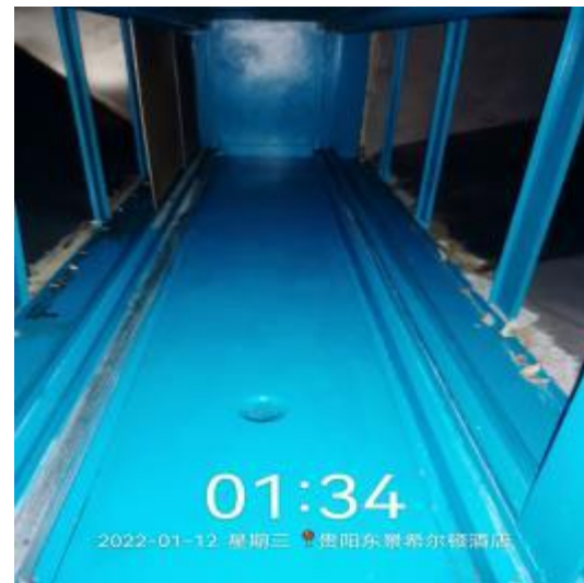
宴会厨房净化器机箱施工中
