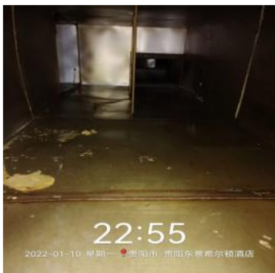
中厨房管道清洗前
