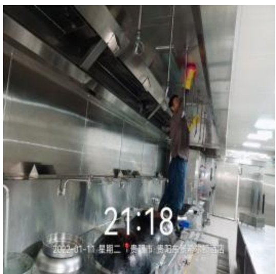
宴会厨房烟罩施工中
