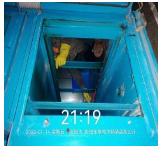
净化器机箱清洗中
