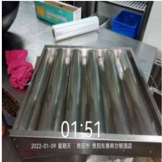
员工厨房防火板清洗后
