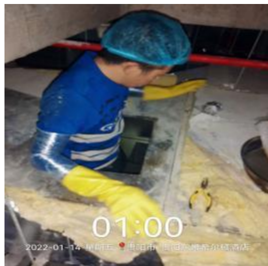
主管道施工中
