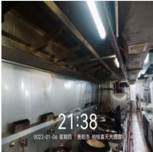
员工厨房烟罩施工中
