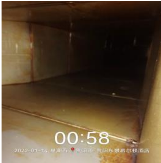
主管道清洗前 2
