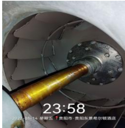
楼顶风机清洗后 1
