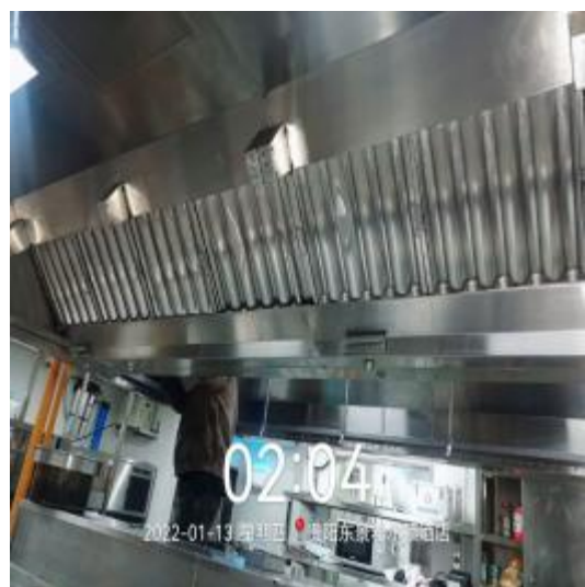
西厨房烟罩清洗后
