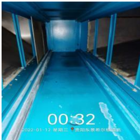
宴会厨房净化器机箱施工中
