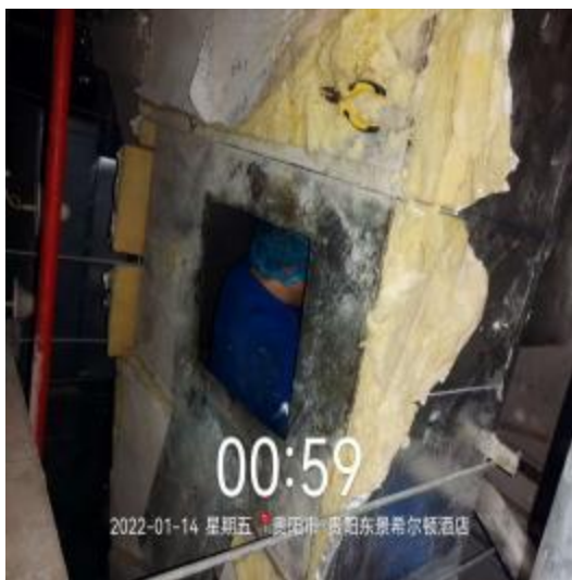
主管道施工中
