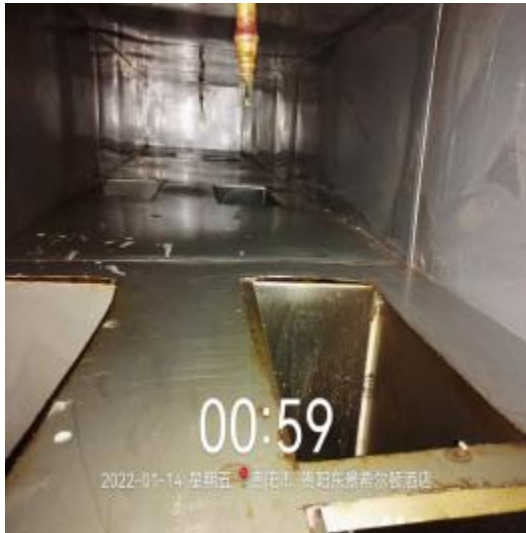
主管道清洗前 1
