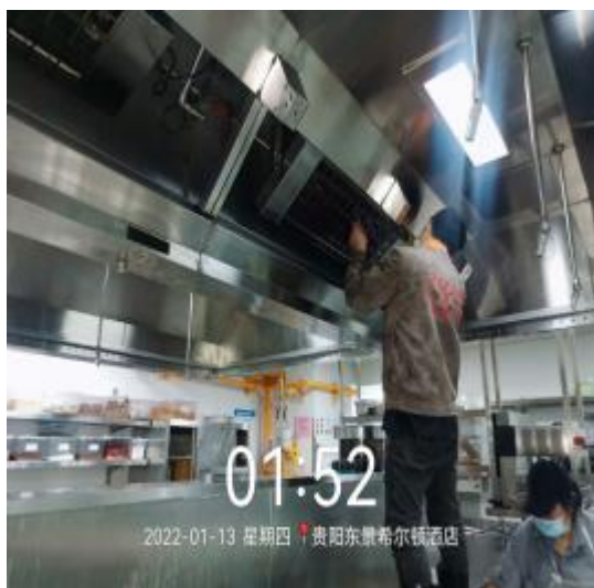
西厨房烟罩施工中
