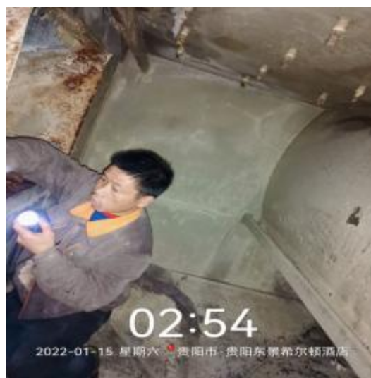
洗衣房管道清洗中
