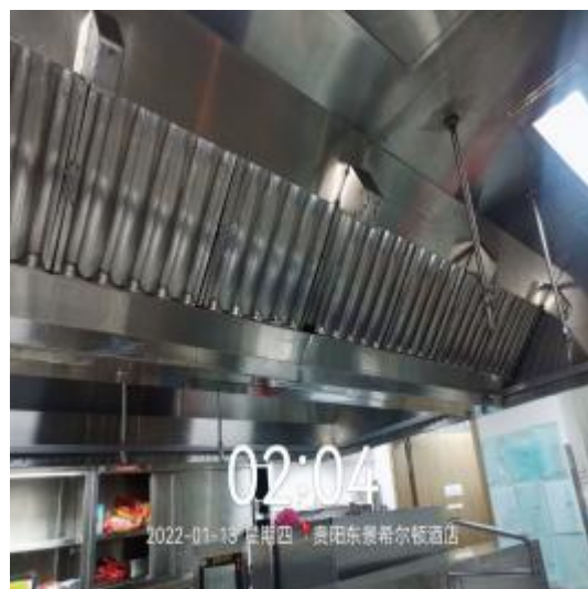
西厨房烟罩清洗后
