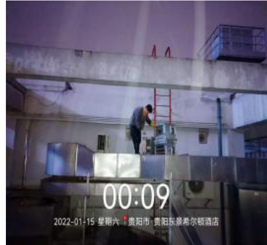
净化器施工中
