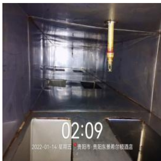
西厨管道清洗后
