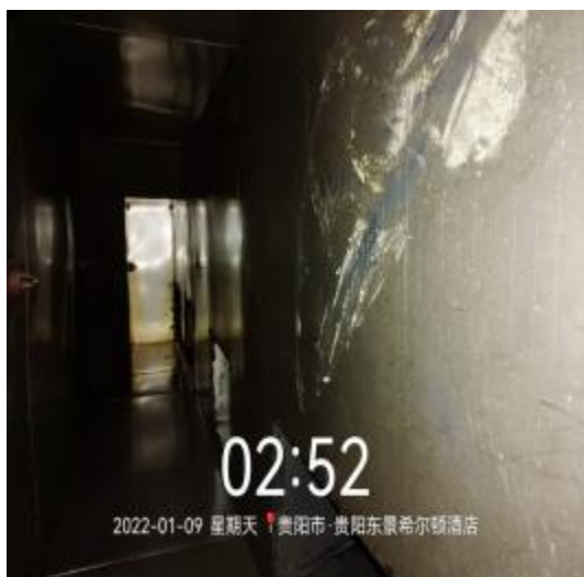
员工厨房管道清洗前
