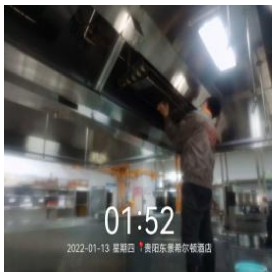
西厨房烟罩施工中
