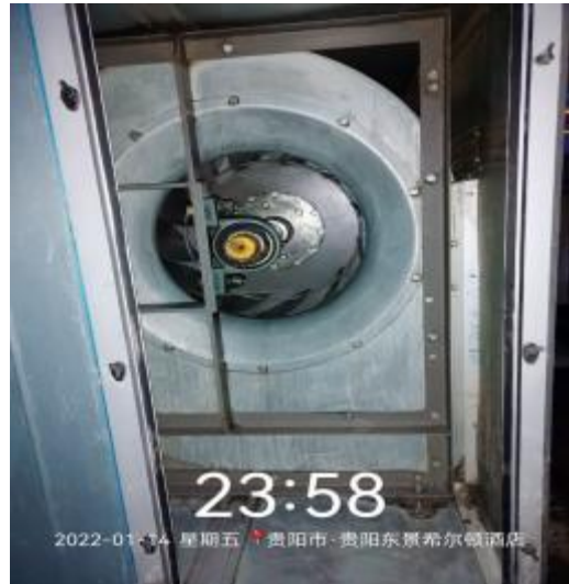
楼顶风机清洗后 2
