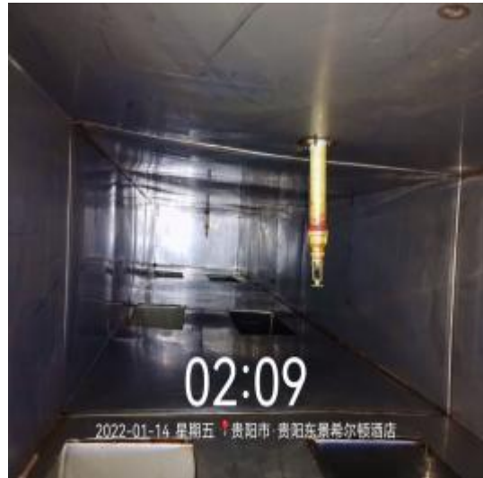
主管道清洗后 1
