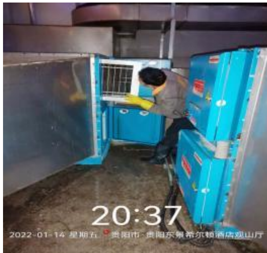
净化器机箱清洗中
