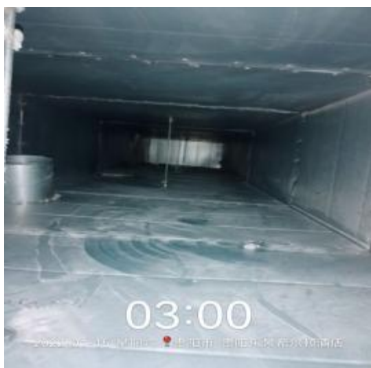
洗衣房管道清洗中 3
