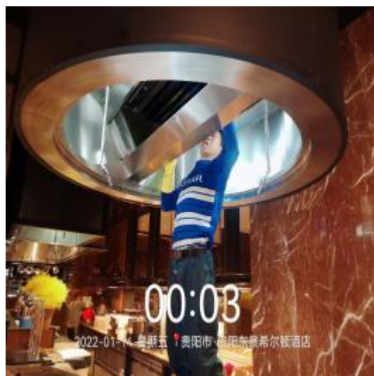
西厨明档烟罩清洗中
