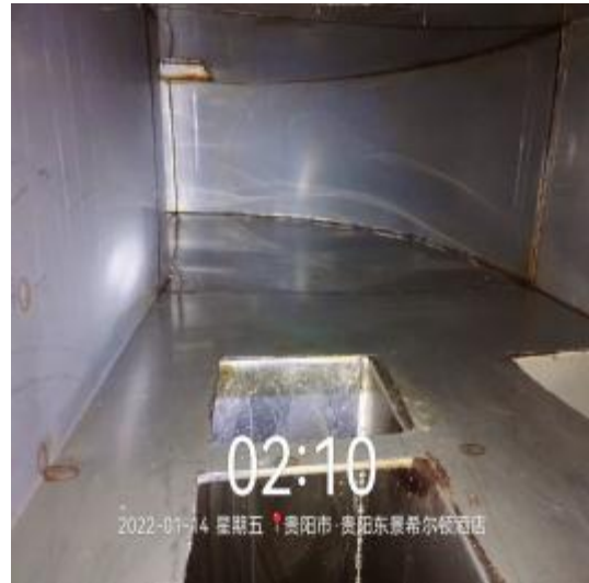
主管道清洗后 2
