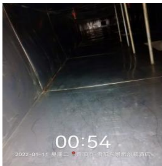
中厨房管道清洗后
