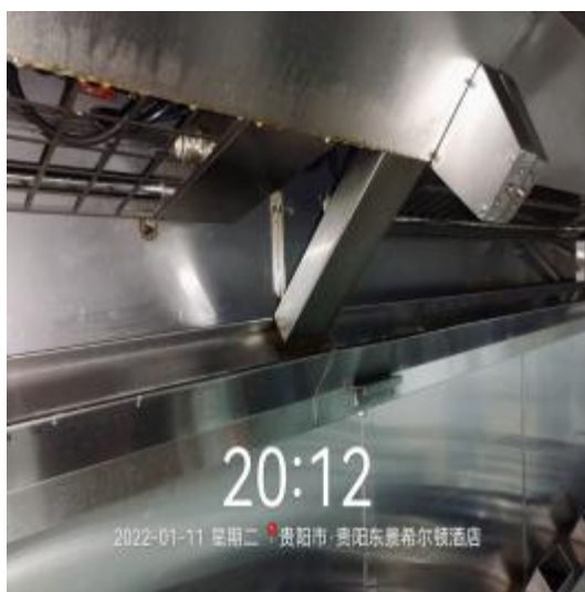
宴会厨房烟罩清洗前 1
