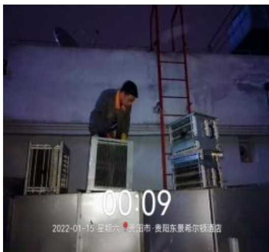
净化器施工中
