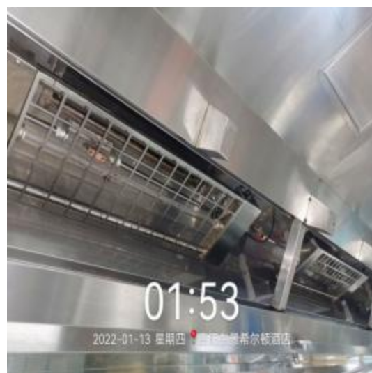
西厨房烟罩清洗后
