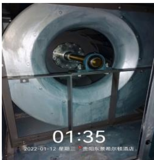
宴会厨房风机清洗后
