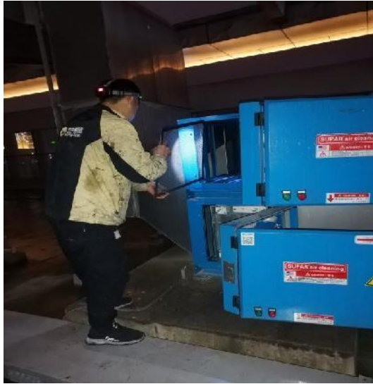
顶楼净化器施工中
