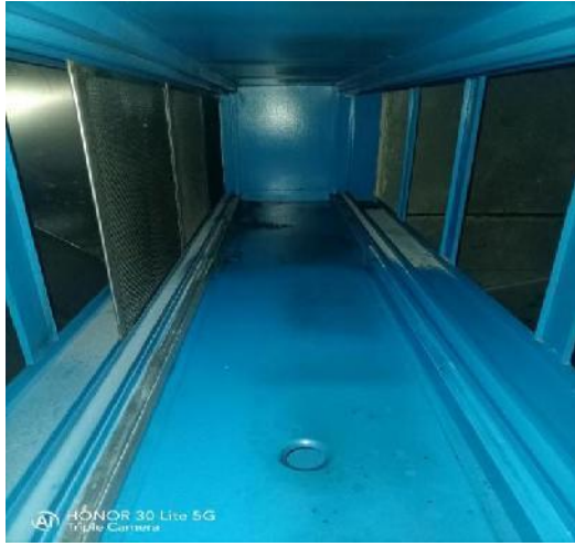
宴会厨房净化器机箱清洗前
