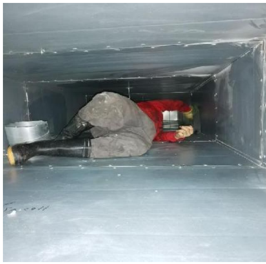
洗衣房管道清洗中 3
