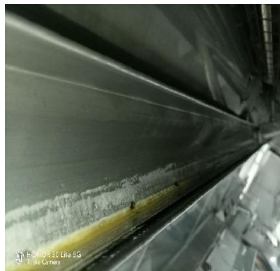
宴会厨房烟罩清洗前 2
