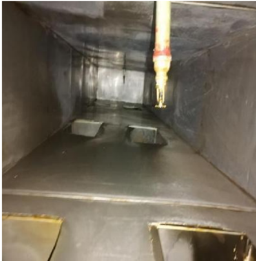
西厨房管道清洗前
