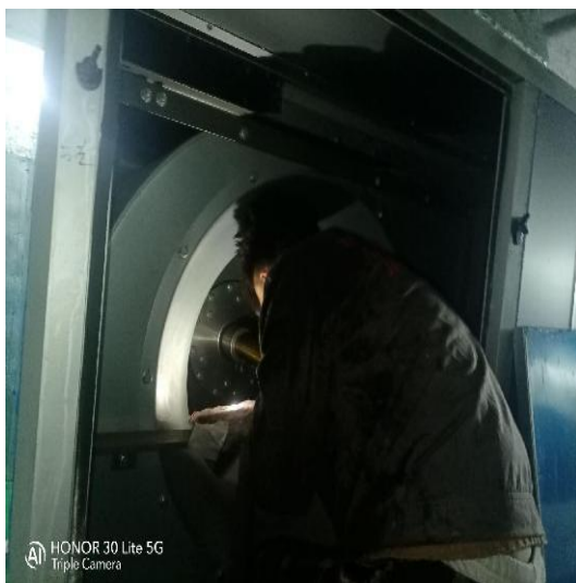
宴会厨房风机清洗后
