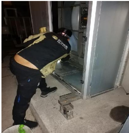
楼顶风机施工中
