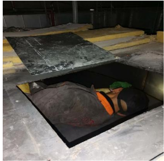
西厨房管道施工中
