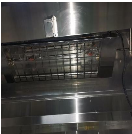
西厨房烟罩清洗后
