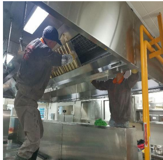
西厨房烟罩清洗中
