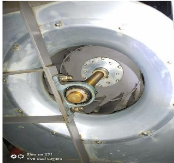
楼顶风机清洗后 1
