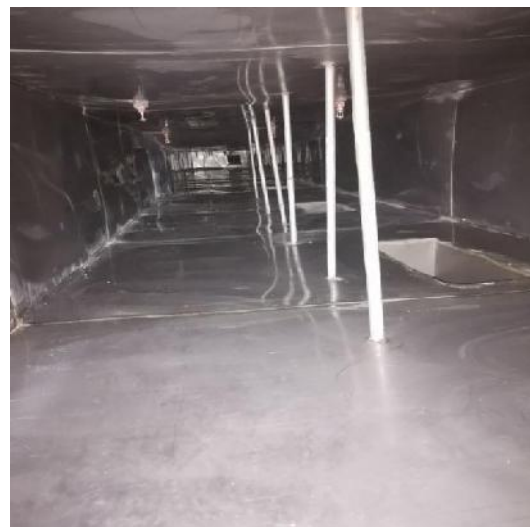
中厨房管道清洗后
