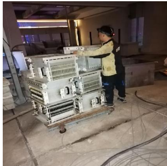
顶楼净化器施工中
