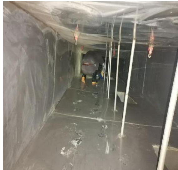
中厨房管道清洗中
