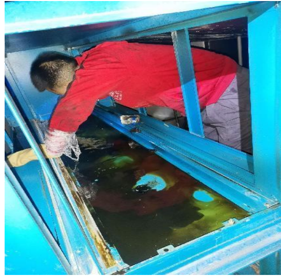
顶楼净化器施工中
