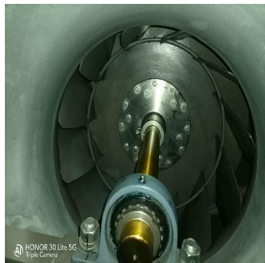
宴会厨房风机清洗后
