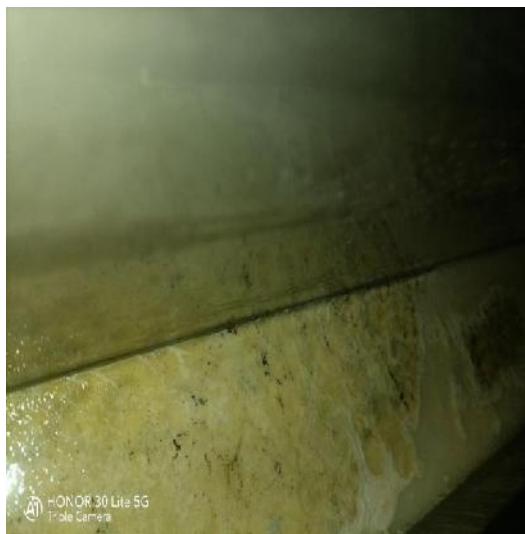
宴会厨房烟罩清洗前 1
