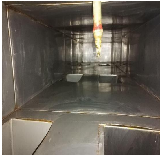
西厨房管道清洗后
