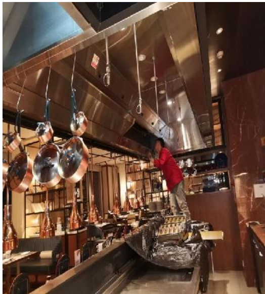
明档烟罩施工中
