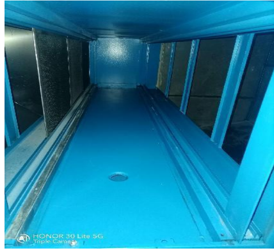
宴会厨房净化器机箱清洗后
