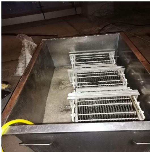
顶楼净化器施工中
