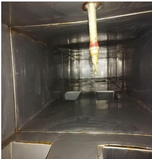
西厨房管道清洗后
