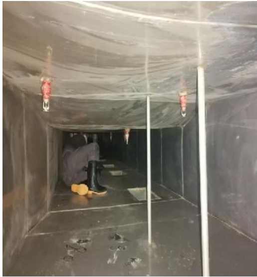
中厨房管道清洗前
