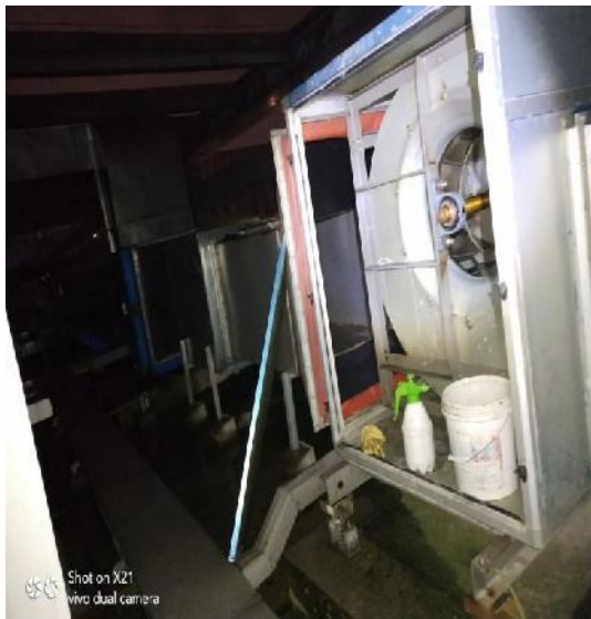
楼顶风机施工中
