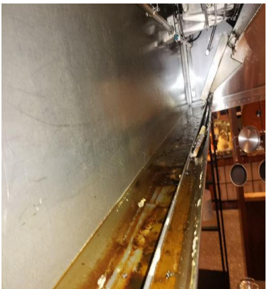
明档烟罩施工中
