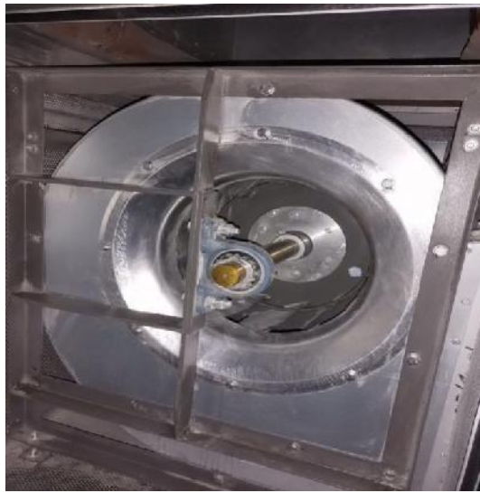
楼顶风机清洗后 2
