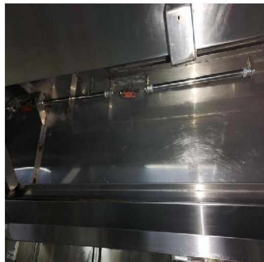
西厨房烟罩清洗后
