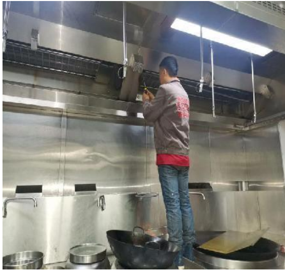
员工厨房烟罩施工中
