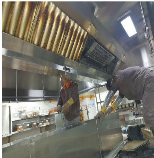
西厨房烟罩清洗中
