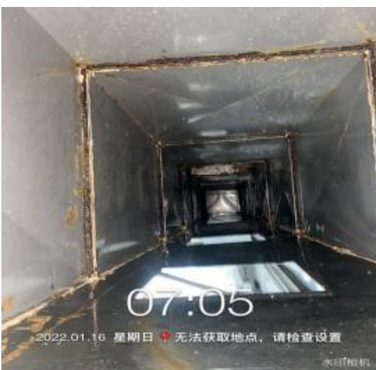
四楼管道清洗后
