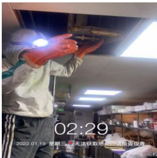
净化器施工中
