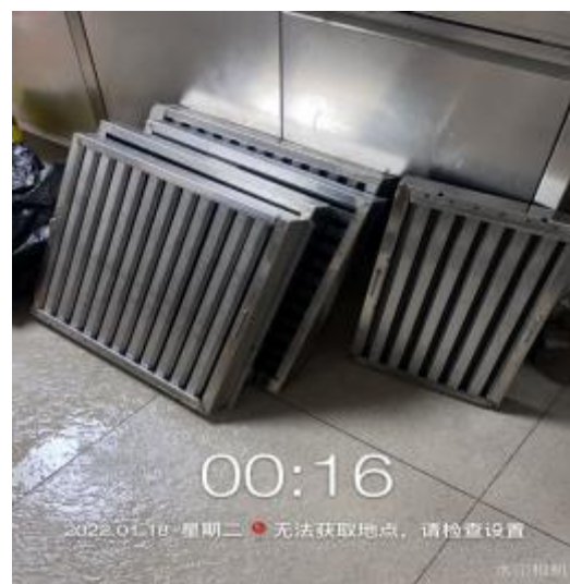
一楼明档防火板清洗后
