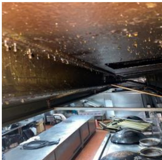
四楼中厨烟罩清洗前
