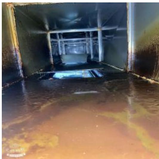
员工厨房管道清洗前
