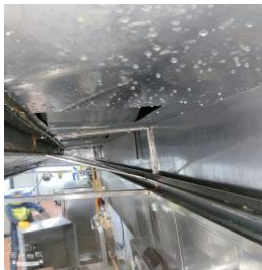
员工厨房烟罩清洗中
