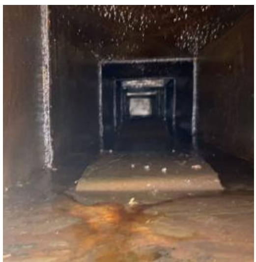
四楼管道清洗前
