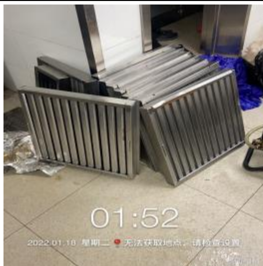
六楼挡板清洗后
