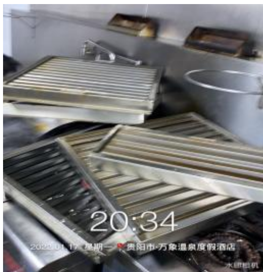
一楼西厨防火板道清洗后
