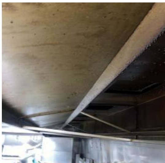
四楼中厨烟罩清洗前
