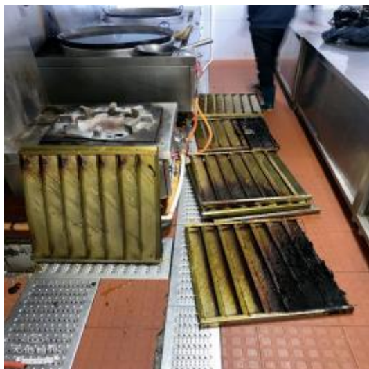
员工厨房防火板清洗前
