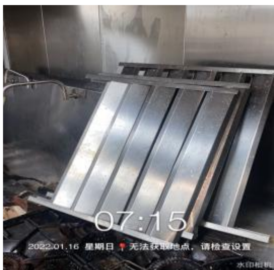
四楼中厨防火板清洗后
