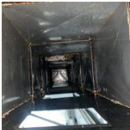
四楼管道清洗后
