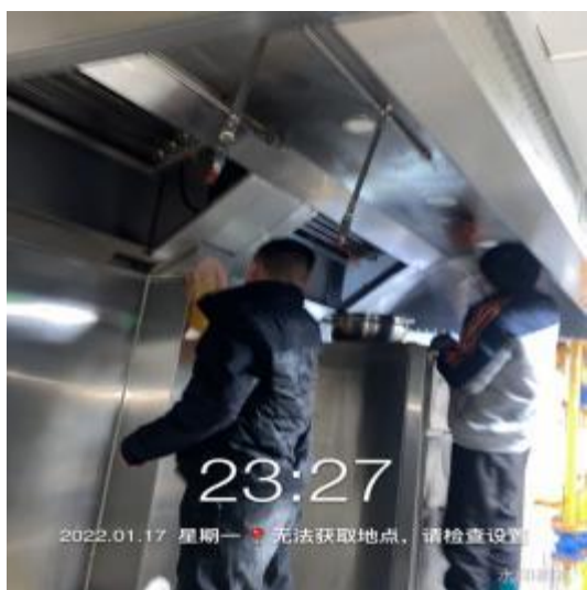
一楼西厨房烟罩清洗中
