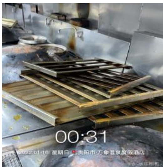
四楼中厨防火板清洗中
