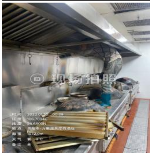
四楼中厨烟罩清洗中
