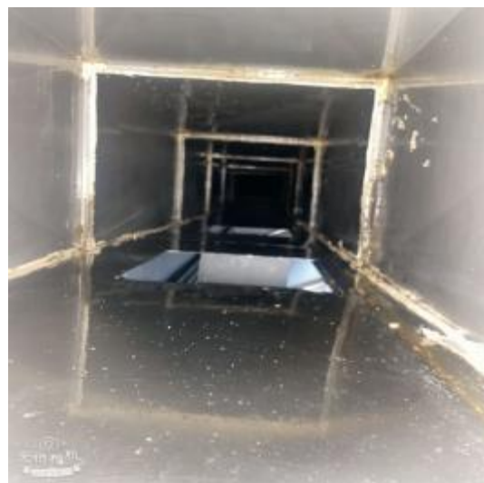
员工厨房管道清洗后
