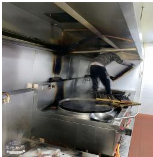
员工厨房烟罩施工中
