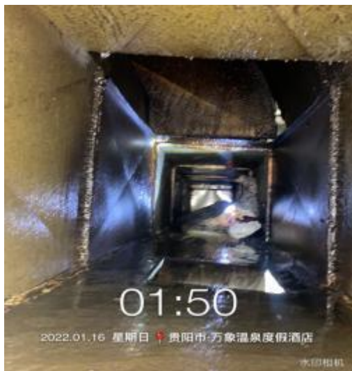
四楼管道清洗中
