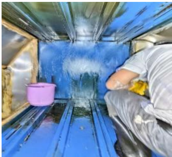
净化器机箱施工中
