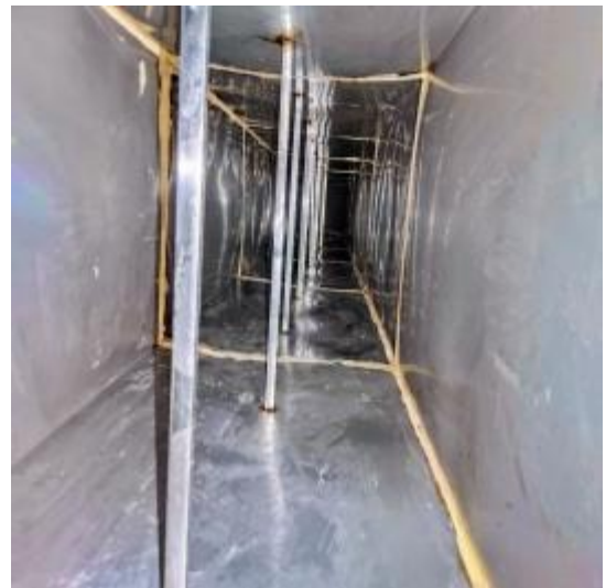
中厨房管道清洗前 2
