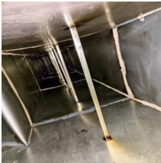
中厨房管道清洗前 2
