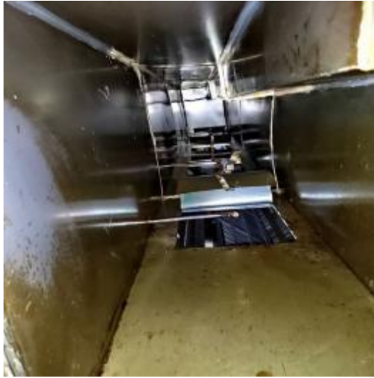
中厨房管道清洗前 1
