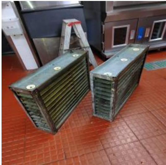
净化器施工中
