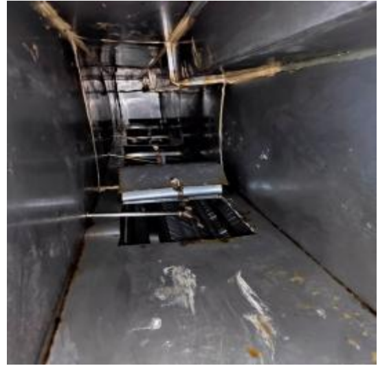
中厨房管道清洗后 1
