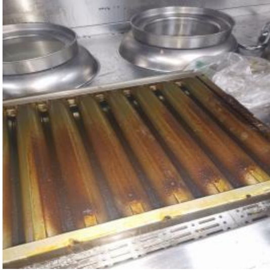
中厨房防火板清洗前
