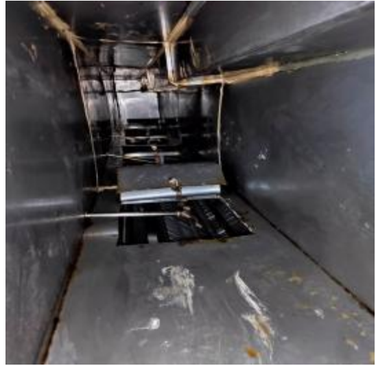
中厨房管道清洗后 1
