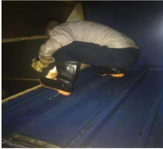
净化器机箱施工中
