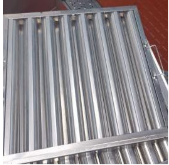
中厨房防火板清洗后
