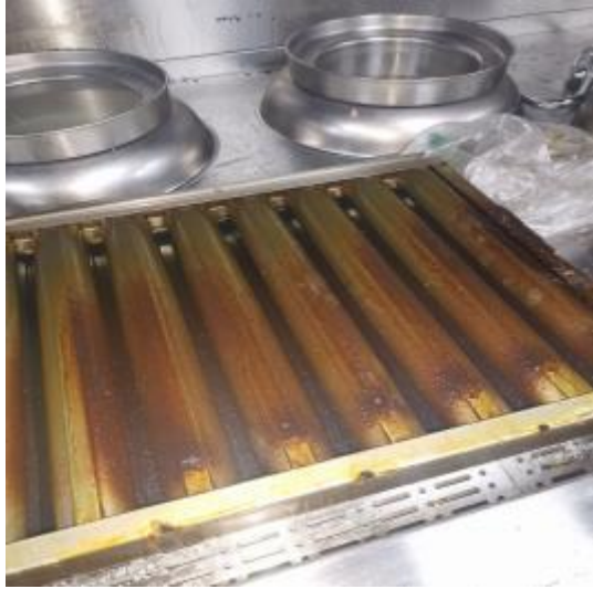
中厨房防火板清洗前
