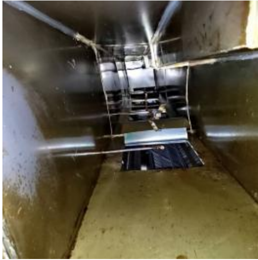
中厨房管道清洗前 1
