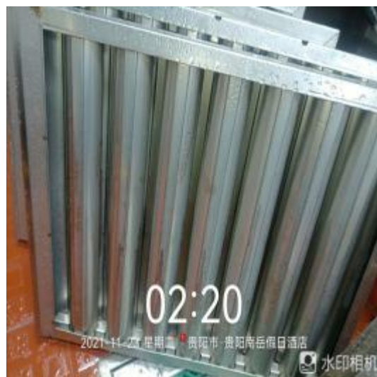
中厨房防火板清洗后
