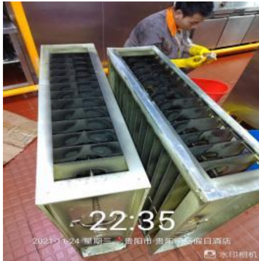
净化器施工中
