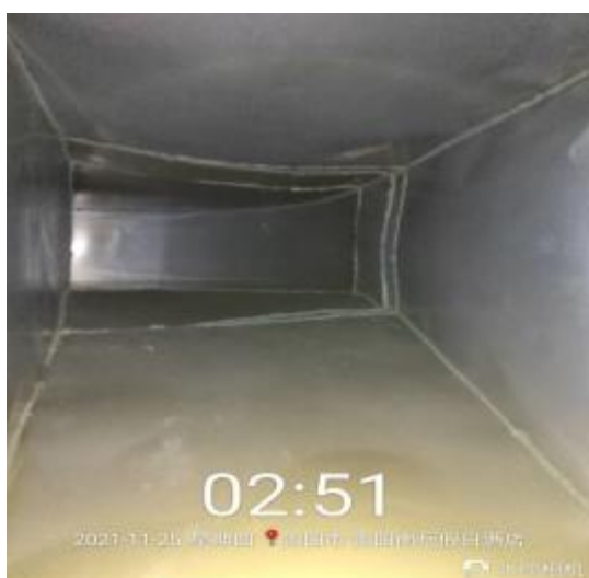
主管道清洗前
