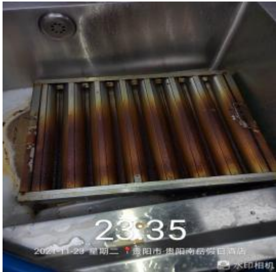
明档防火板清洗前
