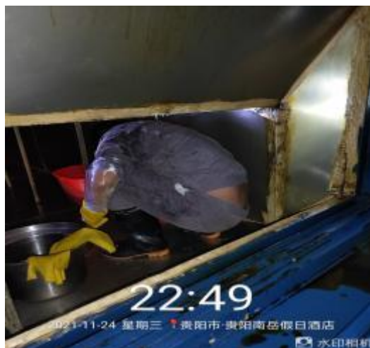
净化器管道施工中
