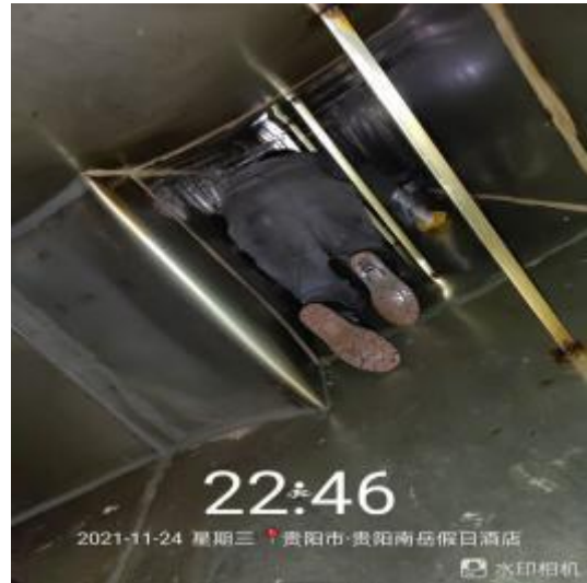
中厨房管道施工中
