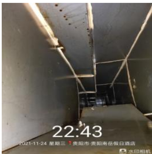
中厨房管道清洗前 1
