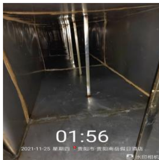
中厨房管道清洗后 2
