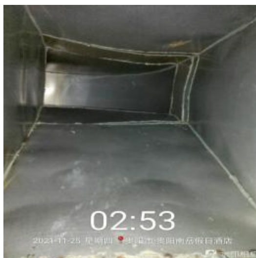
主管道清洗后
