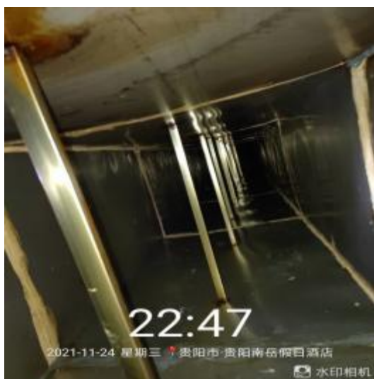
中厨房管道清洗前 2
