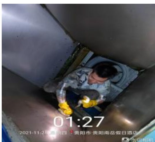
风机管道施工中
