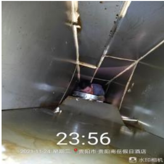
中厨房管道施工中
