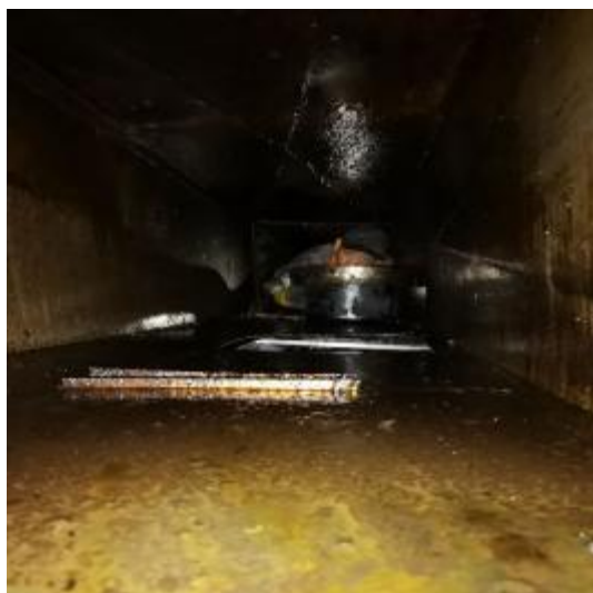
管道施工后中
