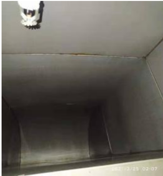
6楼平台竖管清洗后
