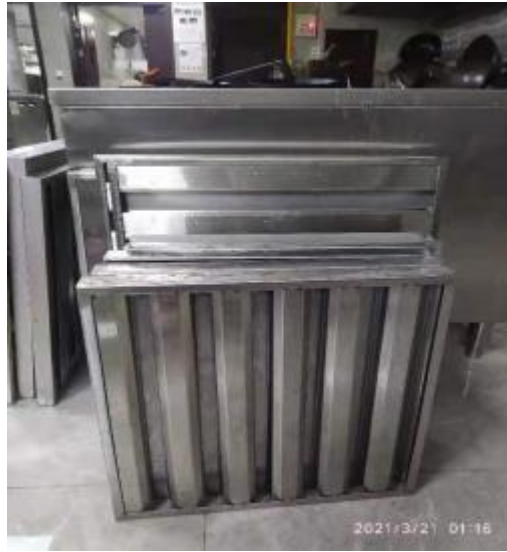
5楼面点间防火板清洗后
