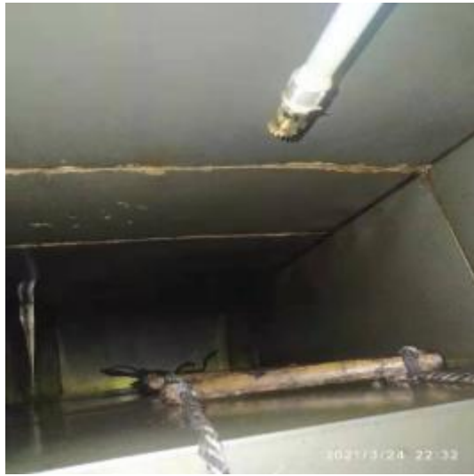
6楼平台竖管施工中
