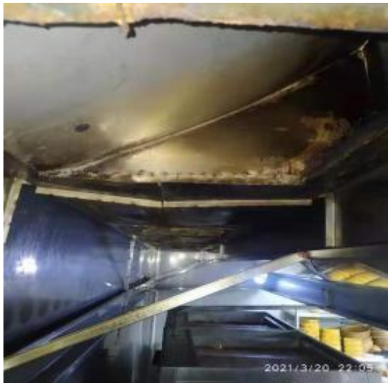
5楼烧腊厨房清洗前
