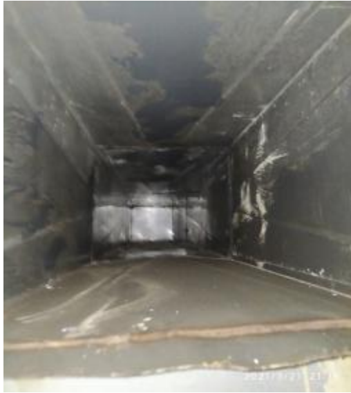
4楼管道清洗前
