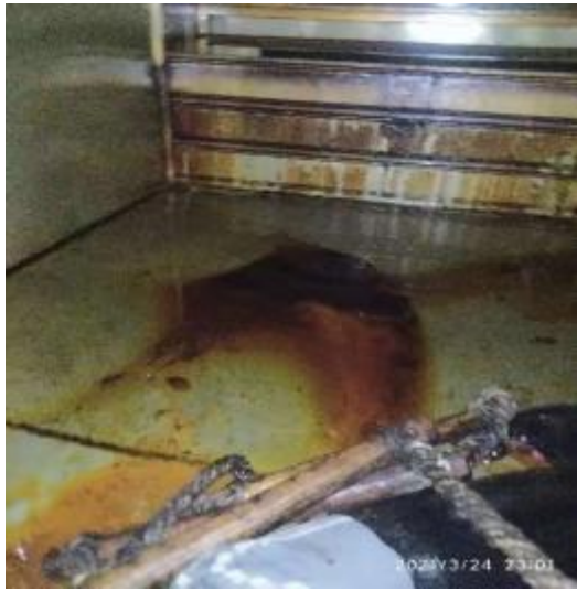
6楼平台竖管施工中
