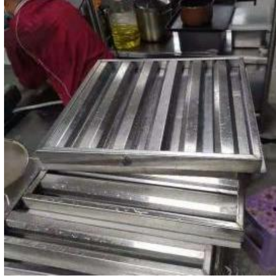
3楼员工厨房防火板清洗后
