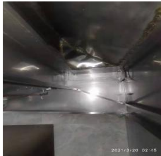
5 楼中厨房烟罩清洗后 2
