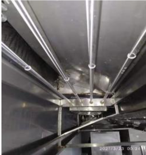
2楼宴会厨房烟罩清洗后
