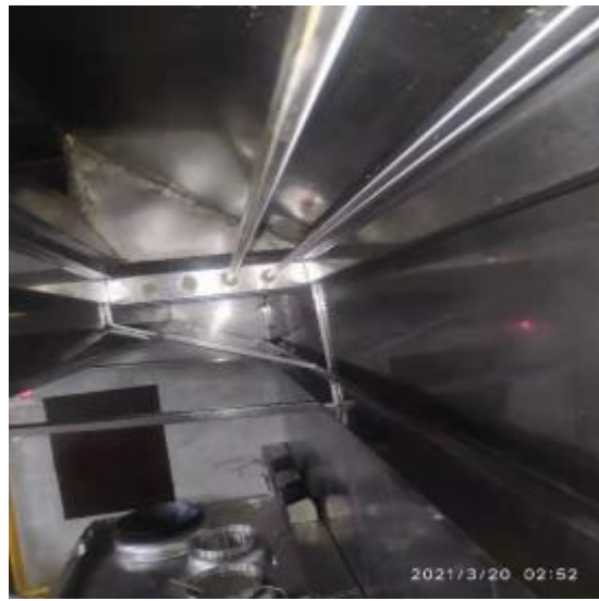
5 楼中厨房烟罩清洗后 1
