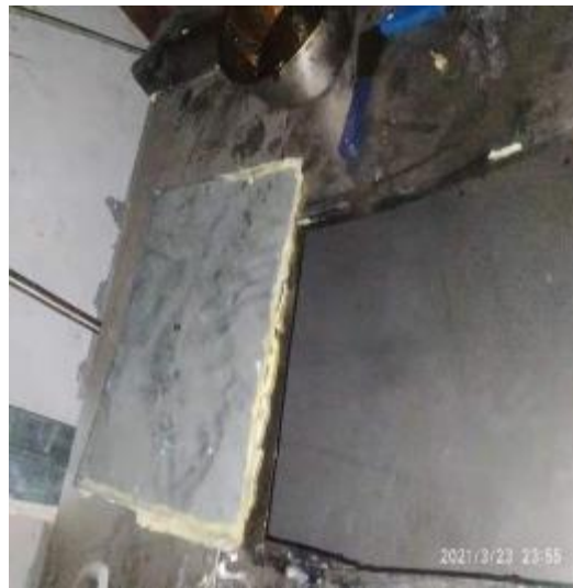
5楼管道施工中
