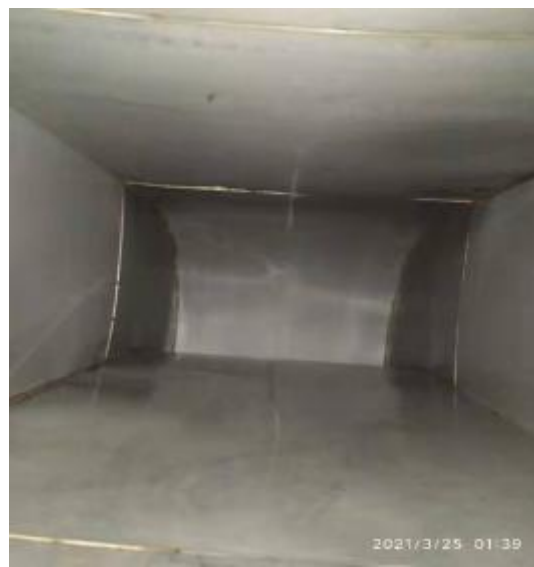
6楼平台竖管清洗后
