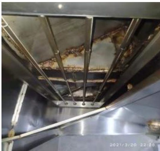
5楼面点间烟罩清洗前
