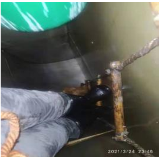
六楼平台竖管施工中
