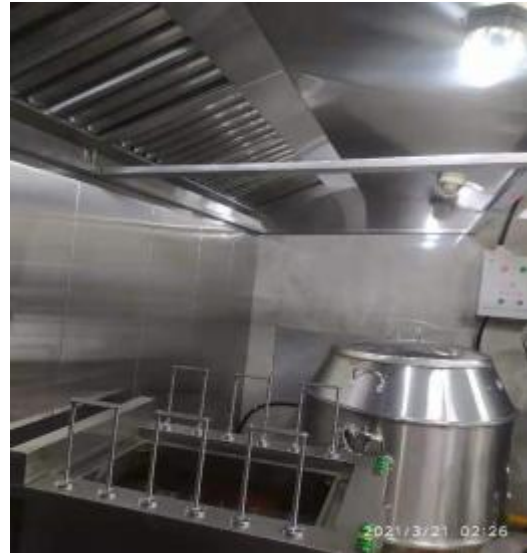
5楼烧腊厨房清洗后
