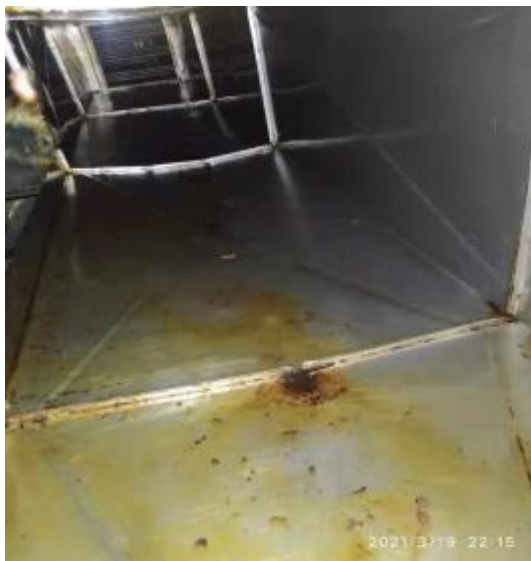
5 楼中厨房管道清洗前 1
