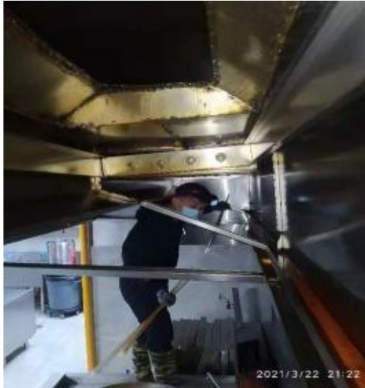
3楼员工厨房烟罩清洗中
