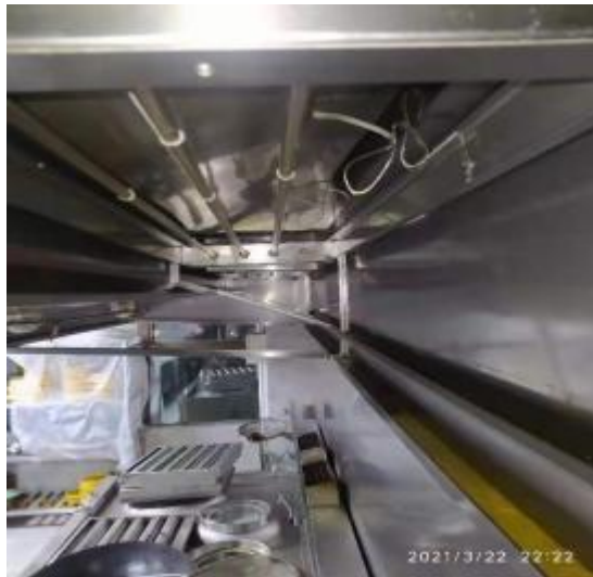
2楼宴会厨房清洗后
