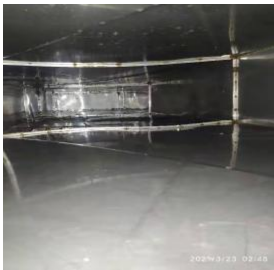
3楼员工厨房管道清洗后
