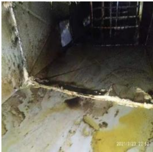
5楼管道清洗前1
