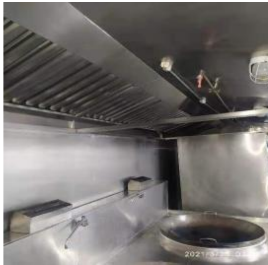
2楼宴会厨房烟罩清洗后
