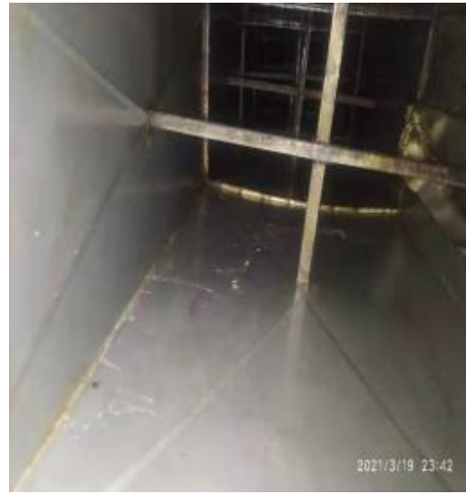
5楼厨房管道清洗后
