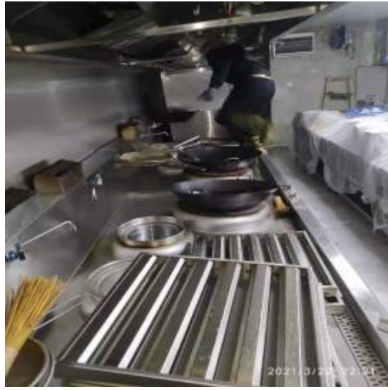
2楼宴会厨房烟罩清洗中
