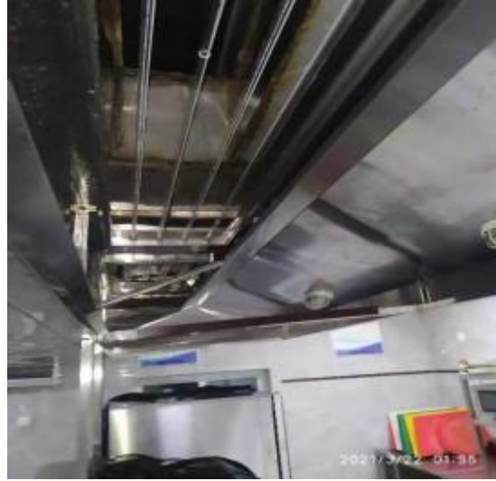
4楼西厨房烟罩清洗后
