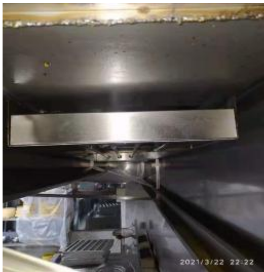
2楼宴会厨房清洗前
