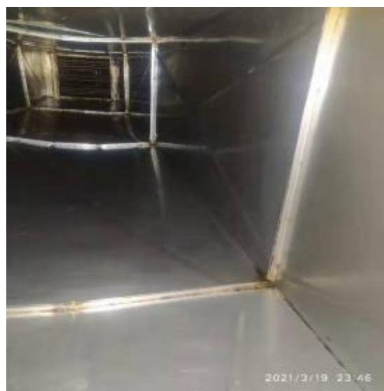
5 楼中厨房管道清洗后 1
