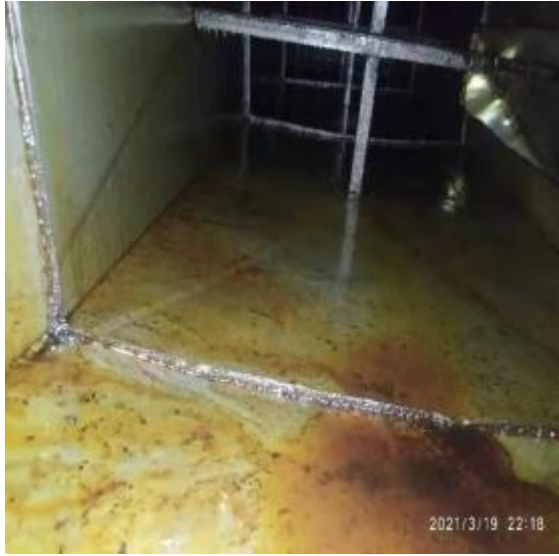
5楼厨房管道清洗前 2
