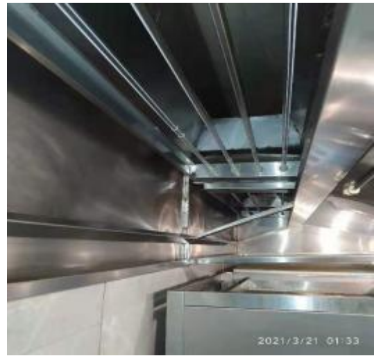
5楼面点间烟罩清洗后
