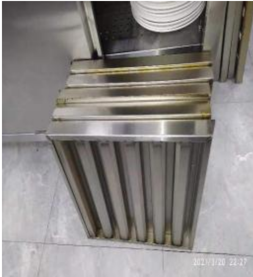
5楼面点间防火板清洗前
