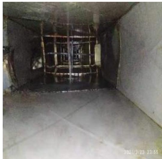
5楼管道清洗后
