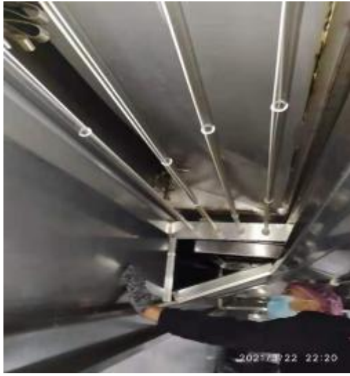
2楼宴会厨房烟罩清洗中
