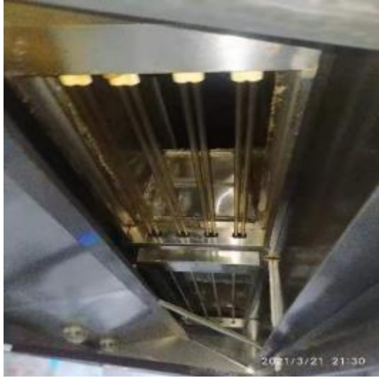
4楼西厨房烟罩清洗前
