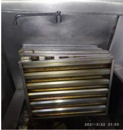
3楼员工厨房防火板清洗前
