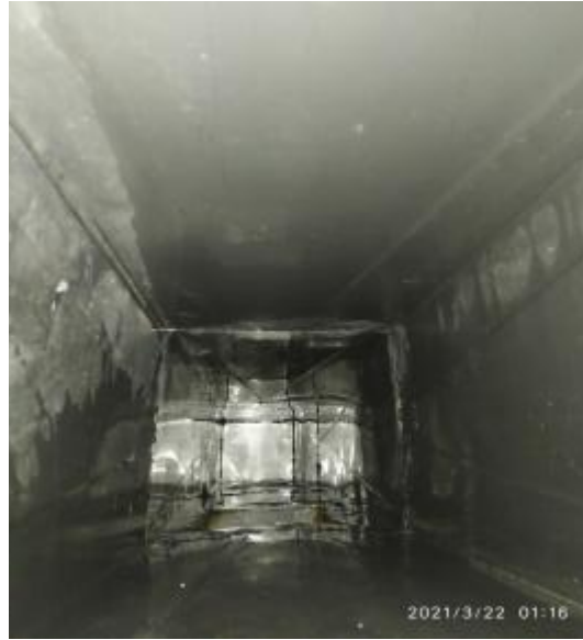
4楼管道清洗后
