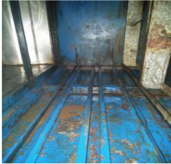
净化器内部清洗后
