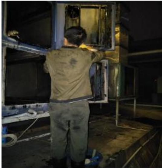
净化器内部施工
