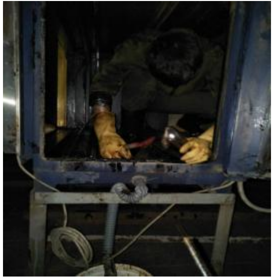
净化器内部施工
