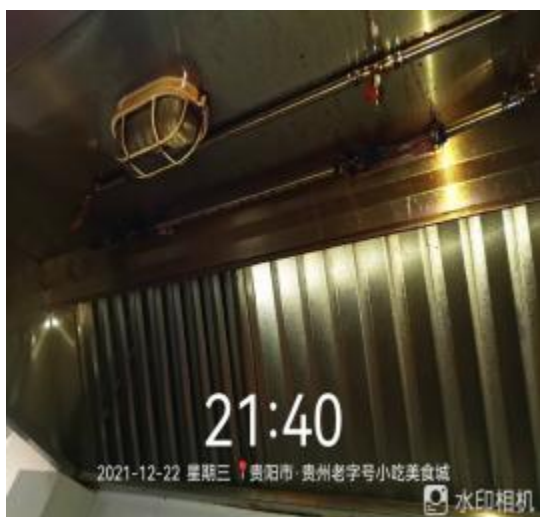
防火板清洗前
