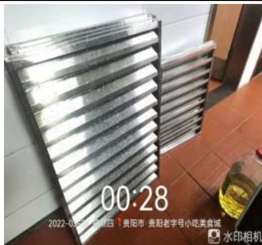
防火板清洗后
