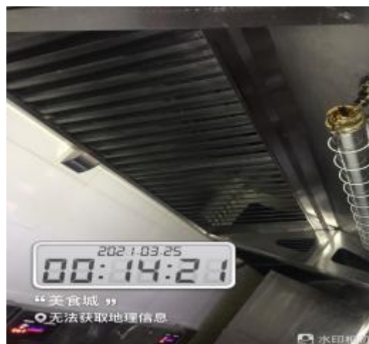
整体 烟罩施工中
