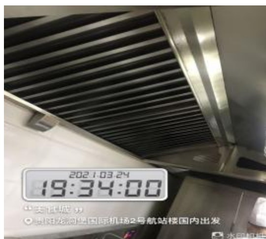
整体罩施工中
