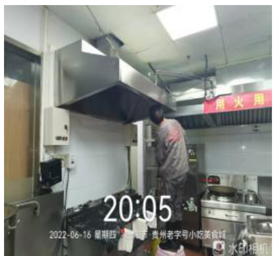
整体罩施工中
