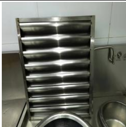
防火板清洗后
