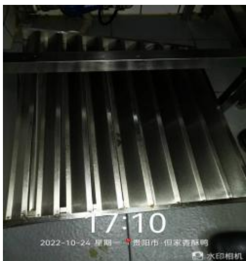
防火板清洗前
