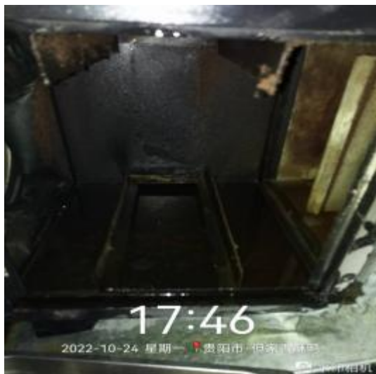
净化器机箱清洗前
