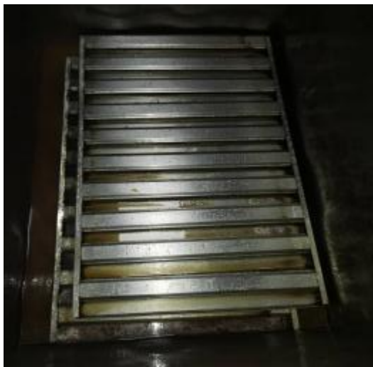
防火板清洗前
