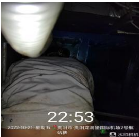
净化器机箱施工中
