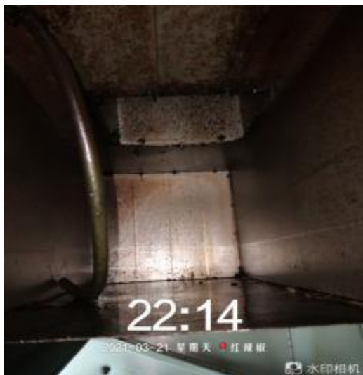
防火板清洗前
