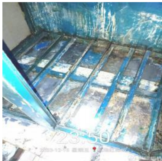
净化器机箱清洗后
