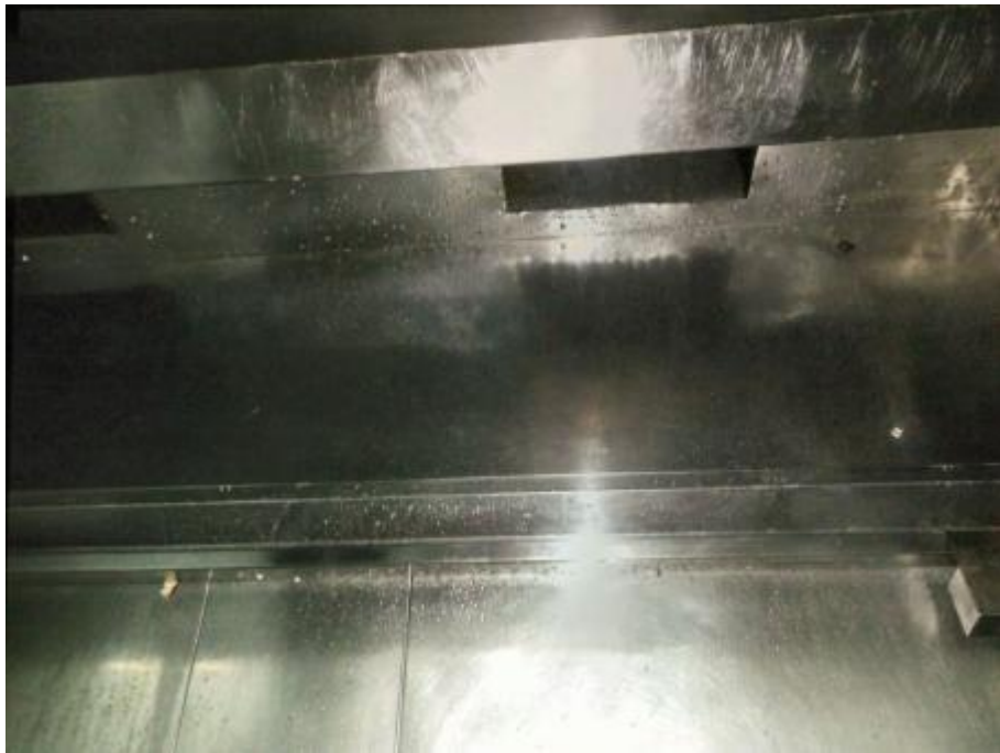
西厨房烟罩清洗后
