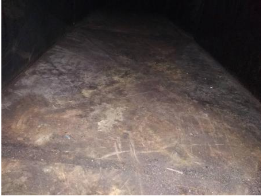
主管道施工后
