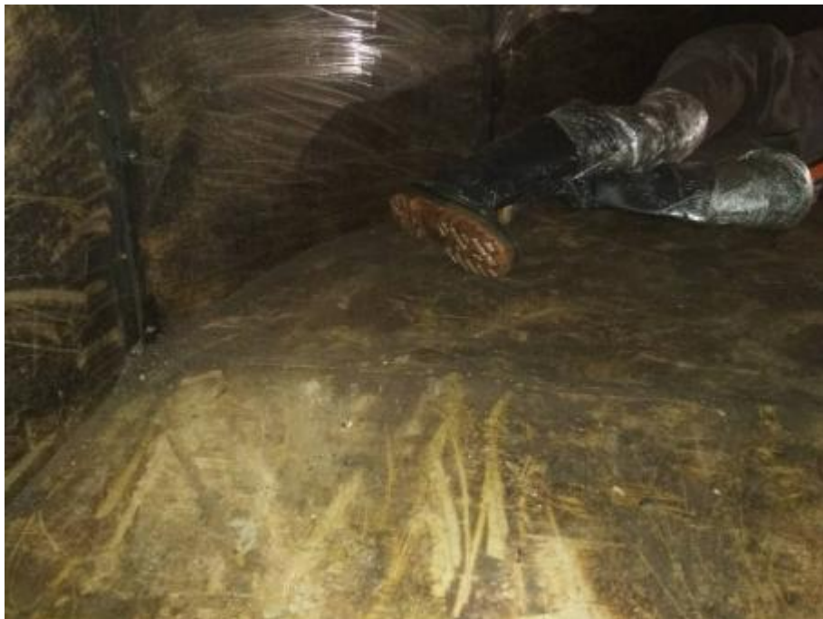
主管道施工中
