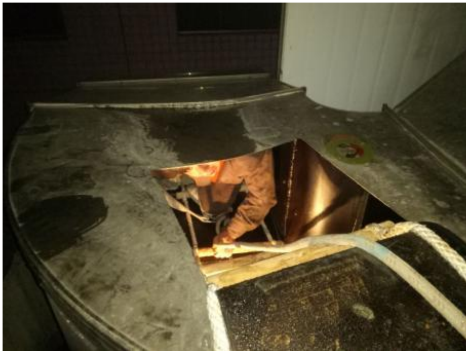
垂直管道施工 1
