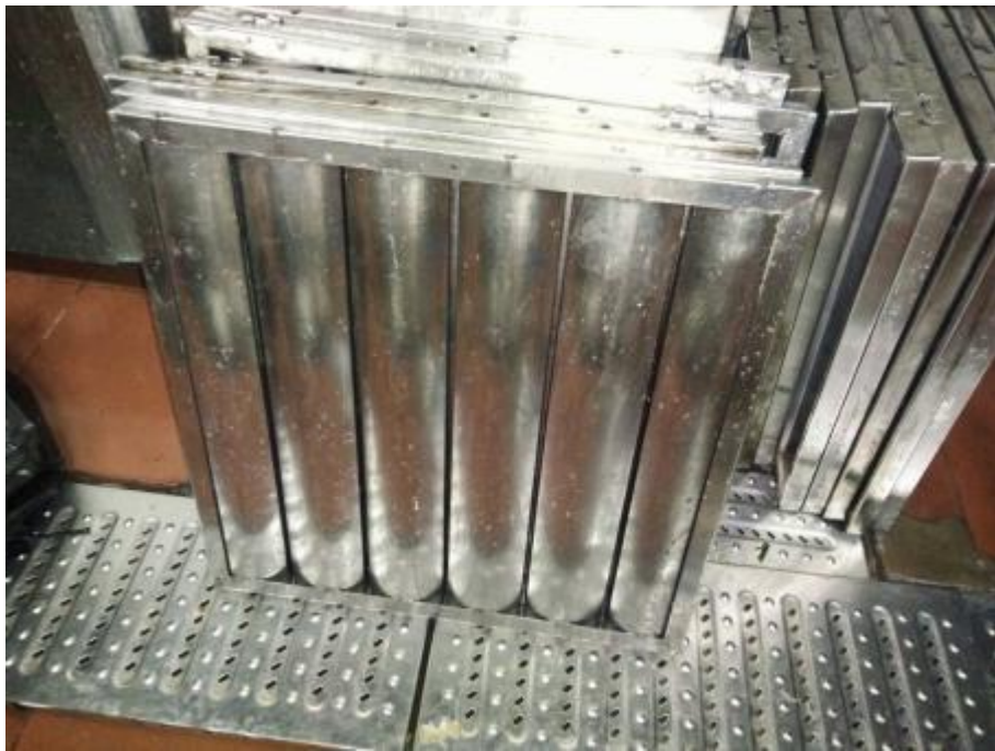
西厨房挡板清洗后
