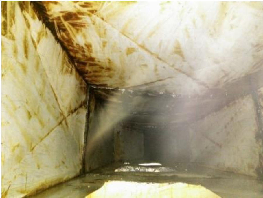
中厨房管道清洗后
