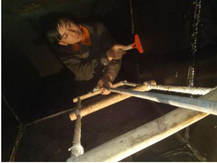
垂直管道施工 2
