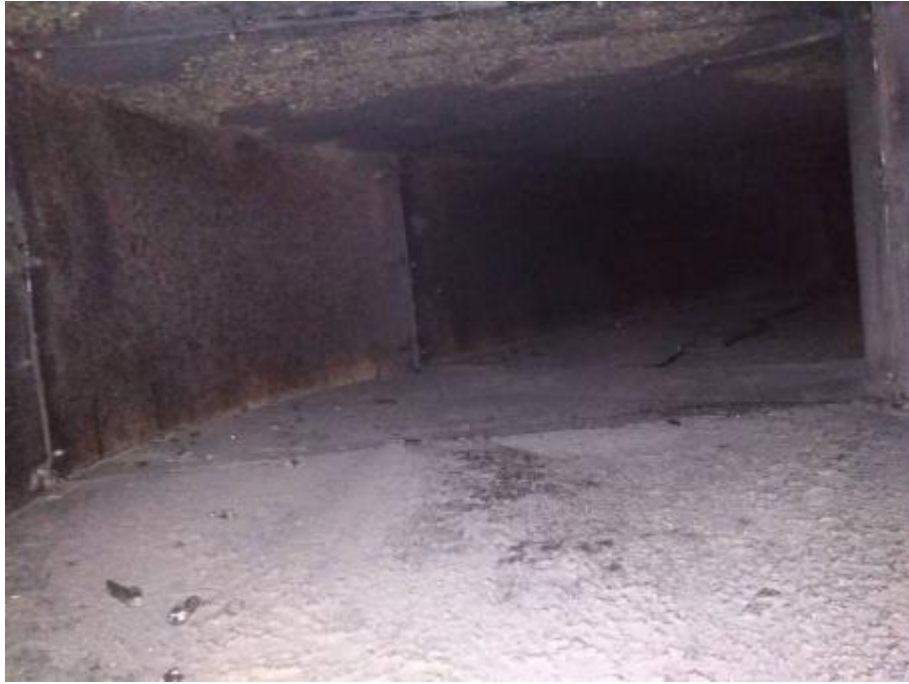
主管道清洗前
