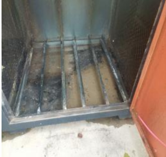
净化器机箱清洗前
