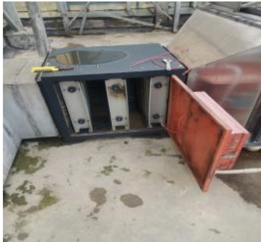
净化器施工中
