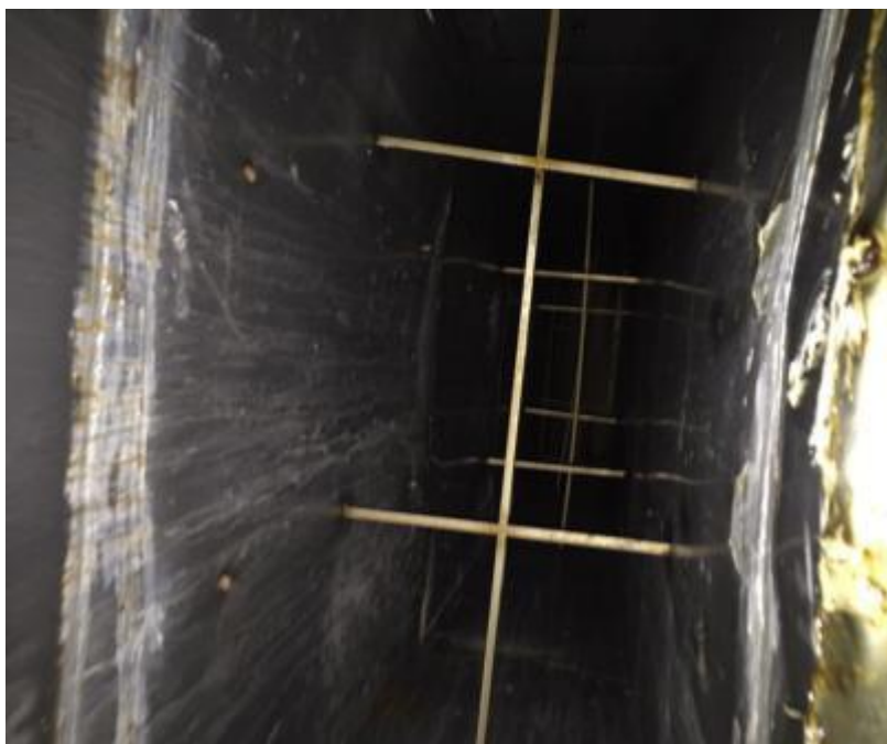
垂直管道清洗前
