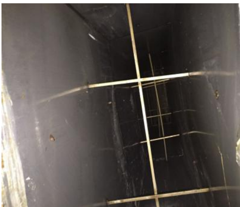
垂直管道清洗后
