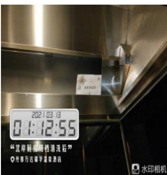
北岸厨房烟罩清洗后
