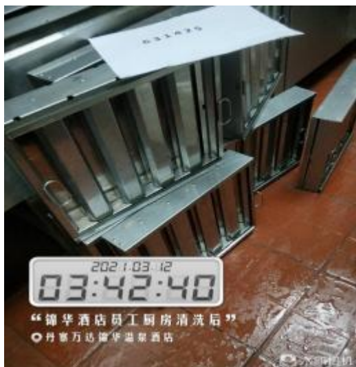
防火板清洗后 1
