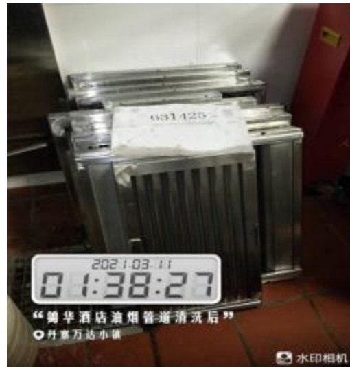
防火板清洗后
