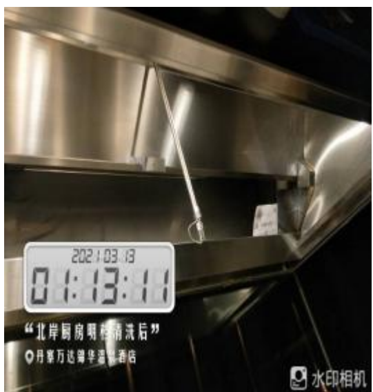
北岸厨房烟罩清洗后
