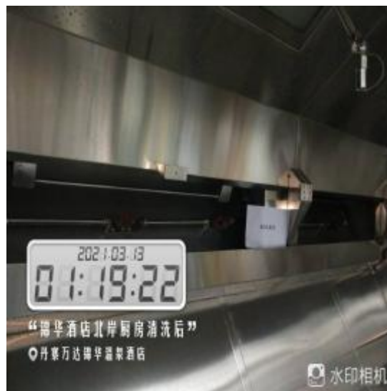
北岸厨房烟罩清洗后
