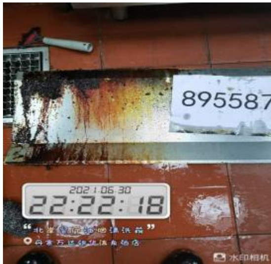
北岸厨房防火板清洗前
