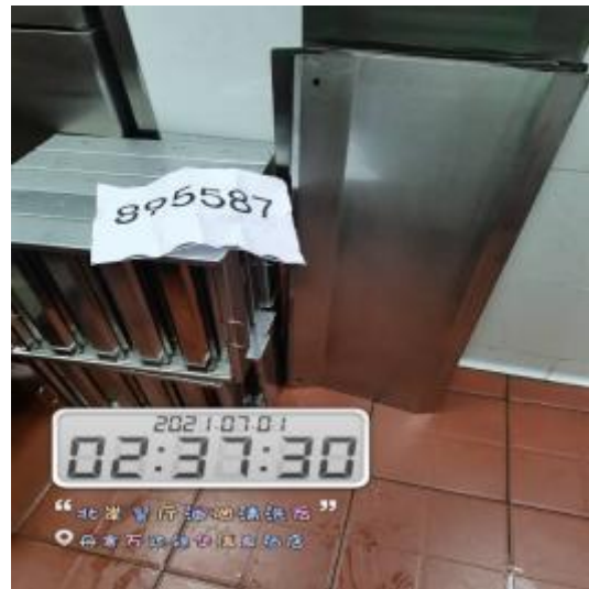
北岸厨房防火板清洗后
