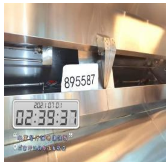
北岸厨房烟罩清洗后 3
