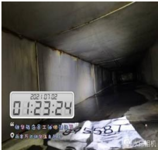
员工厨房管道清洗后
