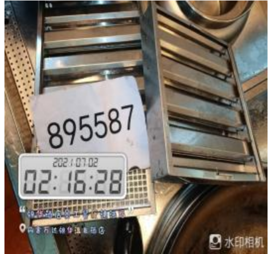
员工厨房防火板清洗后
