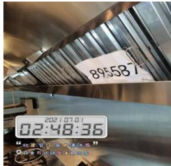
北岸厨房烟罩清洗后 1
