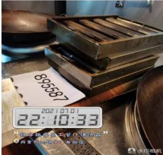
员工厨房防火板清洗前
