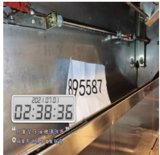
北岸厨房烟罩清洗后 2
