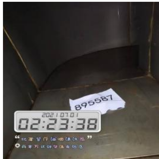
北岸厨房管道清洗后
