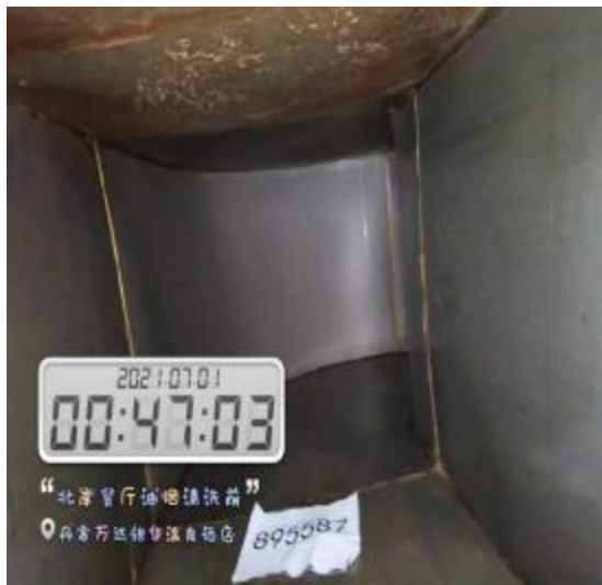
北岸厨房管道清洗前
