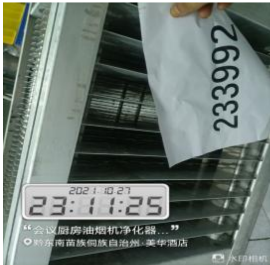
会议厨房净化器清洗中
