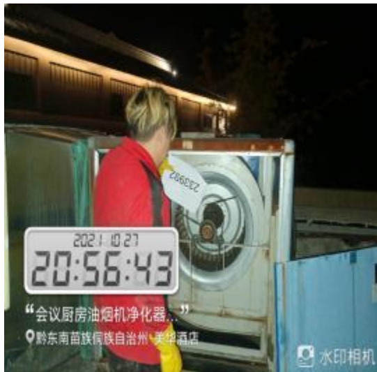
室外排风机清洗后
