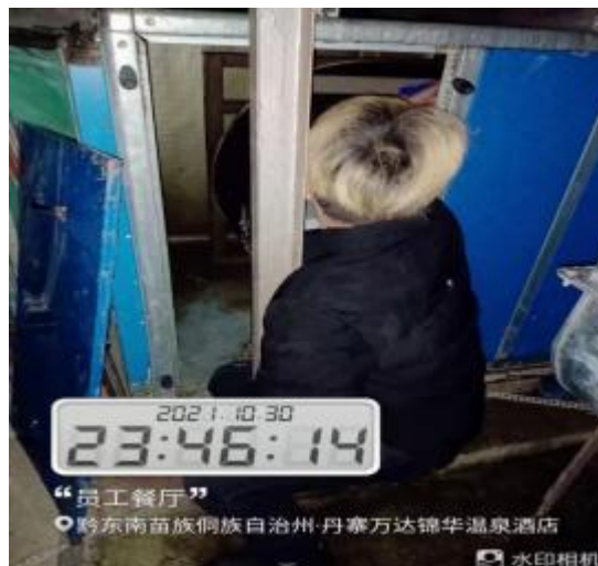
员工厨房室外排风机清洗中
