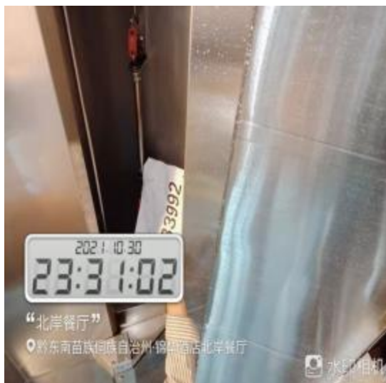
西厨房烟罩清洗后
