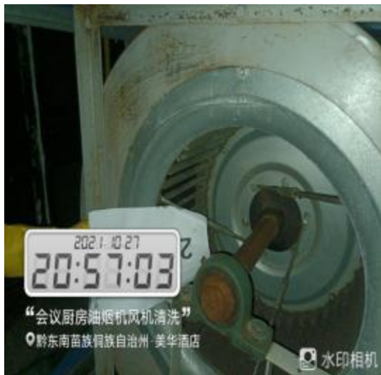
室外排风机清洗后
