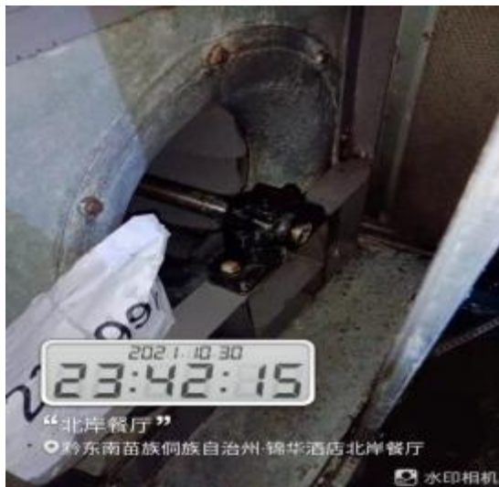
西厨房室外排风机施工中
