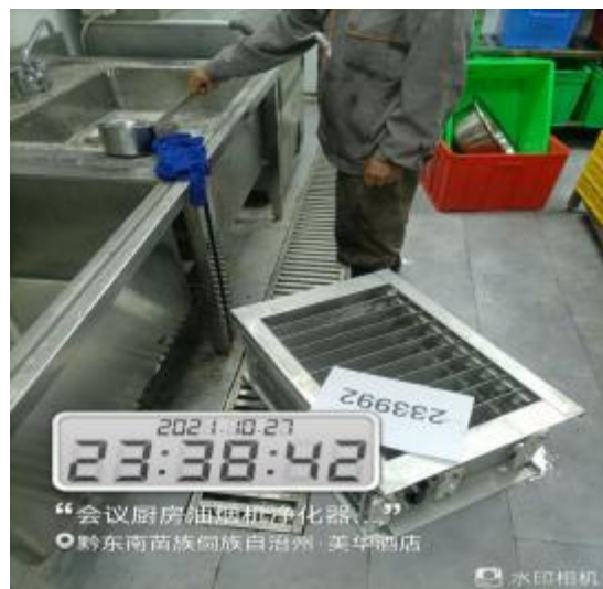
会议厨房管道清洗中
