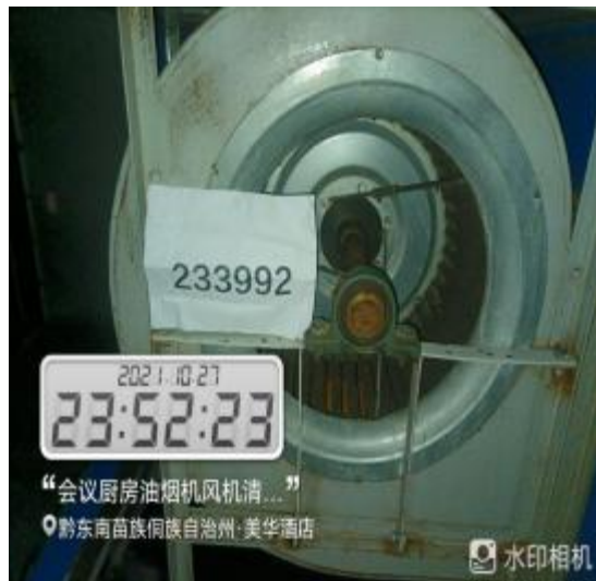
室外排风机清洗后
