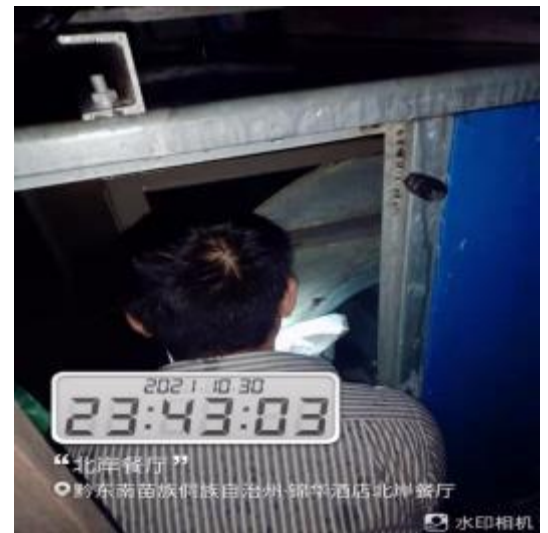
西厨房室外排风机清洗后
