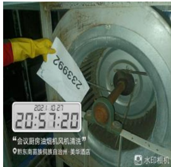
室外风机清洗中
