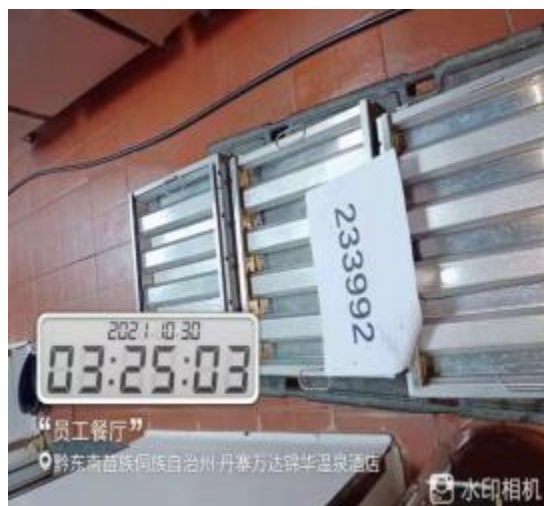
员工厨房防火板清洗后
