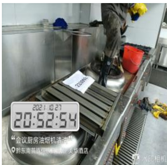
会议厨房烟罩清洗中
